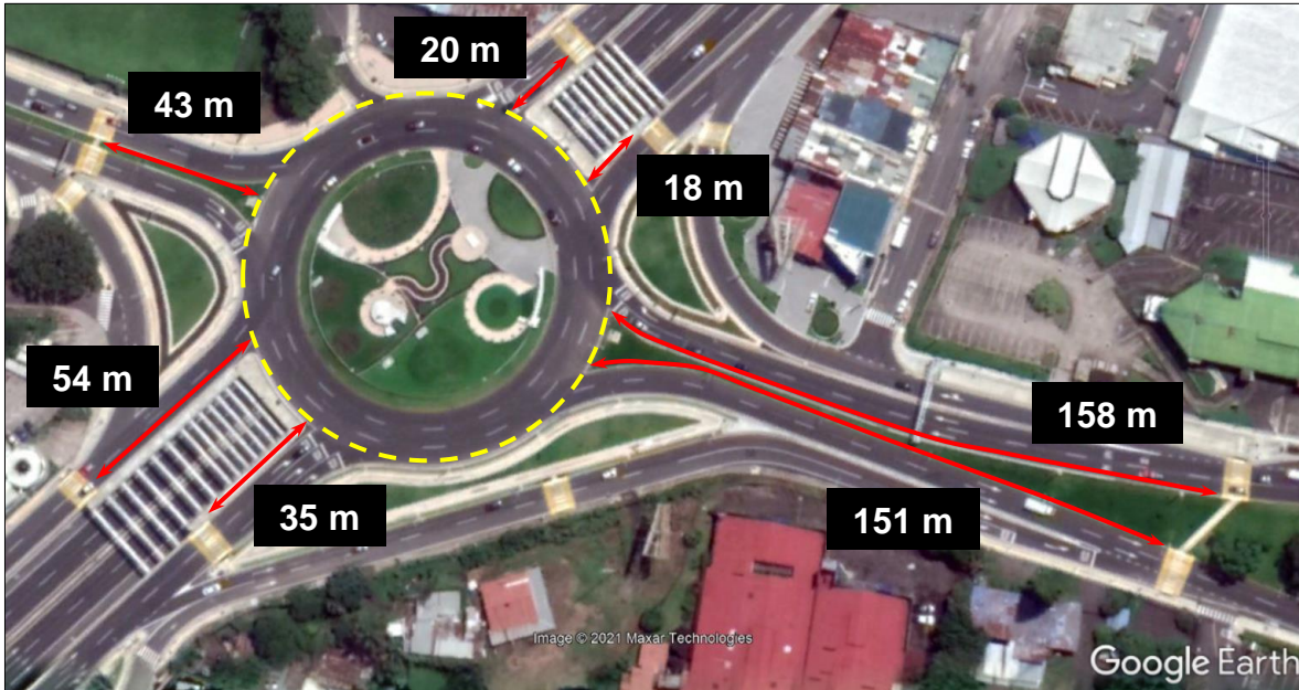
Figura 7. Distancias de pasos peatonales de acera continua a circunferencia externa de la rotonda Nota: Generado a partir de imagen de Google Earth, 2021.
