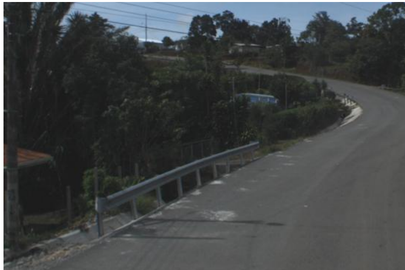
Figura 16: Guardavías cortos, estacionamiento 30+100
