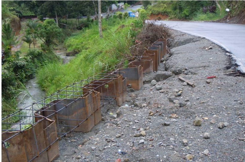
Figura 6: Muro de tablaestacas, estacionamiento 15+350
