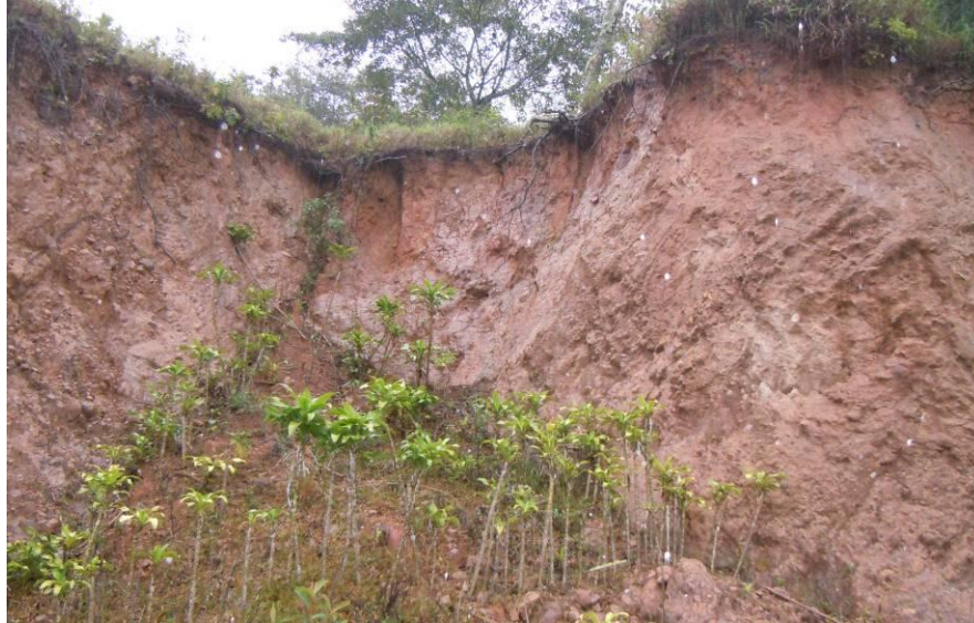
Figura 10: Deslizamiento, estacionamiento 23+500
