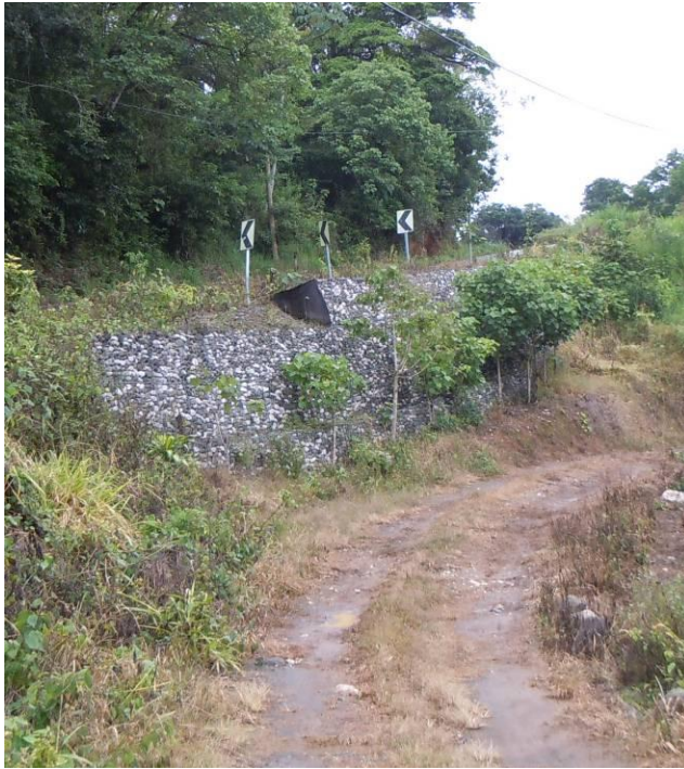
Figura 4: Muro de gaviones en terraplén y grietas en el pavimento, estacionamiento 13+980
