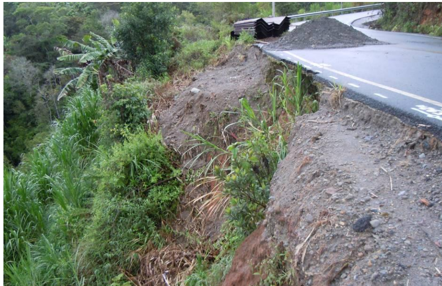
Figura 11: Terraplén en el estacionamiento 24+000
