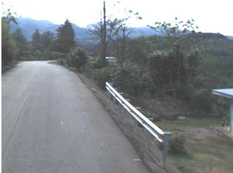
Figura 15: Guardavías cortos, estacionamiento 26+500
