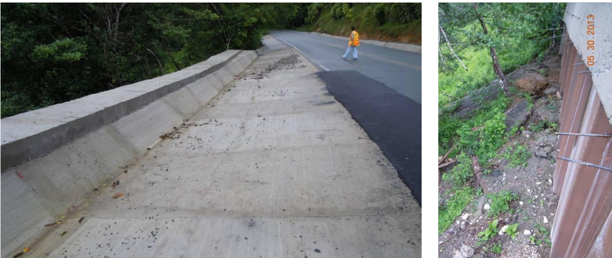
Figura 9: Muro finalizado de tablaestaca, estacionamiento 16+850
