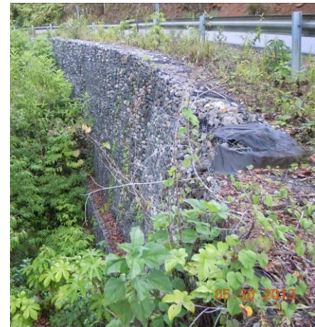
Figura 5: Deslizamiento activo y muro de gaviones, estacionamiento 15+050
