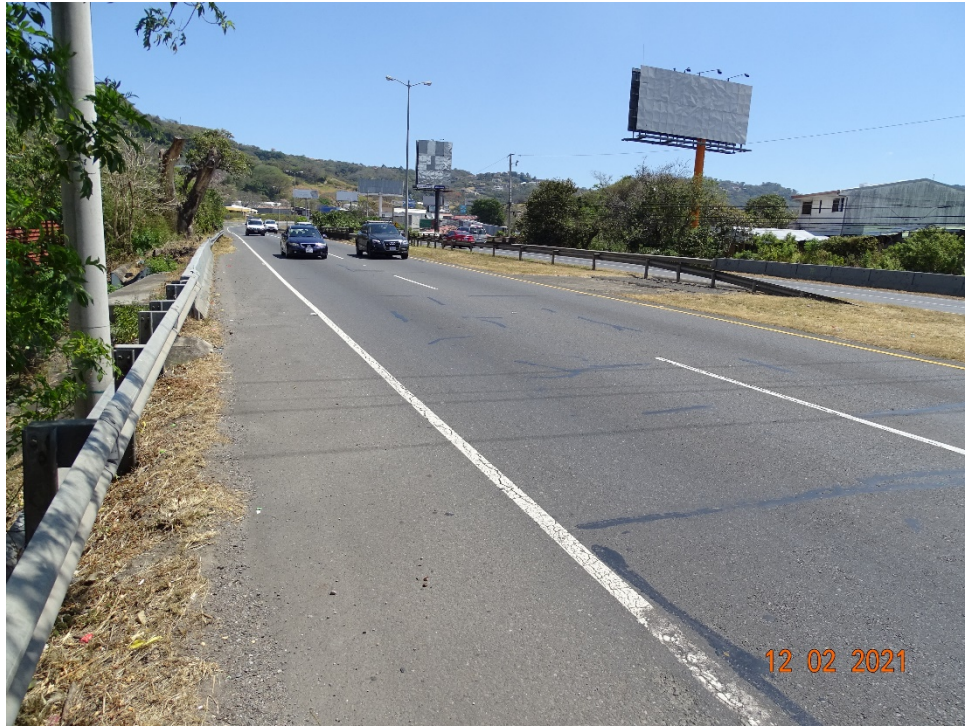
Figura 4.2. Vista a lo largo de la línea de centro (Vista Sentido San José – Ciudad Colón).
