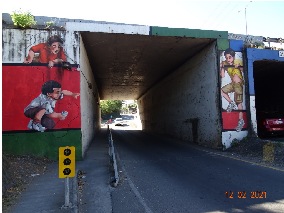
Figura 4.3. Vista lateral (costado norte)
