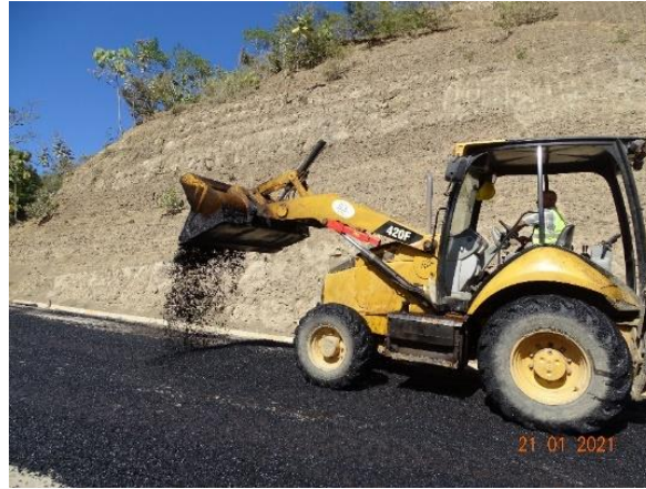
Figura 24. Segregación de mezcla asfáltica en el proceso de reparación de deterioros. Estacionamiento: 8+350. Fecha de la fotografía: 21/01/2021
