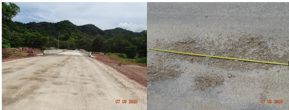
Figura 17. Deterioros en la base estabilizada con cemento en diversos tramos del proyecto. Fecha de las fotografías: 07/09/2020
