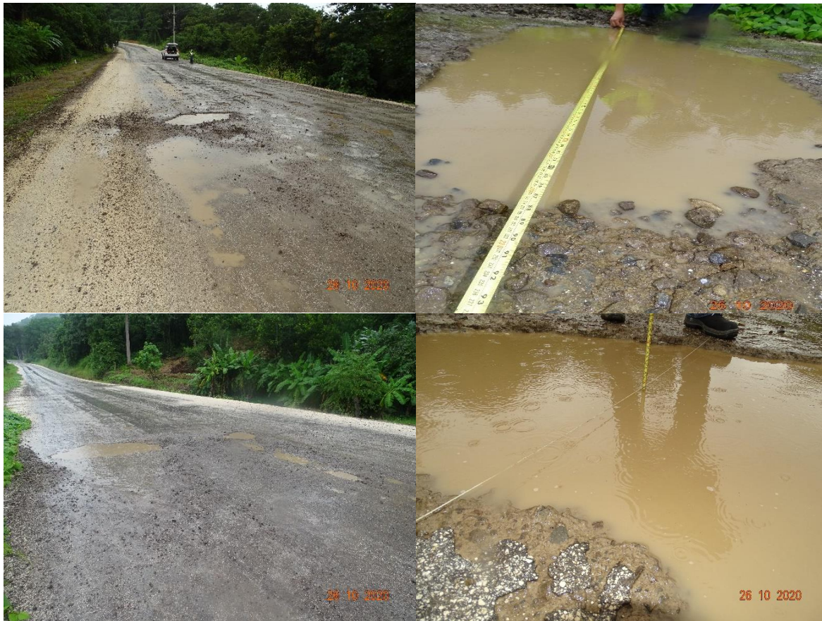
Figura 18. Deterioros en la base estabilizada con cemento. Estacionamiento: 5+450. Fecha de las fotografías: 26/10/2020
