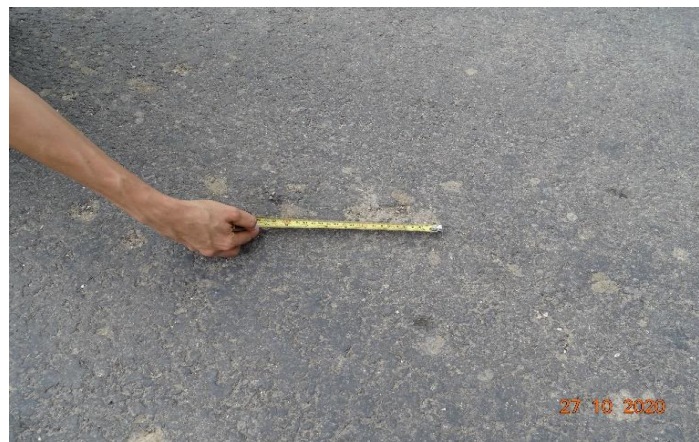
Figura 39. Desprendimiento de agregados e irregularidades en la carpeta asfáltica de hasta 120 mm. Estacionamiento: 14+694. Fecha de la fotografía: 27/10/2020
