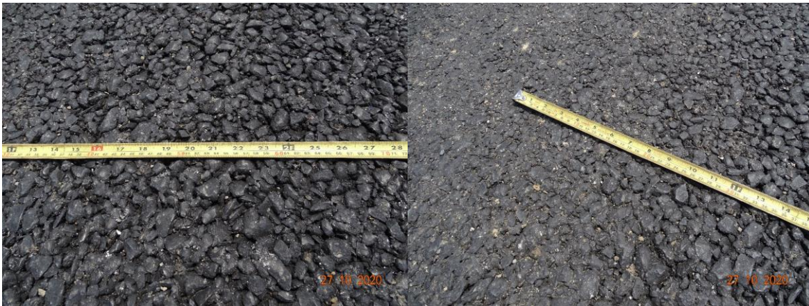
Figura 38. Mezcla asfáltica abierta y segregada. Estacionamiento: 13+386. Fecha de las fotografías: 27/10/2020
