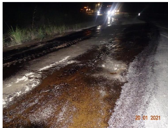
Figura 32. Exceso en la tasa de aplicación del riego de liga en secciones donde se colocó con poca luminosidad. Estacionamiento: 8+115. Fecha de la fotografía: 20/01/2021
