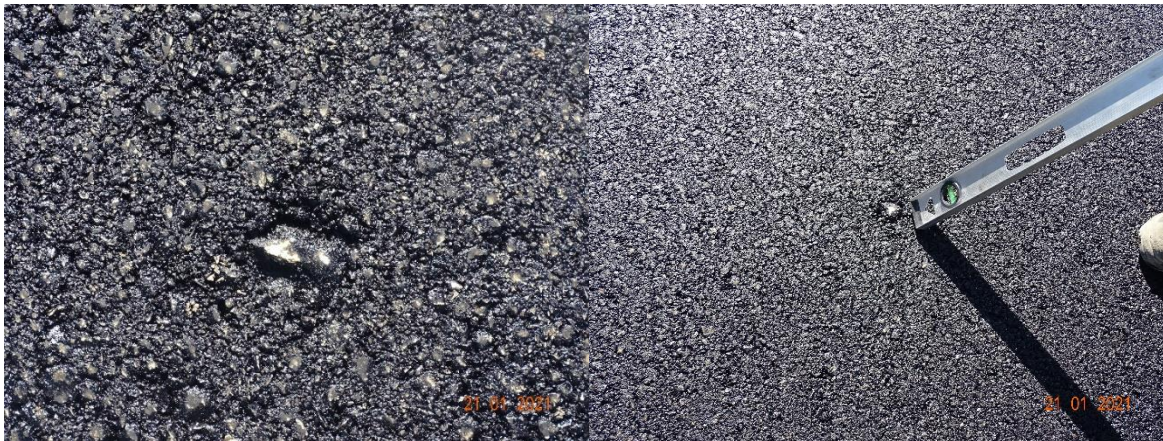
Figura 36. Agregados con escaso recubrimiento de asfalto en acabado de capa asfáltica colocada el día 20 de enero de 2021. Estacionamiento: 8+115. Fecha de la fotografía: 21/01/2021
