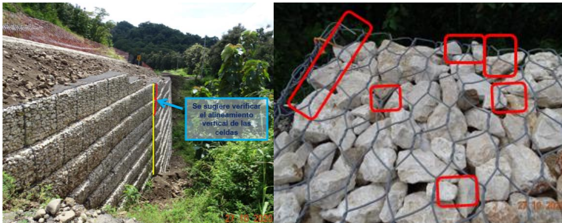
Figura 41. Muro de gaviones en el estacionamiento 13+200 con agregado de menor tamaño, vacíos y un alineamiento vertical inadecuado. Fecha de las fotografías: 27/10/2020
