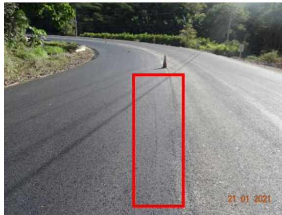
Figura 35. Marca de la compactadora en la sección dónde se había identificado la aplicación de riego de liga con poca luminosidad. Estacionamiento: 8+115. Fecha de la fotografía: 21/01/2021
