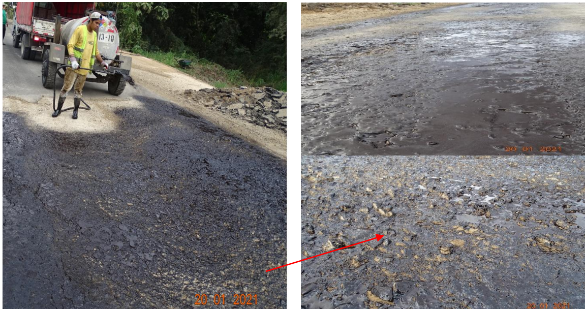
Figura 27. Condición de la superficie y del riego de liga en la cual se llevó a cabo la pavimentación. Estacionamiento: 8+115. Fecha de la fotografía: 20/01/2021
