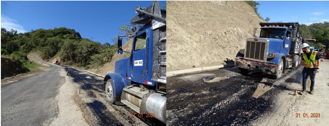
Figura 28. Riego de liga no uniforme, sin cobertura total, sobre superficie con polvo y arrastre de riego de liga. Estacionamiento: 8+300. Fecha de la fotografía: 21/01/2021
