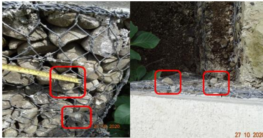
Figura 43. Muro de gaviones en el estacionamiento 3+950 con agregado quebradizo y meteorizable. Fecha de las fotografías: 27/10/2020
