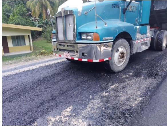
Figura 23. Acabado irregular de la mezcla asfáltica colocada como reparación a los deterioros de la base estabilizada. Estacionamiento: 8+500. Fecha de las fotografías: 20/01/2021
