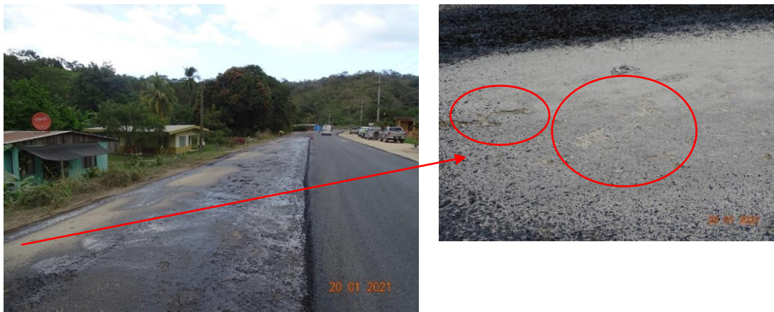
Figura 29. Aplicación de riego de liga exclusivamente en secciones donde a criterio del Contratista se perdió sello de imprimación (izquierda). Pérdida de sello de imprimación en secciones donde no se colocó riego de liga (Derecha). Estacionamiento: 8+115. Fecha de las fotografías: 20/01/2021
