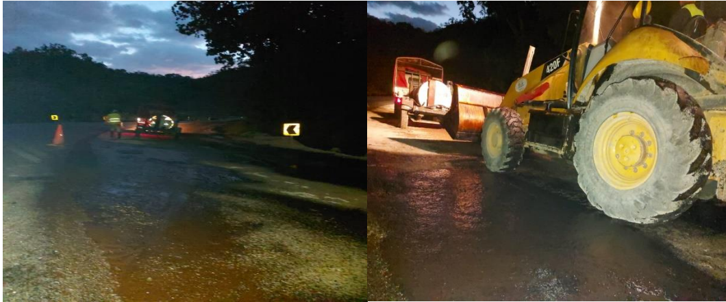
Figura 32. Exceso en la tasa de aplicación del riego de liga en secciones donde se colocó con poca luminosidad. Estacionamiento: 8+115. Fecha de la fotografía: 20/01/2021
