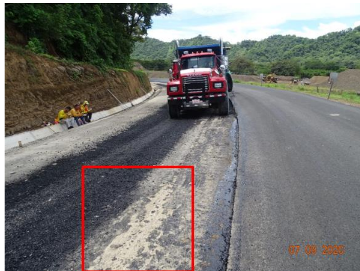
Figura 30. Colocación de mezcla asfáltica en zonas sin riego de imprimación. Fecha de la fotografía: 07/09/2020
