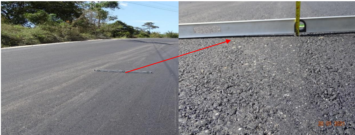
Figura 34. Desnivel en la junta longitudinal. Estacionamiento: 6+900. Fecha de la fotografía: 20/01/2021
