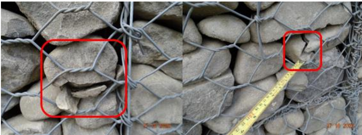
Figura 43. Muro de gaviones en el estacionamiento 3+950 con agregado quebradizo y meteorizable. Fecha de las fotografías: 27/10/2020
