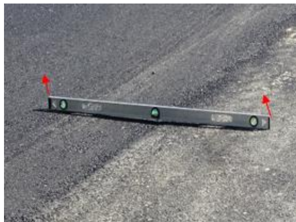
Figura 33. Desnivel en la junta longitudinal. Estacionamiento: 8+115. Fecha de la fotografía: 21/01/2021
