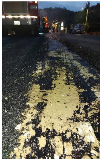
Figura 27. Condición de la superficie y del riego de liga en la cual se llevó a cabo la pavimentación. Estacionamiento: 8+115. Fecha de la fotografía: 20/01/2021
