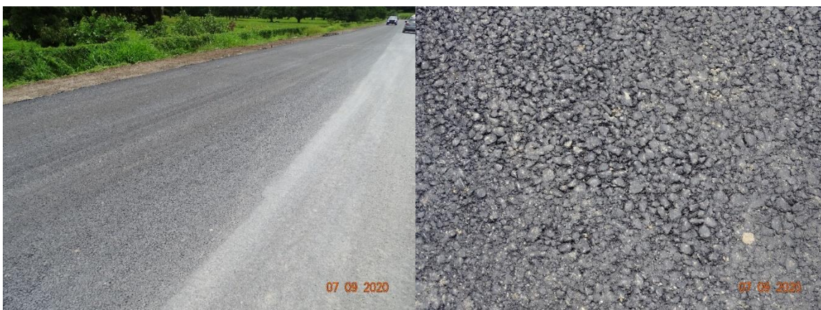
Figura 37. Mezcla asfáltica abierta y segregada. Estacionamiento: 9+900. Fecha de las fotografías: 07/09/2020
