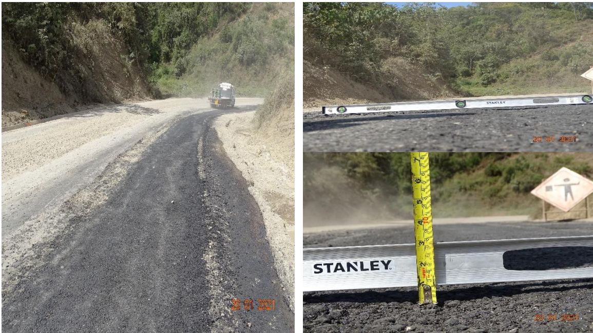
Figura 23. Acabado irregular de la mezcla asfáltica colocada como reparación a los deterioros de la base estabilizada. Estacionamiento: 8+500. Fecha de las fotografías: 20/01/2021
