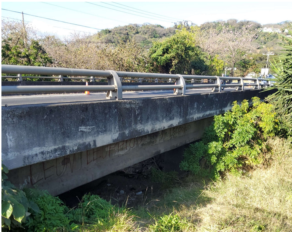
Figura 4.3. Vista lateral (costado aguas arriba).
