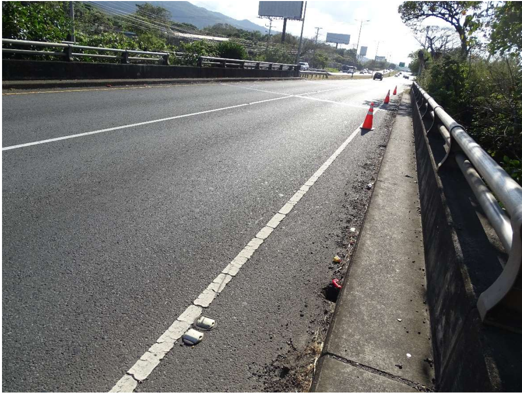
Figura 4.2. Vista a lo largo de la línea de centro (Vista hacia Ciudad Colón).
