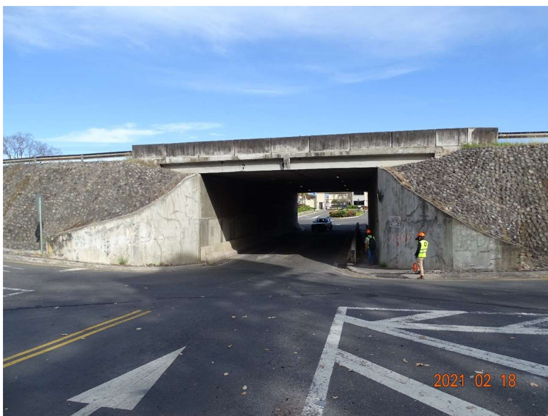
Figura 4.3. Vista lateral (costado sur)
