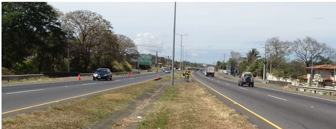
Figura 4.2. Vista a lo largo de la línea de centro (Vista hacia Ciudad Colón).
