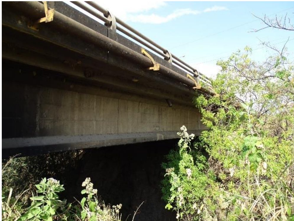
Figura 4.3. Vista lateral (costado aguas arriba).
