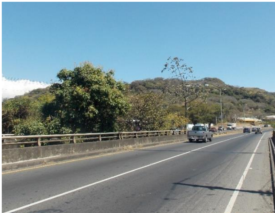
Figura 4.2. Vista a lo largo de la línea de centro (Vista hacia San José).
