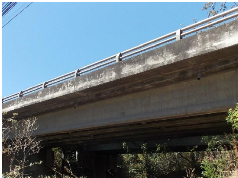
Figura 4.3. Vista lateral (costado aguas arriba).
