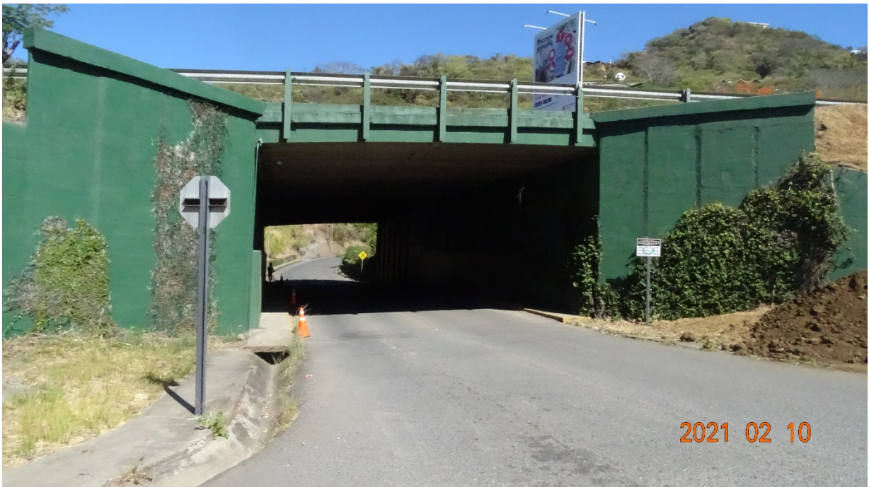
Figura 4.3. Vista lateral (costado sur).
