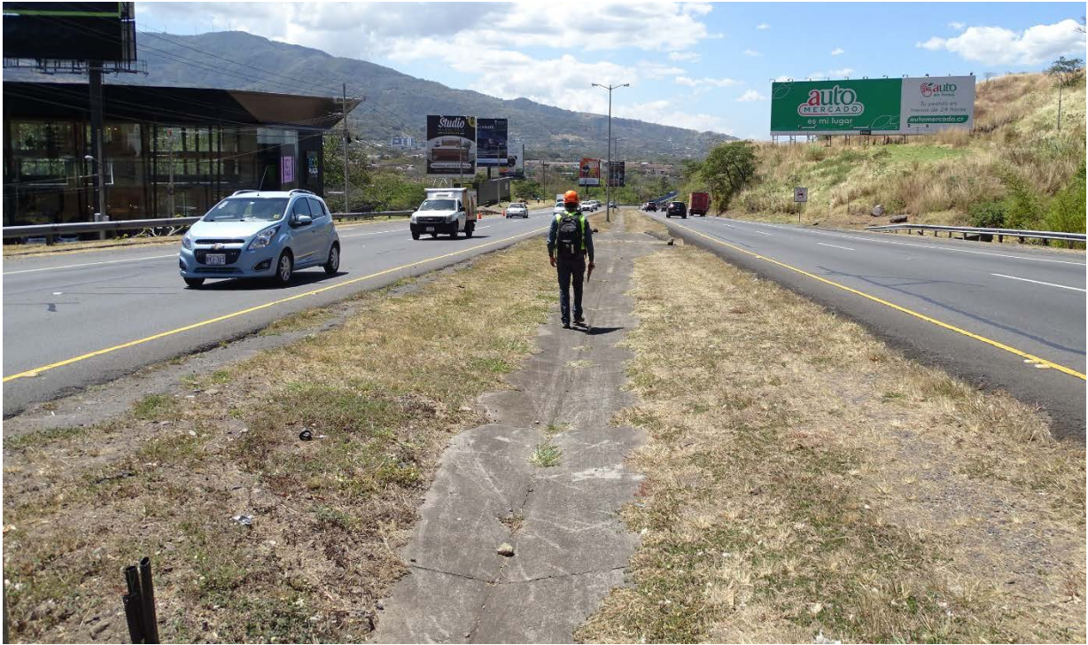
Figura 4.2. Vista a lo largo de la línea de centro (vista hacia Ciudad Colón).
