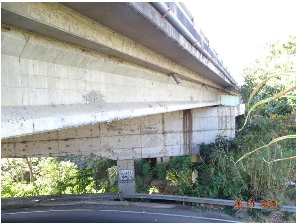
Figura 4.3. Vista lateral (costado aguas abajo).
