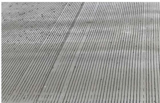
Figura 37. Formación de macro textura transversal en pavimento de concreto hidráulico
