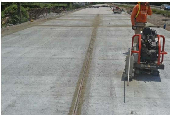
Figura 42. Conformación de juntas
