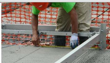
Figura 60. Equipo mecánico manual para macro texturizado de la superficie
