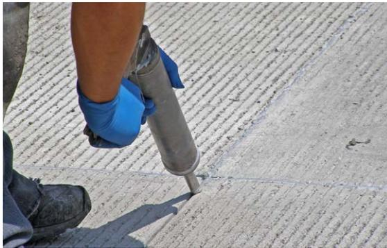
Figura 44. Sellado de juntas en un pavimento de concreto hidráulico
