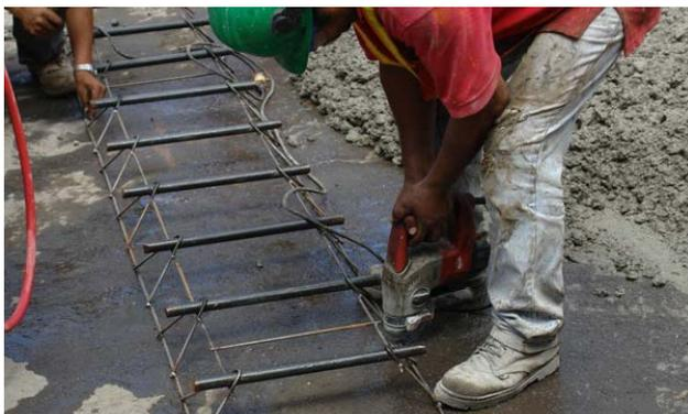
Figura 13. Instalación de dovelas en pavimento de concreto hidráulico articulado
