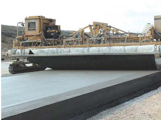
Figura 36. Arrastre de lona de yute para formar micro textura en la superficie de pavimento
