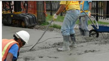
Figura 65. Método inadecuado de vibración del concreto
