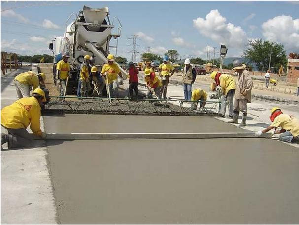
Figura 22. Colocación de concreto, formaletas fijas
