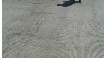
Figura 72. Fisuras longitudinales
