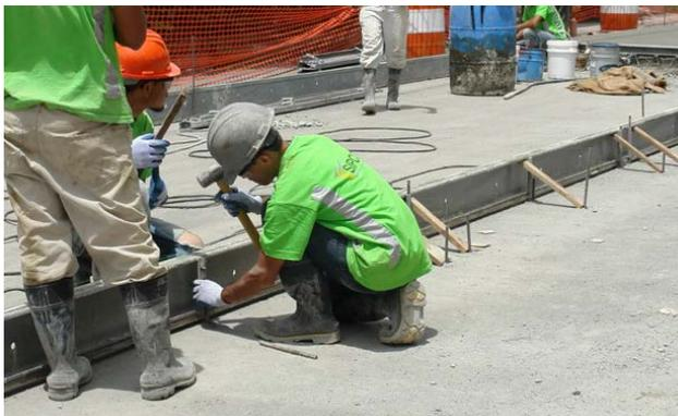
Figura 11. Instalación de formaleta
