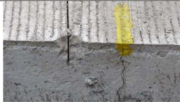
Figura 69. Grieta por contracción plástica del concreto
