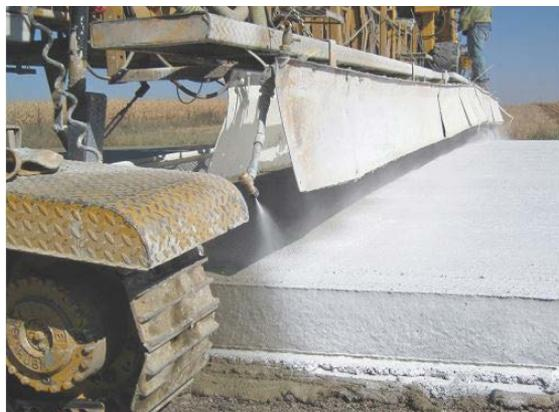
Figura 38. Curado del concreto
