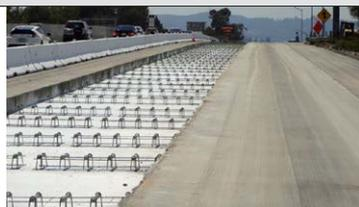
Figura 54. Colocación de canastillas de dovelas
