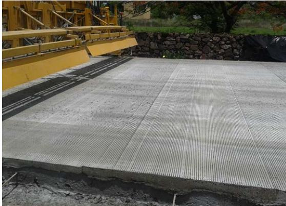
Figura 35. Acabado en superficie de pavimento de concreto hidráulico
