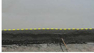
Figura 66. Irregularidades en la superficie de la losa de concreto
