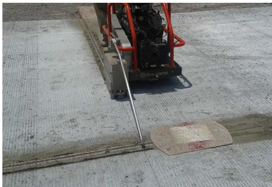
Figura 43. Aserrado de juntas en pavimento de concreto hidráulico
