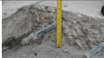
Figura 61. Dovelas colocadas por encima de la mitad del espesor de las losas
