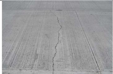
Figura 71. Grieta provocada por contracción del concreto
