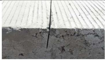
Figura 70. Corte no perpendicular a la superficie
