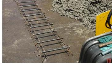
Figura 55. Base humedecida previo a la colocación de concreto
