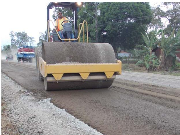
Figura 9. Preparación de la base del pavimento
