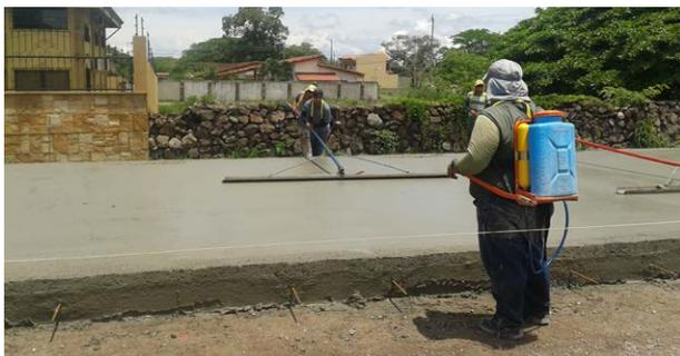
Figura 24. Flotado manual del concreto
