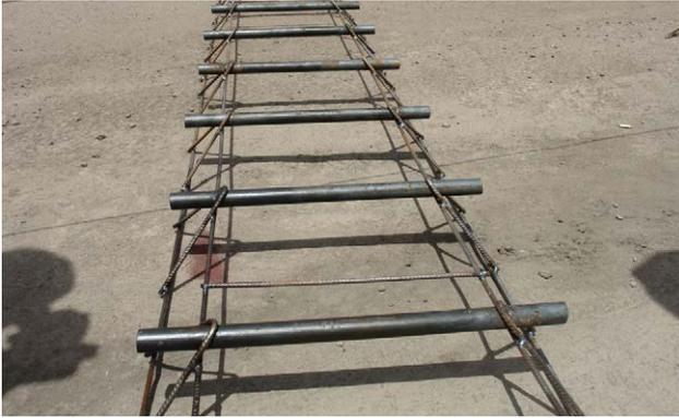
Figura 14. Canastilla de dovelas fijada a la base del pavimento
