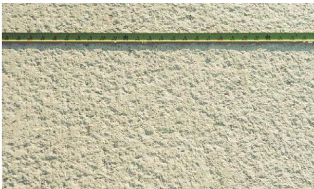
Figura 21. Superficie de concreto deteriorada por gotas de lluvia
