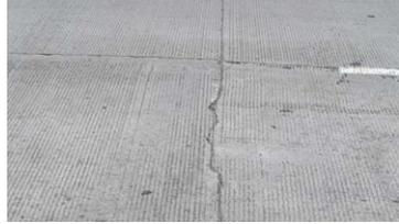
Figura 68. Irregularidad en junta transversal
