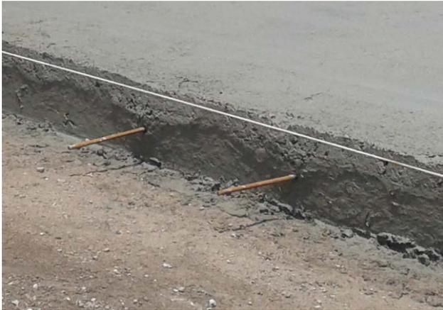
Figura 1. Barras de amarre en junta longitudinal
