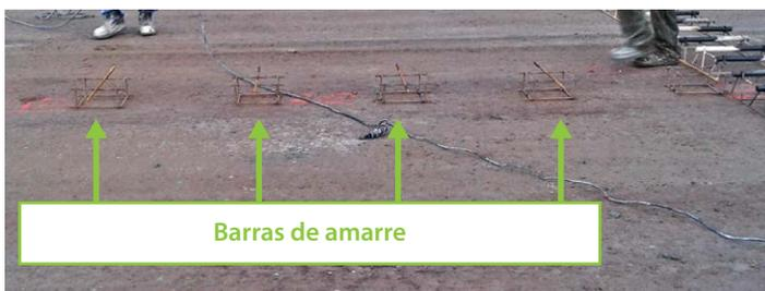
Figura 32. Instalación de barras de amarre mediante canastillas
