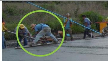
Figura 64. Utilización inadecuada de la flota
