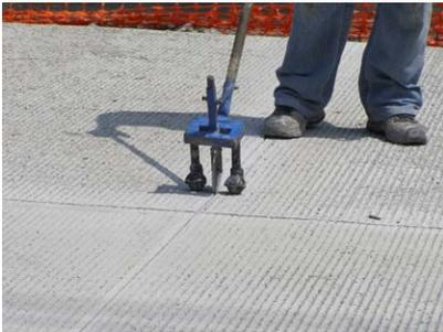
Figura 45. Colocación de cordón de respaldo
