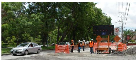
Figura 48. Protección del pavimento y control de tránsito
