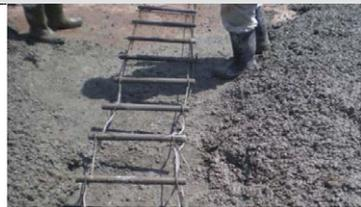
Figura 62. Canastilla de dovelas en mal estado
