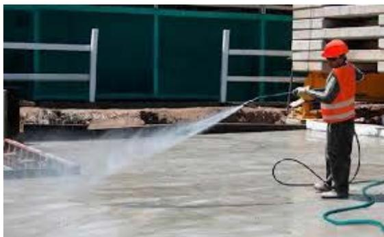
Figura 41. Curado del concreto por nebulización
