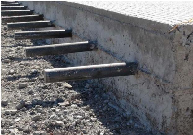
Figura 2. Dovelas en pavimento de concreto hidráulico articulado
