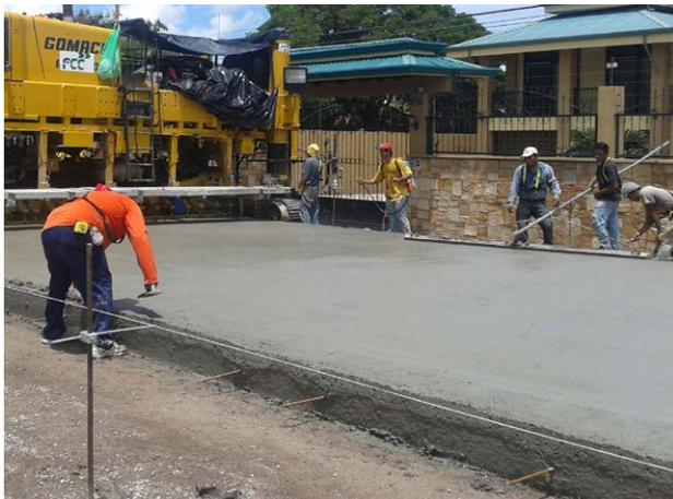
Figura 19. Colocación del concreto e instalación de barras de amarre
