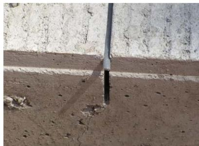
Figura 46. Cordón de respaldo en junta de pavimento
