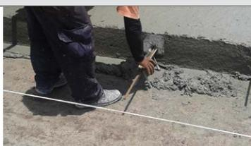
Figura 59. Instalación de barras de amarre utilizando guías
