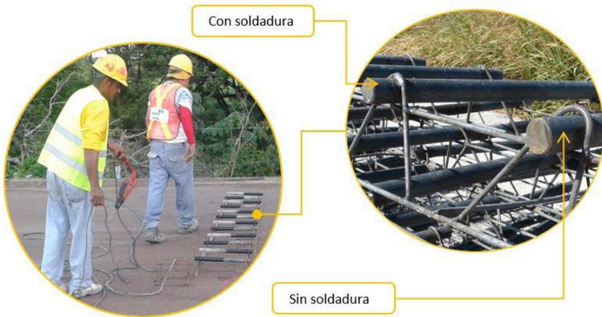
Figura 15. Instalación de canastilla de dovelas con soldadura alternada
