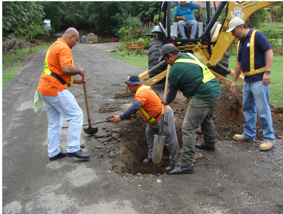
Figura 4. Proceso de excavación de los sondeos a cielo abierto.
