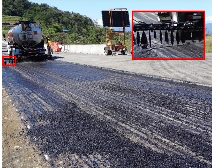
Figura 24. Las boquillas del distribuidor de la emulsión estaban parcialmente obstruidas, de modo que el flujo de emulsión no era continuo. Estacionamiento: 36+450. Fecha: 16 de enero de 2020
