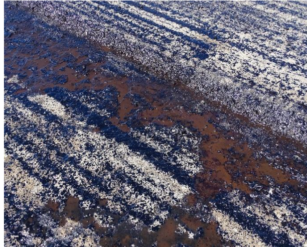
Figura 25. Acumulación de emulsión asfáltica. Estacionamiento: 36+450. Fecha: 16 de enero de 2020
