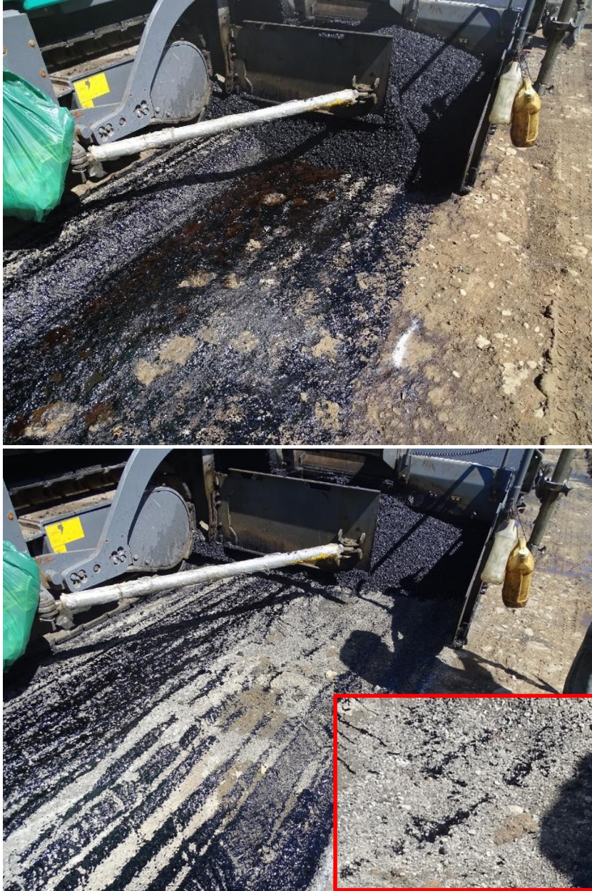
Figura 26. Se observó la colocación de mezcla asfáltica sobre una franja de base estabilizada contaminada y con partículas sueltas. Estacionamiento: 36+450. Fecha: 16 de enero de 2020
