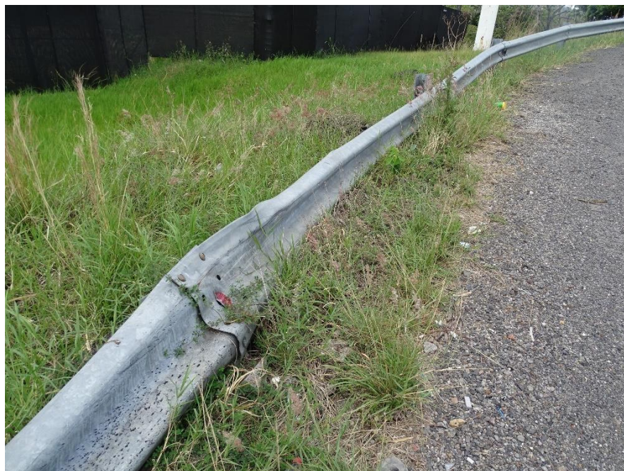
Figura 3.6. Sección impactada en sistema de contención vehicular del acceso n.º 2.
