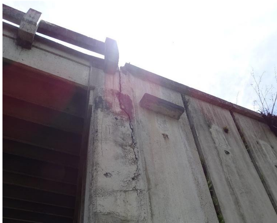
Figura 2.5. Evidencia de agrietamiento en la unión del aletón con el cuerpo del bastión n.º 2.
