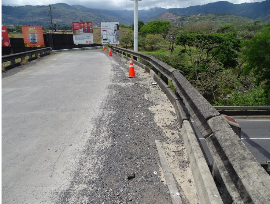
Figura 2.3. Acumulación de sedimentos de tamaños variables (diámetros inclusive mayores a 300 mm) y de escombros al costado oeste del tablero.
