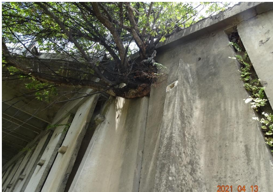
(b) Árbol en muro de retención no integrado del acceso n.º 1
