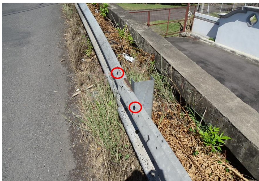
Figura 3.4. Ausencia de pernos para unir elementos longitudinales y altura insuficiente del sistema de contención en acceso n.º 1.
