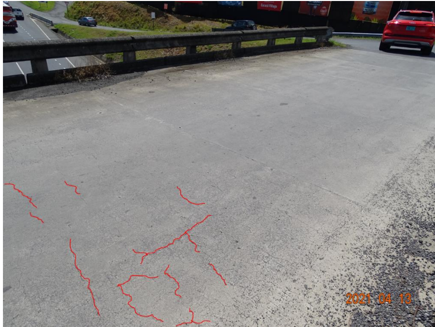
Figura 2.6. Evidencia de agrietamiento en dos direcciones en tablero (se resalta en color rojo algunas de las grietas).
