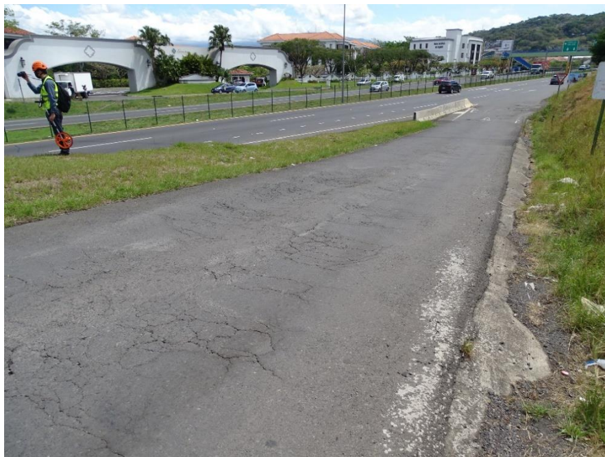
Figura 2.2. Surcos, agrietamiento y desprendimientos en superficie de desgaste del acceso n.º2.
