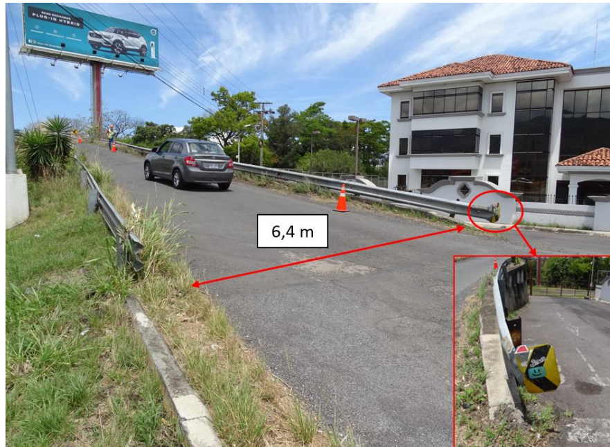
Figura 3.3. Ancho de rampa de ingreso y de terminales peligrosos en el acceso n.º 1.
