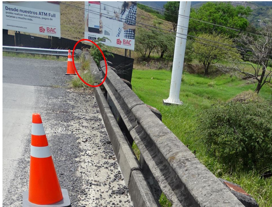
Figura 3.7. Ausencia de sistema de contención vehicular en rampa de salida del acceso n.º2.
