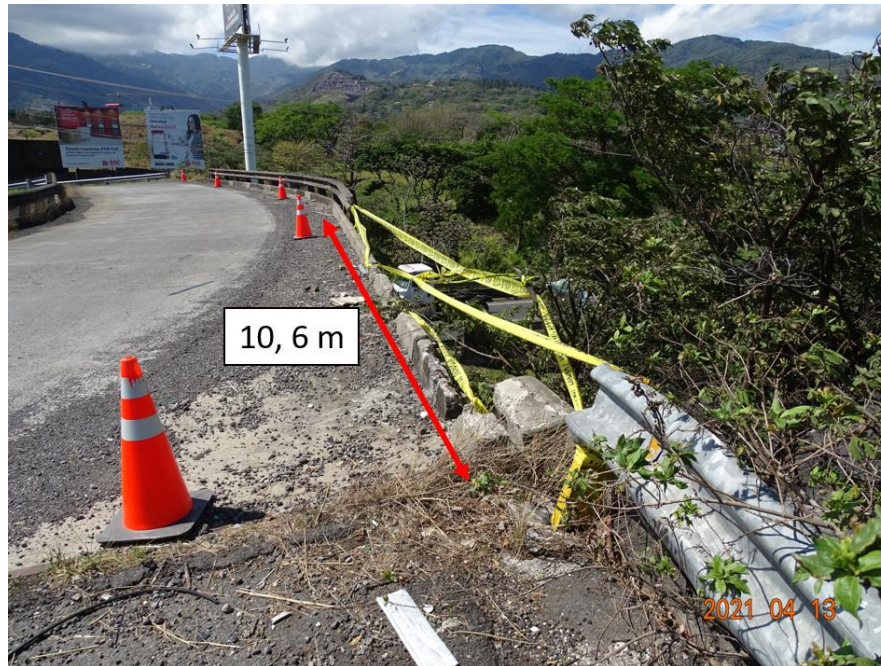
Figura 3.2. Ausencia de sistema de contención vehicular debido a colisión.
