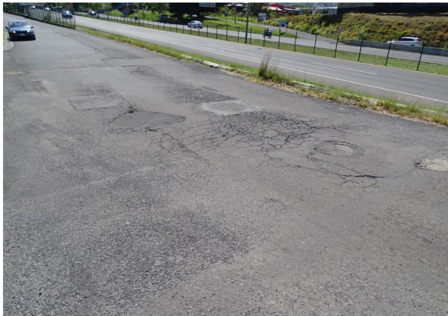
Figura 2.1. Agrietamiento, hundimientos y huecos en superficie de desgaste del acceso n.º 1.
