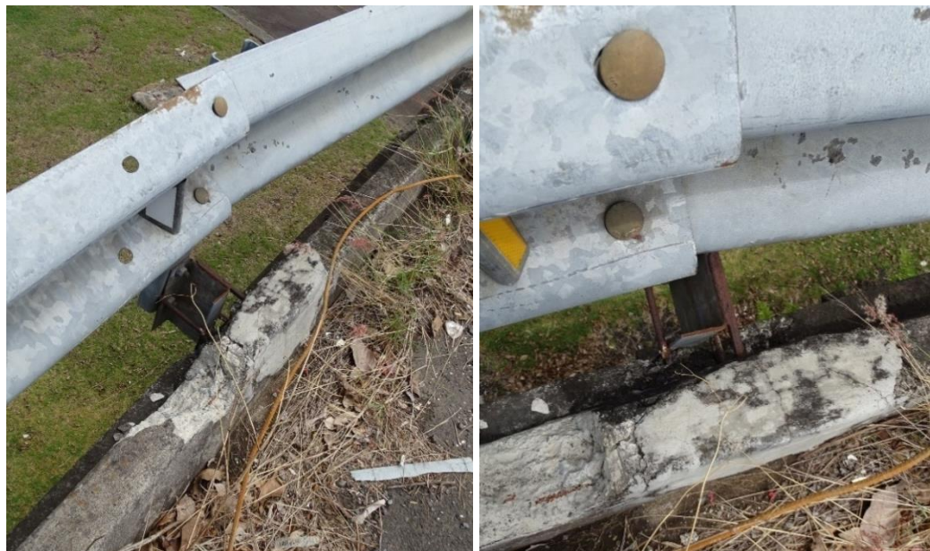
Figura 3.5. Traslape insuficiente en conexión de elementos longitudinales y anclaje inadecuado del poste mediante varillas soldadas en de contención lateral en acceso n.º 1.
