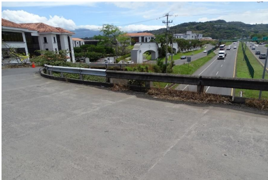
Figura 3.1. Combinación de sistemas de contención metálicos y de concreto.
