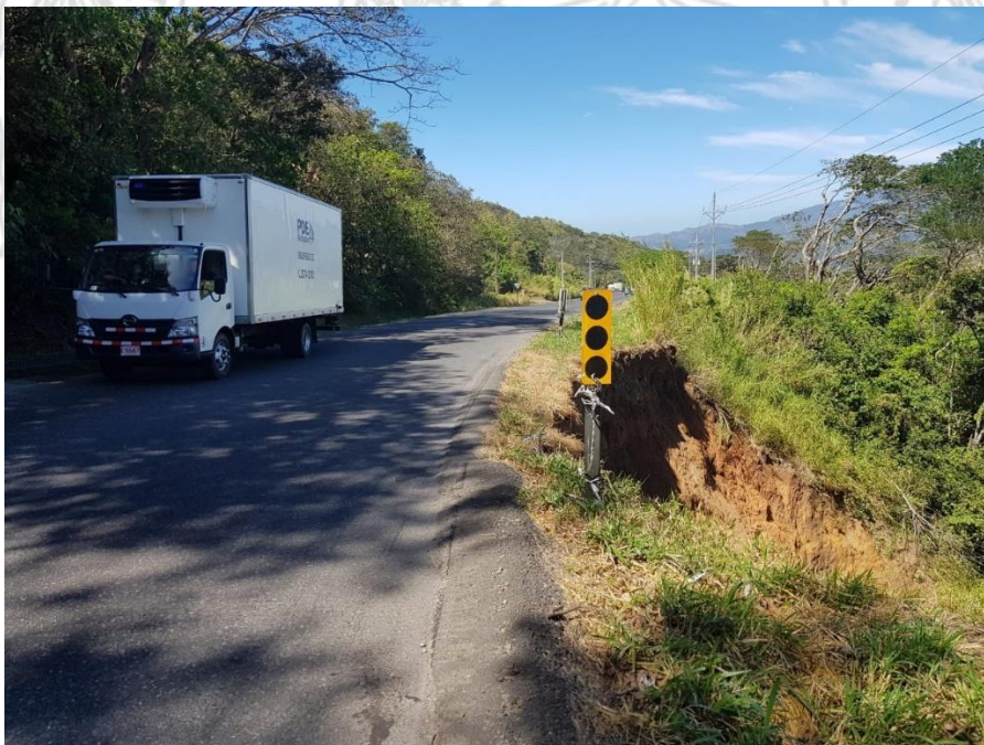
Fotografía No.2: Vista del deslizamiento desde el sector este. Se observan elementos de seguridad vial que indican prevención debido al deslizamiento, sin embargo, el carril externo está a menos de medio metro del deslizamiento.
