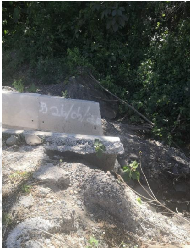
Fotografía No.3: Vista de los trabajos inconclusos que hay en el punto evaluado en las obras de manejo de aguas superficiales.
