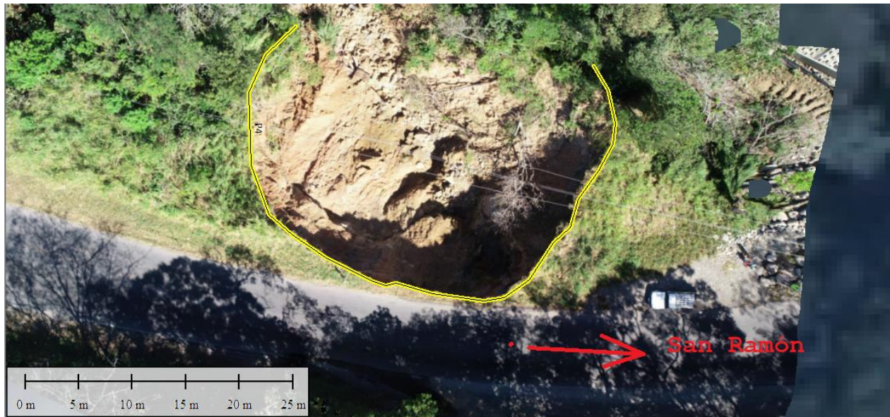
Figura No.4. Ortofotografía del sitio P4 y su relación con la Ruta. Las líneas amarillas marcan la ubicación de las grietas observadas en el campo, así como en el modelo de elevación digital levantado con el VANT.
