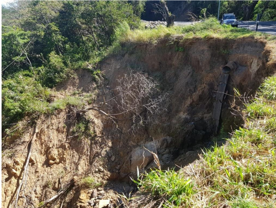
Fotografía No.1: Deslizamiento observado en el P4 desde el sector oeste de la calzada. Nótese como hay una salida de una alcantarilla corrugada que colapsó con el deslizamiento.
