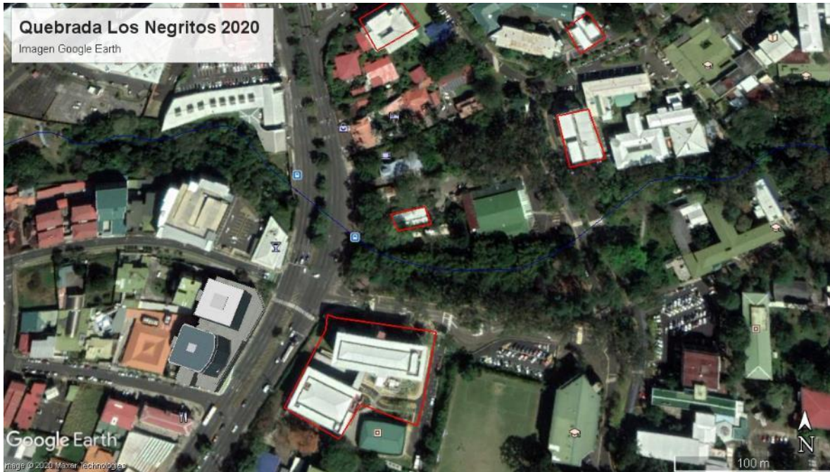
Figura 4. Comparación de imágenes satelitales del Google Earth del 2012 y 2020 en la zona donde se ubica la alcantarilla de la Quebrada Los Negritos. Los polígonos rojos indican los sitios aguas arriba, donde ocurrieron cambios o se construyó infraestructura nueva.
