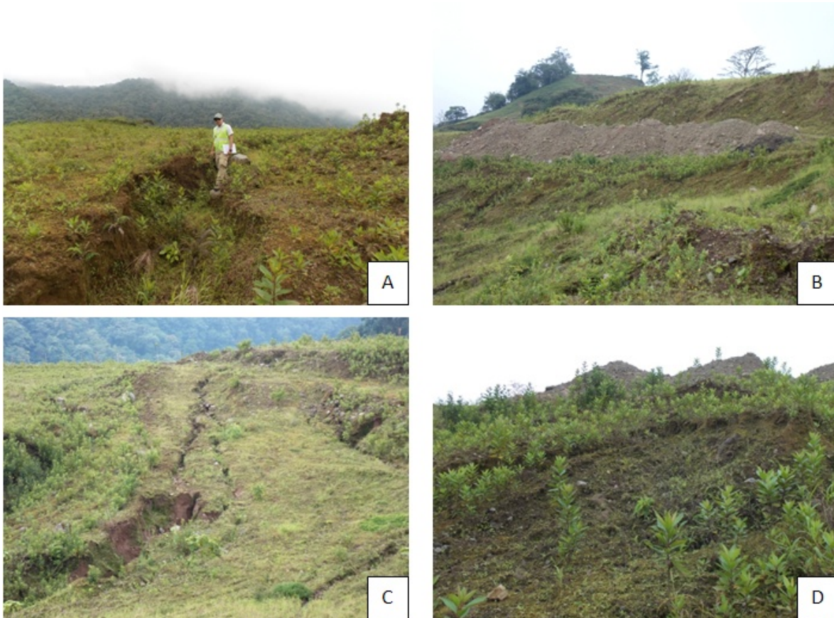
Figura No.26 Deterioros observados en la escombrera S13A. A) Cárcava de aproximadamente 1 m de profundidad y ancho variable. B) Material colocado recientemente en la escombrera, este material está siendo arrastrado por el agua de escorrentía. C) Sistema de surcos y cárcavas formados en la terraza de la escombrera, evidencia de erosión superficial. D) Detalle de una de las zonas con poca cobertura vegetal, se aprecia con facilidad la superficie de la escombrera.
