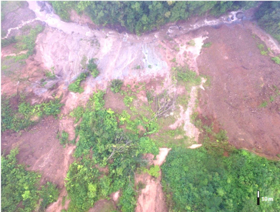
Figura No.25 Vista aérea del talud al pie de la escombrera S13, costado oeste. En la parte superior de la fotografía se observa el río Espino. Nótese la gran cantidad de sedimentos y materiales que están cayendo en el río.
