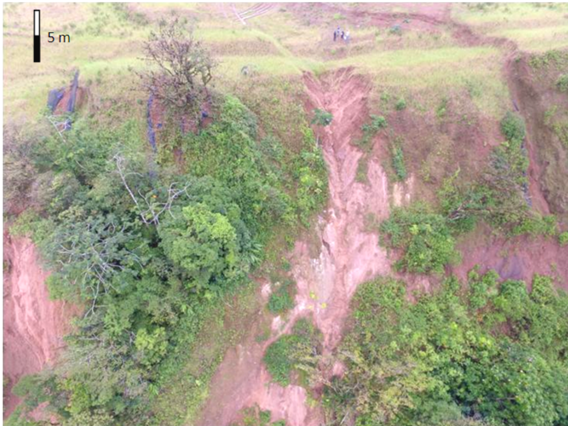
Figura No.24 Vista aérea del costado oeste de la escombrera S13. Se observan varios deslizamientos y la erosión severa que está teniendo lugar en este sitio.
