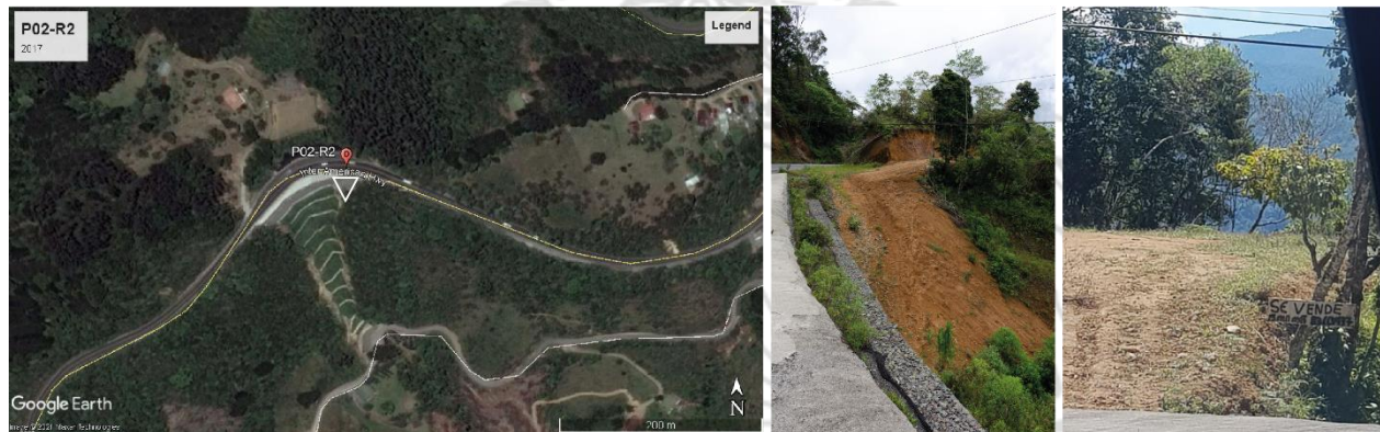
Figura No. 7. Imagen satelital tomada de Google Earth del año 2017, donde se pueden observar las obras de estabilización construidas en este sitio. A la derecha se muestran dos fotografías del relleno que se ha construido en el sector lateral del sitio intervenido y que podría implicar problemas en el manejo de aguas e inestabilidad.
