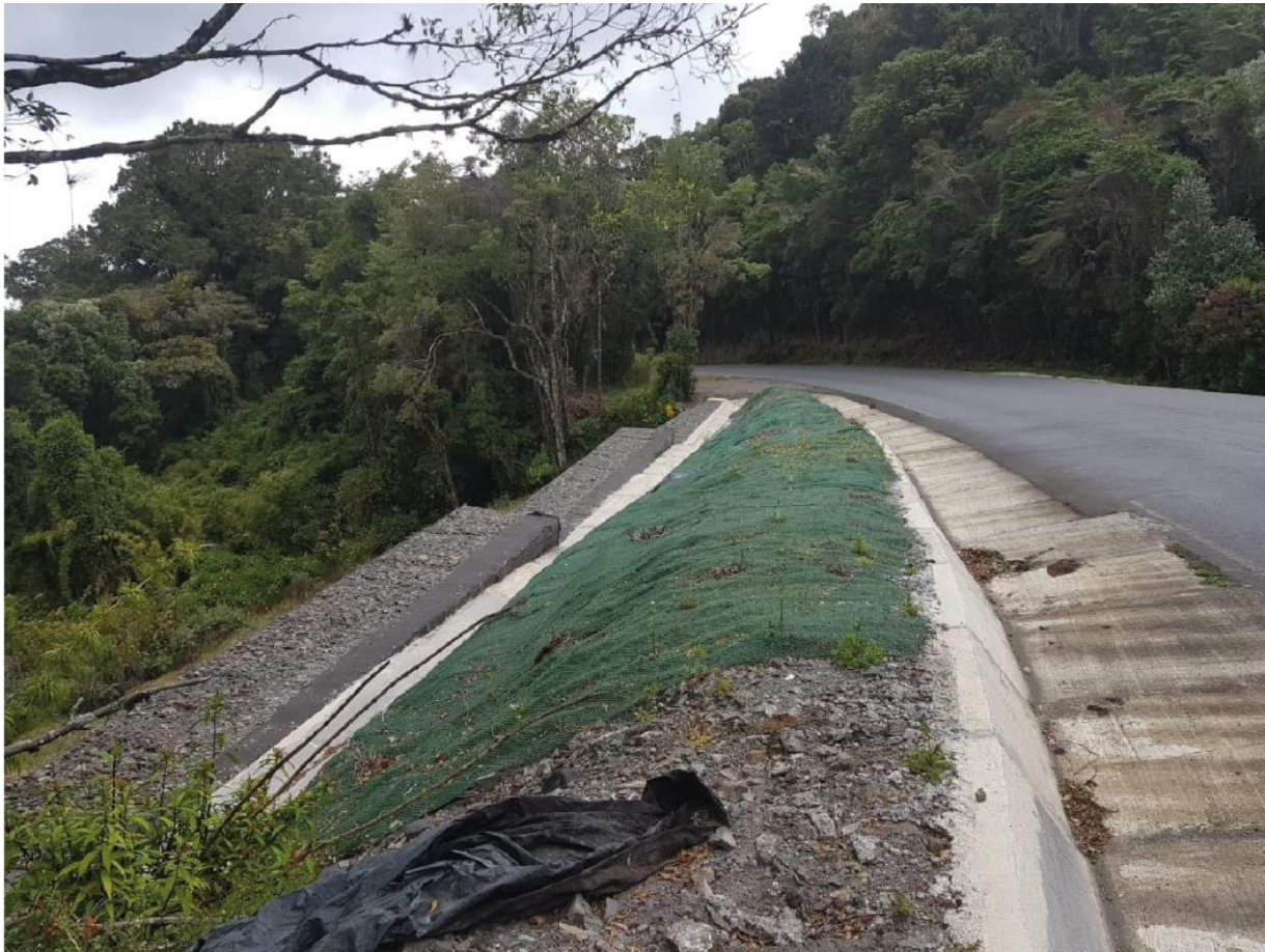
Fotografía 22 Muro de gaviones y manto para la protección contra erosión colocados en el sitio P12-R2.
