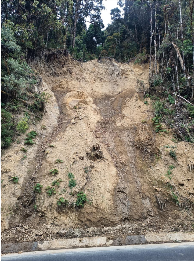
Fotografía 23. Sitio P13-R2 donde se observa como hay humedad en el talud y bloques de roca en la parte superior que se pueden desprender y caer en la calzada.
