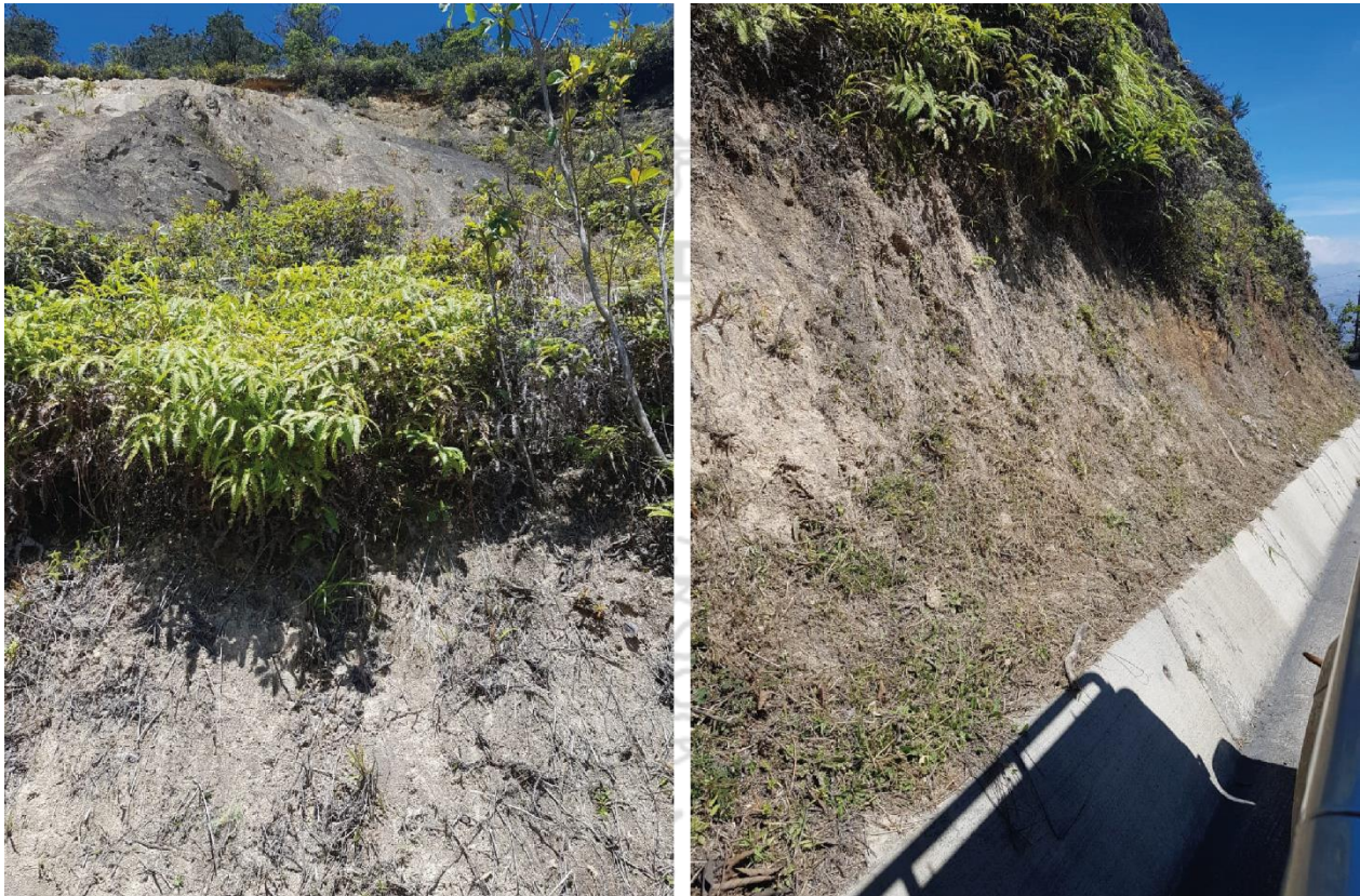
Fotografías 1 y 2. Sitio P01-R2, se observan las cunetas para mejorar el manejo de aguas superficiales.
