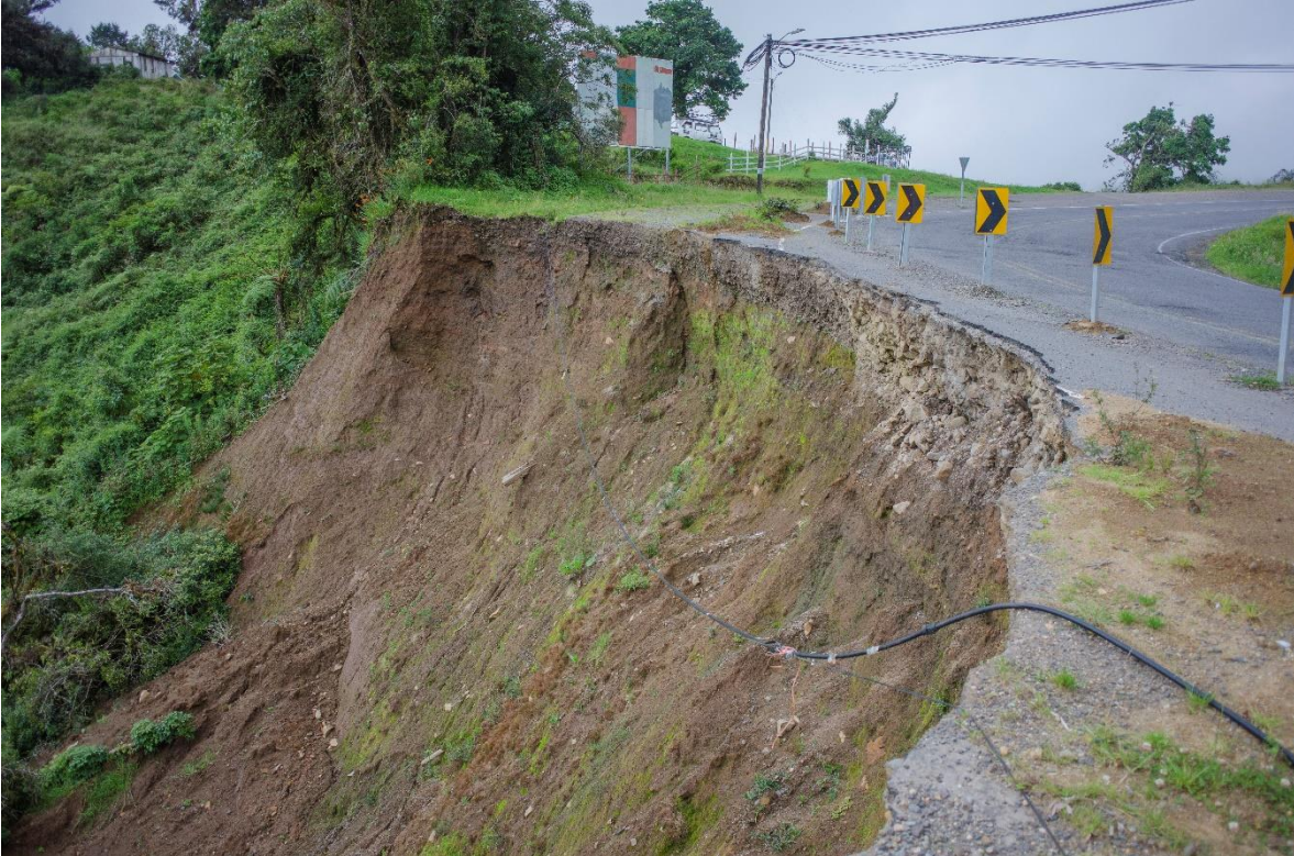
Fotografía 19 del sitio afectado por el deslizamiento en el talud de relleno, esta imagen fue capturada el julio del 2018.
