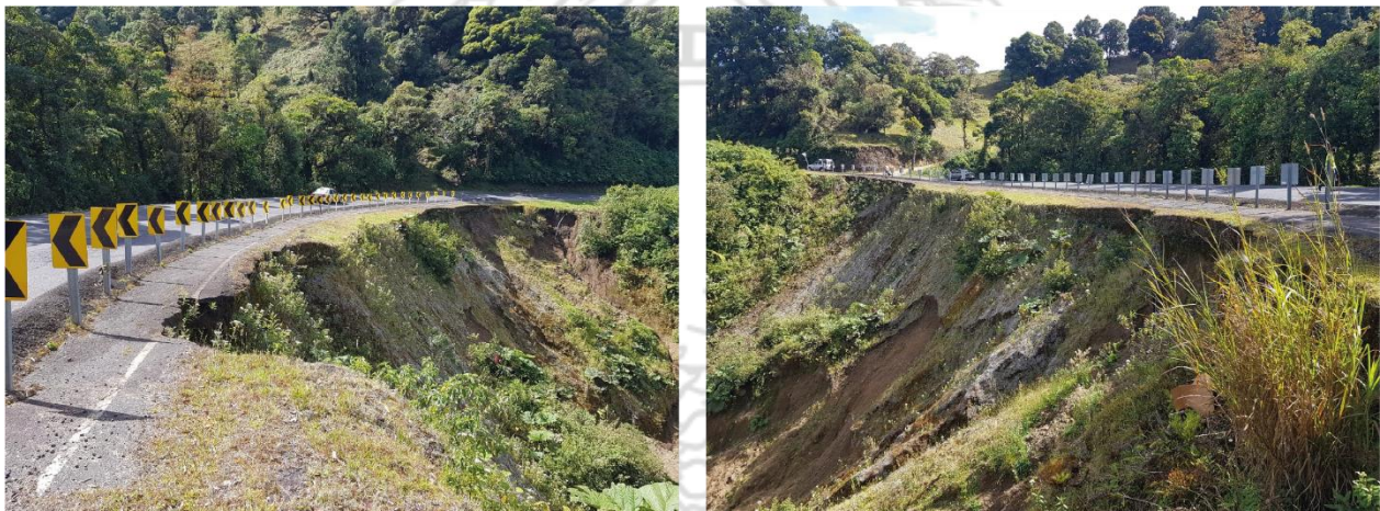
Fotografías 17 y 18. Se muestra el deslizamiento ubicado en el sitio P09-R2 y su relación con la calzada.
