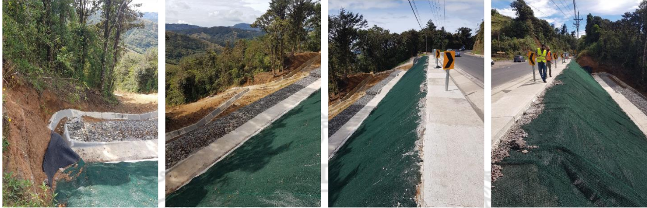
Fotografías 13, 14, 15 y 16. Trabajos de estabilización y protección realizados en el sitio P07-R2.
