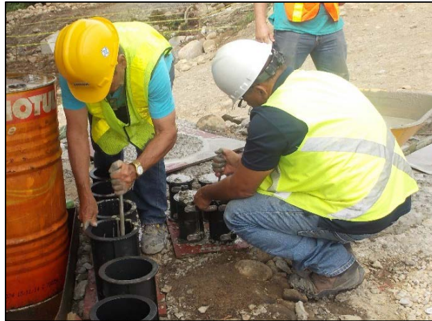
Figura 19. Fabricación de especímenes de muestreo de concreto, puente río Corinto, km 50+975. Fecha de la fotografía 21-01-2018.
