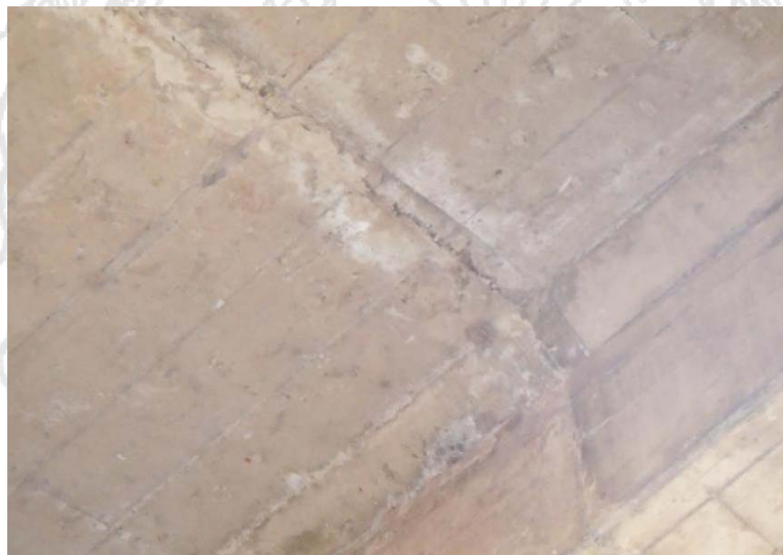
Figura 20: Mancha de eflorescencia en junta de construcción, superficie inferior de losa de concreto.
