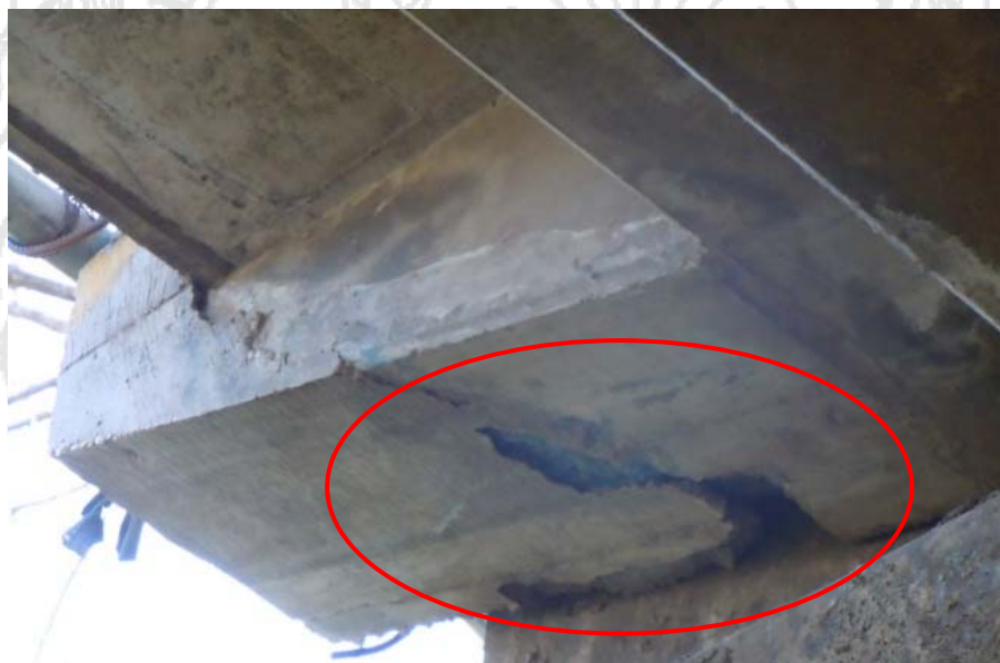
Figura 10: Reparación con vacíos internos en la unión entre el concreto nuevo y el original en el voladizo de la barrera en el sector noroeste.
