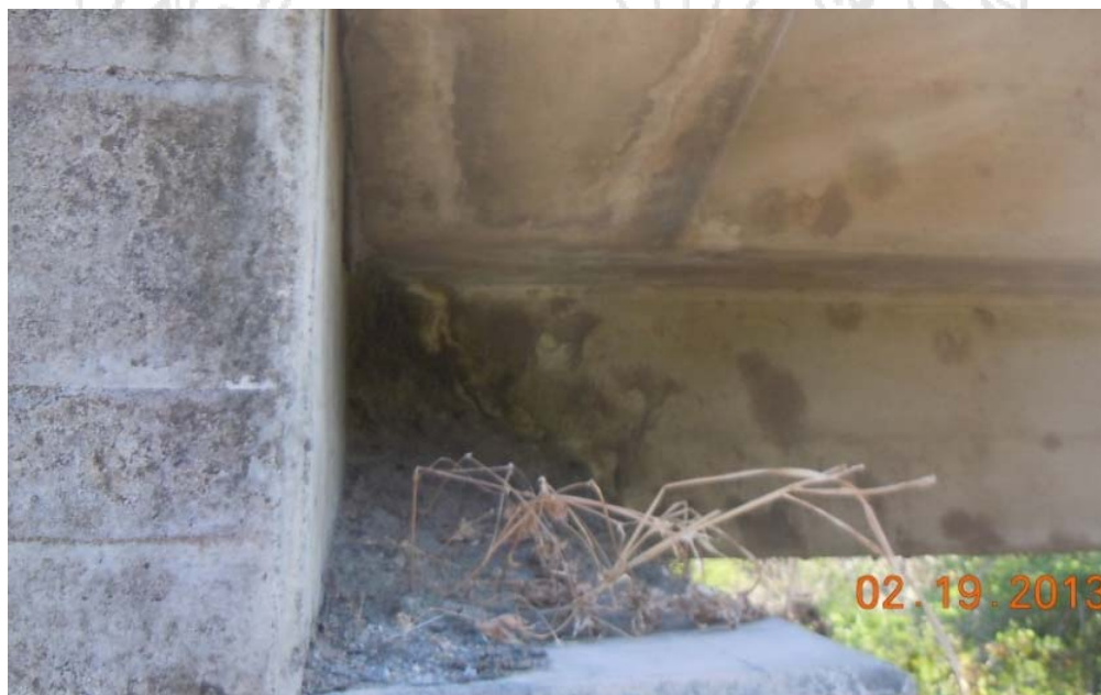
Figura 22: Acumulación de sedimentos en los apoyos de los bastiones (Bastión 1, hacia Cañas).
