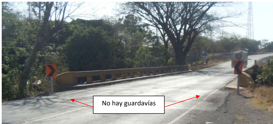
Figura 11: Faltante de guardavías, acceso este.
