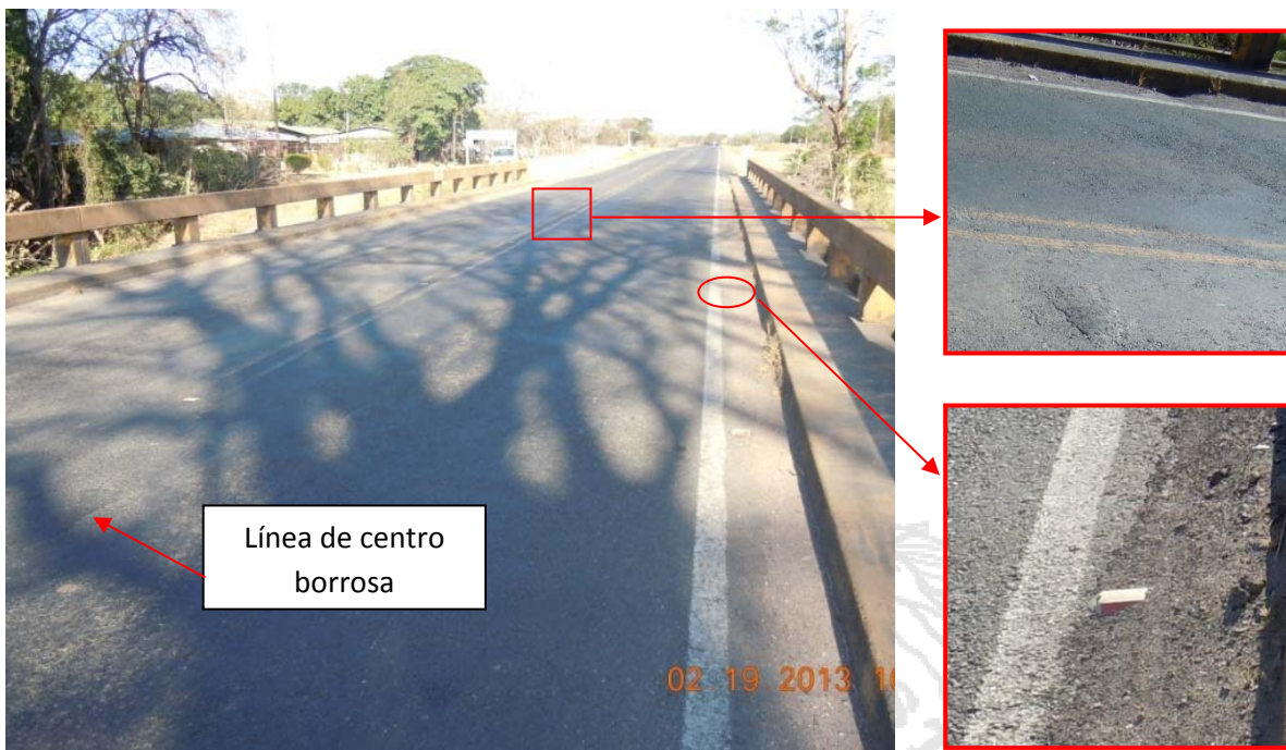
Figura 13: Demarcación horizontal borrosa, así como pérdida y mantenimiento inadecuado de captaluces.
