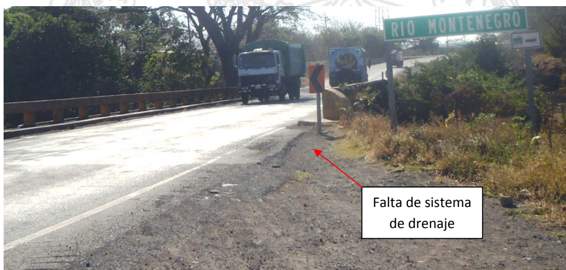
Figura 14: Falta de sistema de drenaje en los accesos, acceso este.
