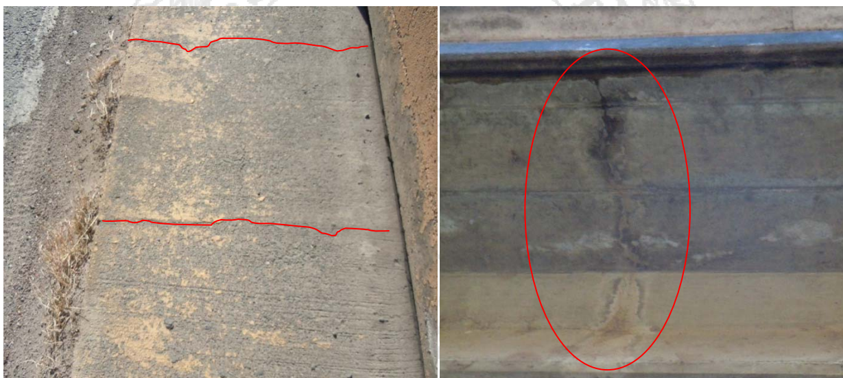
Figura 12: Agrietamiento del bordillo de seguridad en la superficie superior (izquierda) y superficie inferior (derecha), sector norte.
