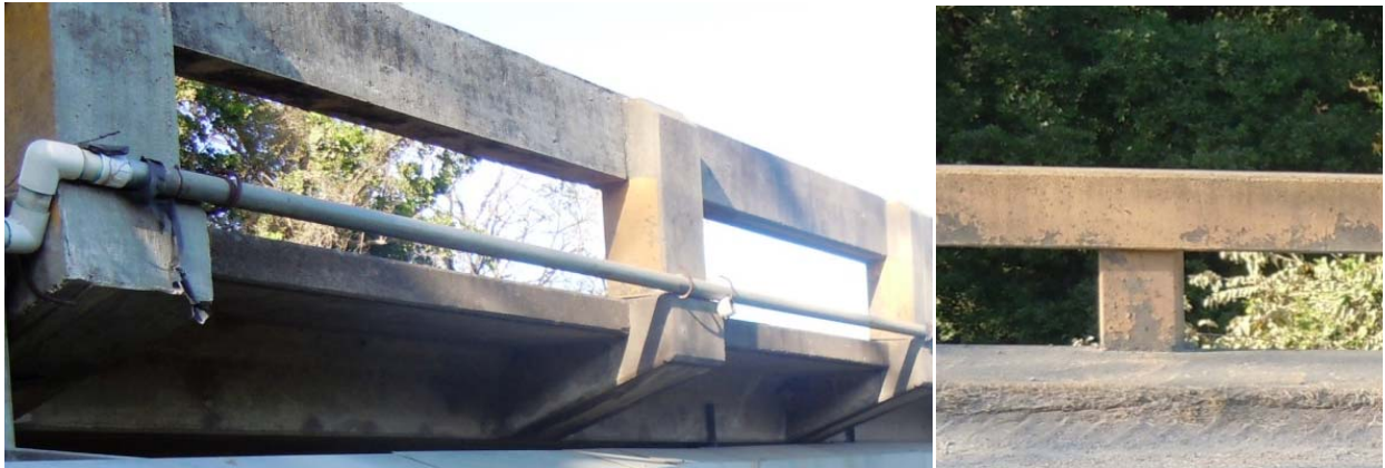
Figura 5: Barrera de concreto reforzado que se recomienda reforzar o sustituir para que cumpla con los requerimientos de una tipo TL-4 según AASHTO LRFD 2012.
