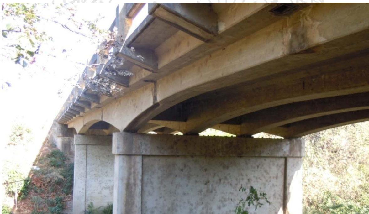
Figura 3: Vista lateral del puente sobre el río Montenegro.
