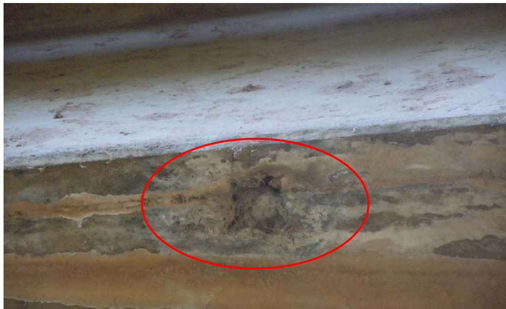
Figura 21: Hormiguero en viga principal.
