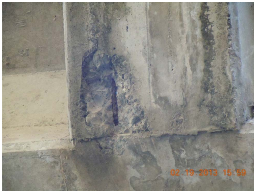
Figura 9: Acero de refuerzo expuesto en el voladizo de la barrera.
