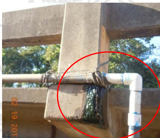
Figura 8: Fuga de la tubería de servicio que afecta una sección de la barrera en el sector sureste.
