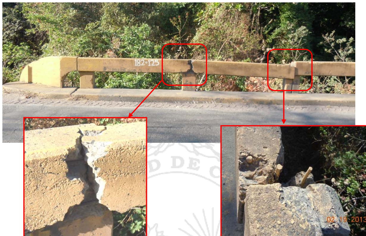
Figura 7: Secciones dañadas de la barrera en el sector noroeste.
