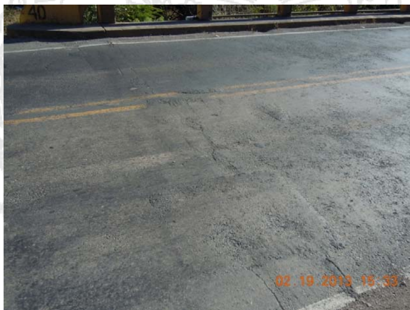
Figura 18: Juntas de expansión obstruidas, caso del bastión 1.
