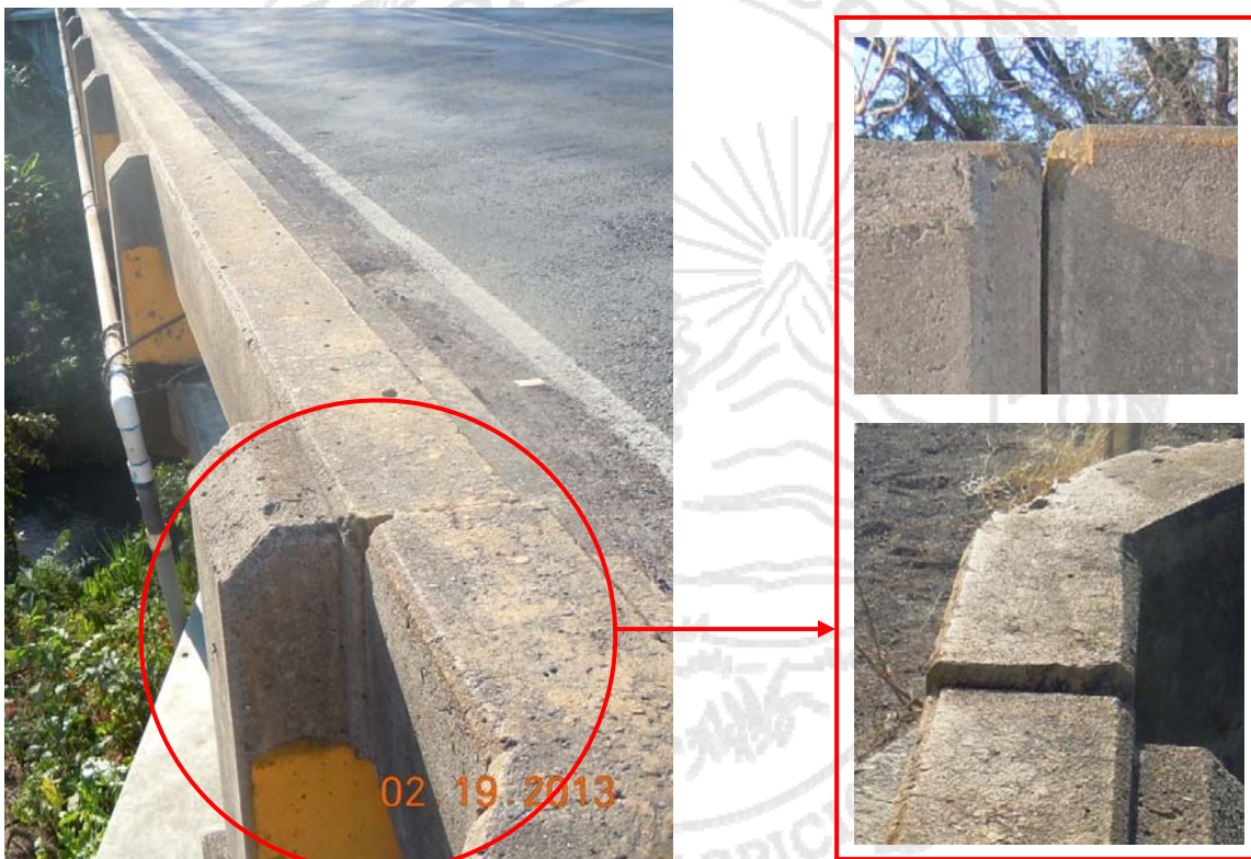
Figura 6: Desniveles y diferencias en el alineamiento de la barrera con respecto a los remates de concreto de los bastiones.
