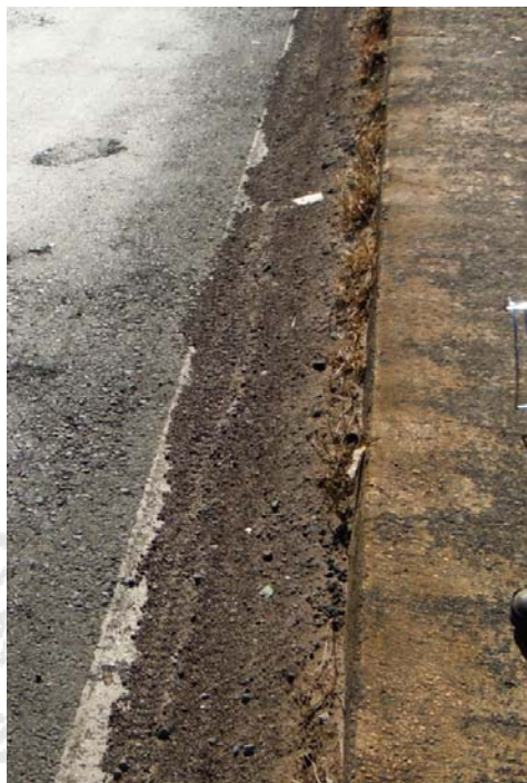
Figura 15: Acumulación de sedimentos a lo largo de los bordillos de seguridad y obstrucción de una parte de los drenajes del puente, sentido Cañas-Bagaces.
