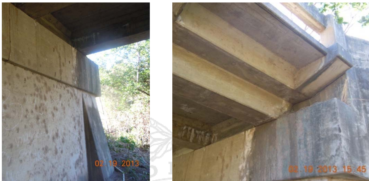
Figura 19: Filtraciones a través de los extremos de las juntas de expansión, caso del bastión 2 hacia Bagaces.
