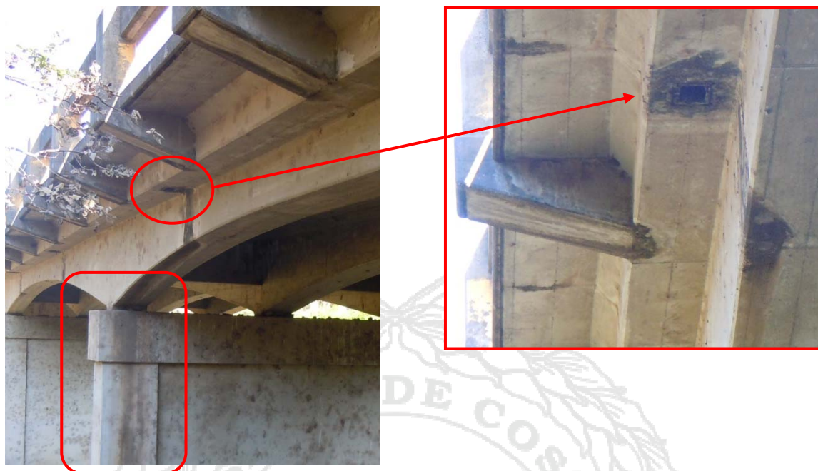
Figura 17: Desagüe de los drenajes cae directamente sobre las vigas de concreto y en algunos casos fluye hasta las pilas.
