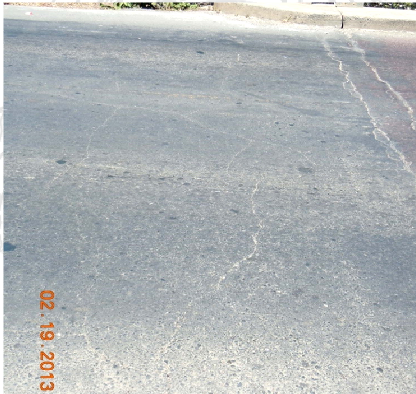
Figura 12: Agrietamiento en dos direcciones en la superficie de rodamiento de los accesos, caso del lado hacia Cañas.
