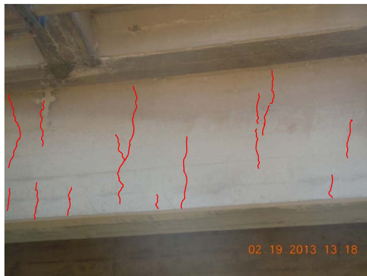
Figura 21: Grietas por retracción y fraguado en la superficie exterior de las vigas principales externas de la superestructura 1.
