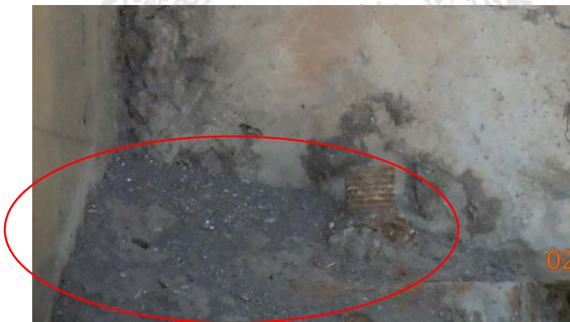
Figura 29: Acumulación de sedimentos alrededor de los apoyos, Bastión 2.
