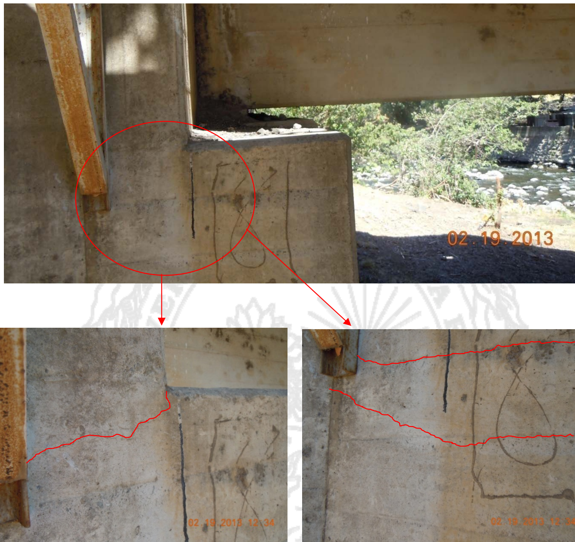
Figura 30: Agrietamiento en la viga cabezal, Bastión 2.
