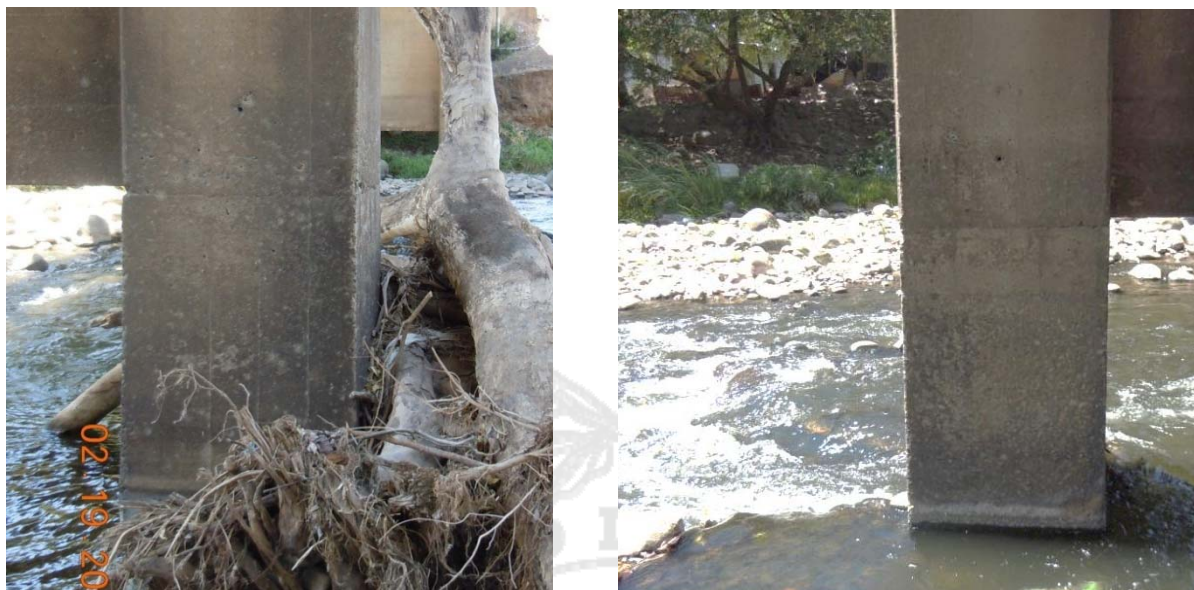
Figura 31: Abrasión de la superficie y acumulación de objetos en las columnas de la pila, Pila 1.
