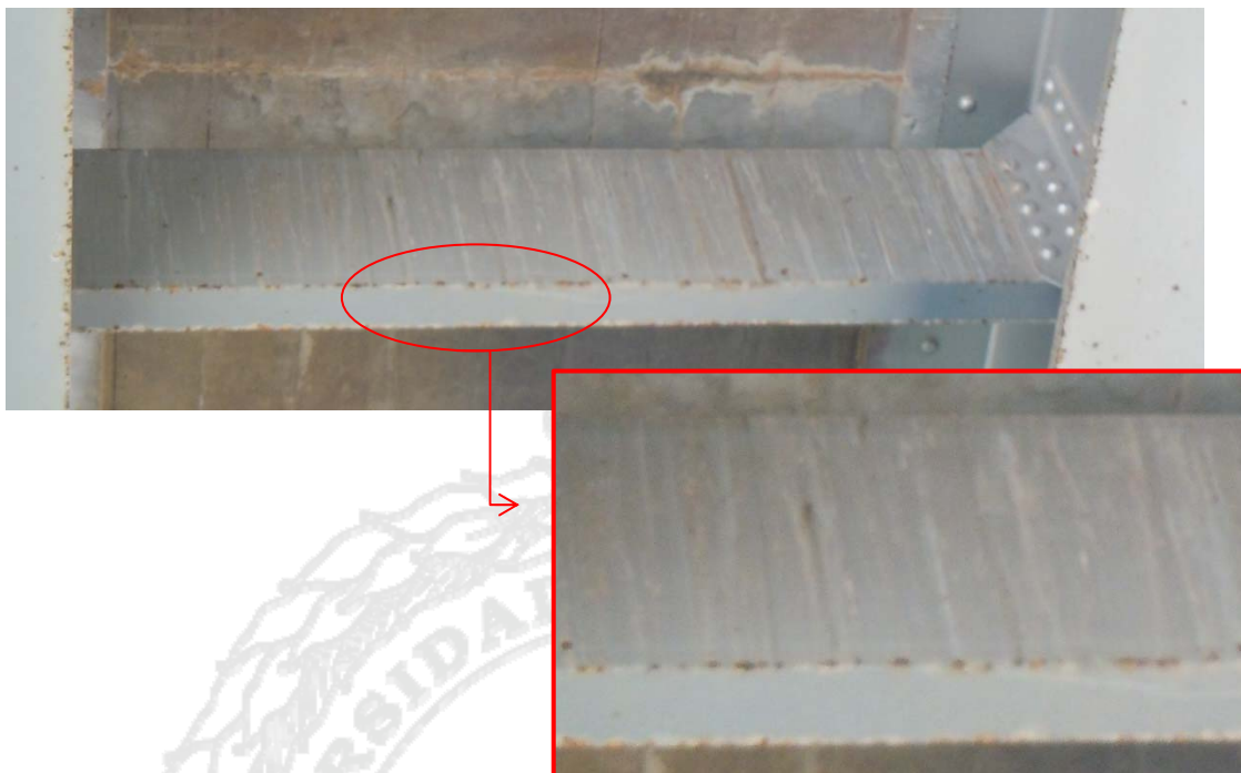
Figura 26: Oxidación y comienzos de corrosión en los bordes de las vigas diafragma de acero.
