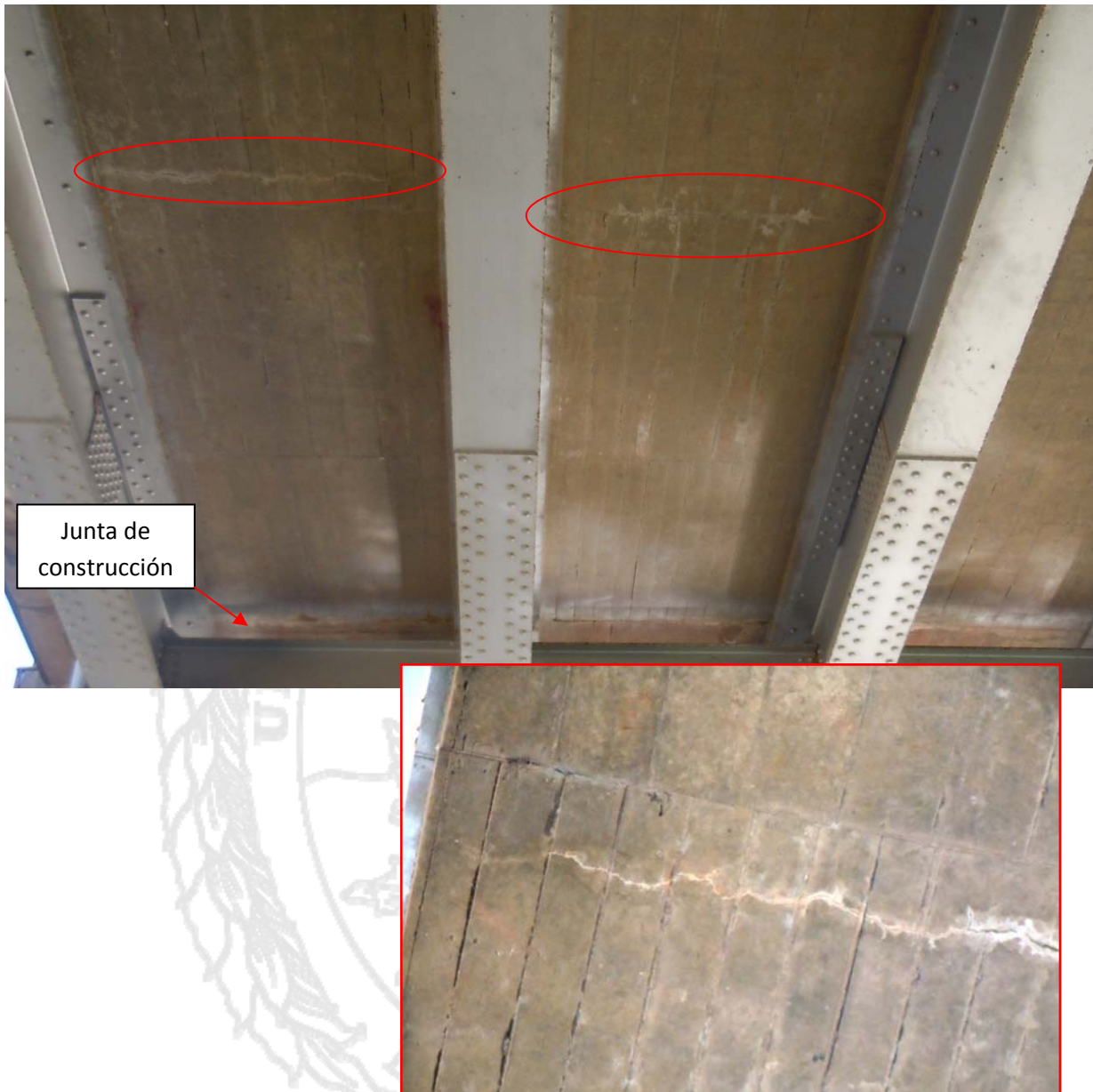
Figura 23: Grietas transversales con eflorescencia en la losa de la superestructura de acero.
