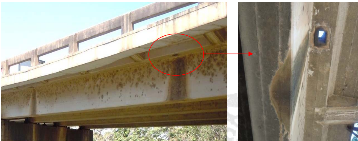
Figura 15: Falta de tubos de extensión de los drenajes debajo de las superestructuras de concreto.
