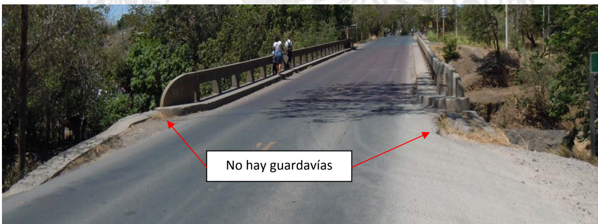
Figura 6: Faltante de guardavías en los accesos, caso del lado hacia Lagartos.
