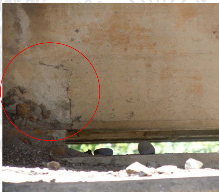
Figura 22: Grietas en la viga principal de concreto por concentración de esfuerzos en los apoyos debido a la restricción al movimiento longitudinal, Bastión 2.
