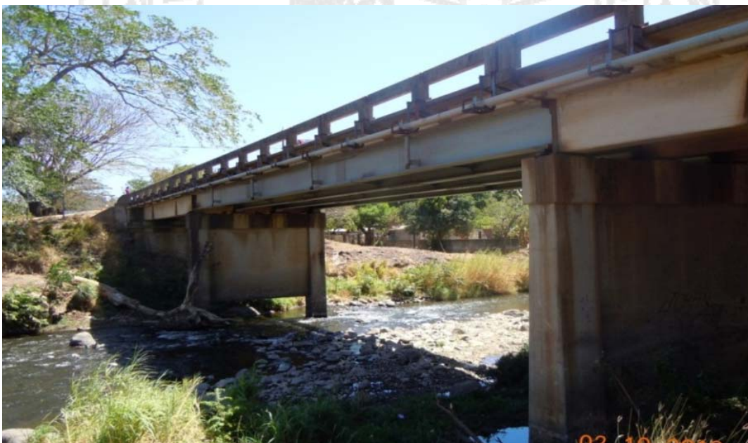
Figura 3: Vista lateral del puente sobre el río Cañas.
