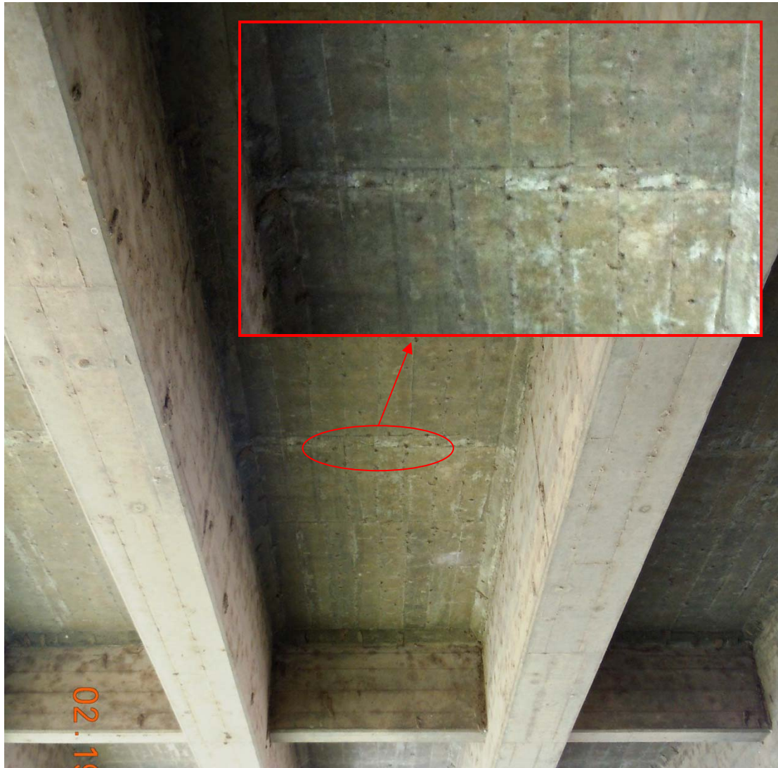
Figura 20: Eflorescencia en la junta de construcción en la losa de la superestructura 1.
