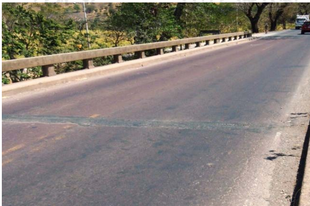
Figura 8: Demarcación horizontal borrosa y falta de cataluces en la línea centro.
