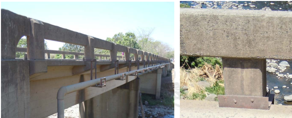
Figura 5: Barrera de concreto reforzado que se recomienda reforzar o sustituir para que cumpla con los requerimientos de una tipo TL-4 según AASHTO LRFD 2012.
