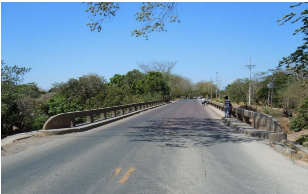
Figura 2: Vista a lo largo de la línea de centro del puente sobre el río Cañas.
