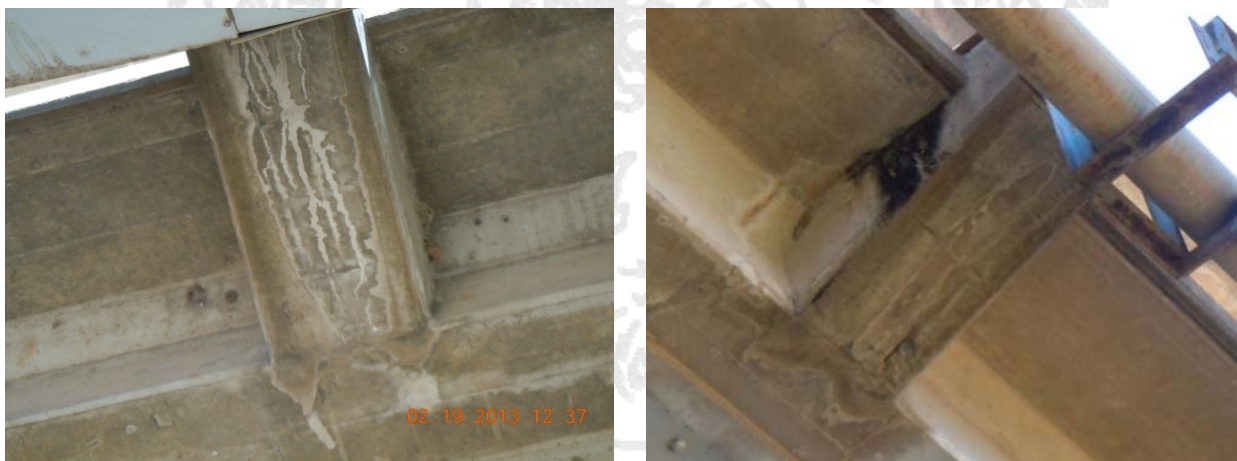
Figura 14: Filtraciones de agua llovida por las barreras.
