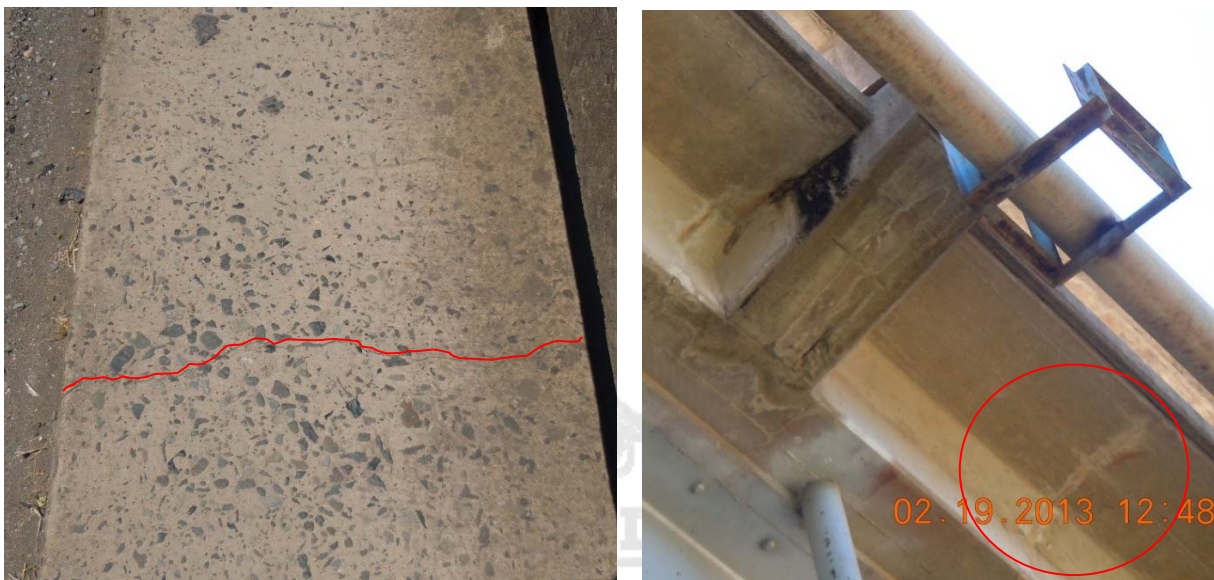
Figura 7: Agrietamiento en el bordillo de seguridad en la superestructura 2, sentido Lagartos-Cañas.
