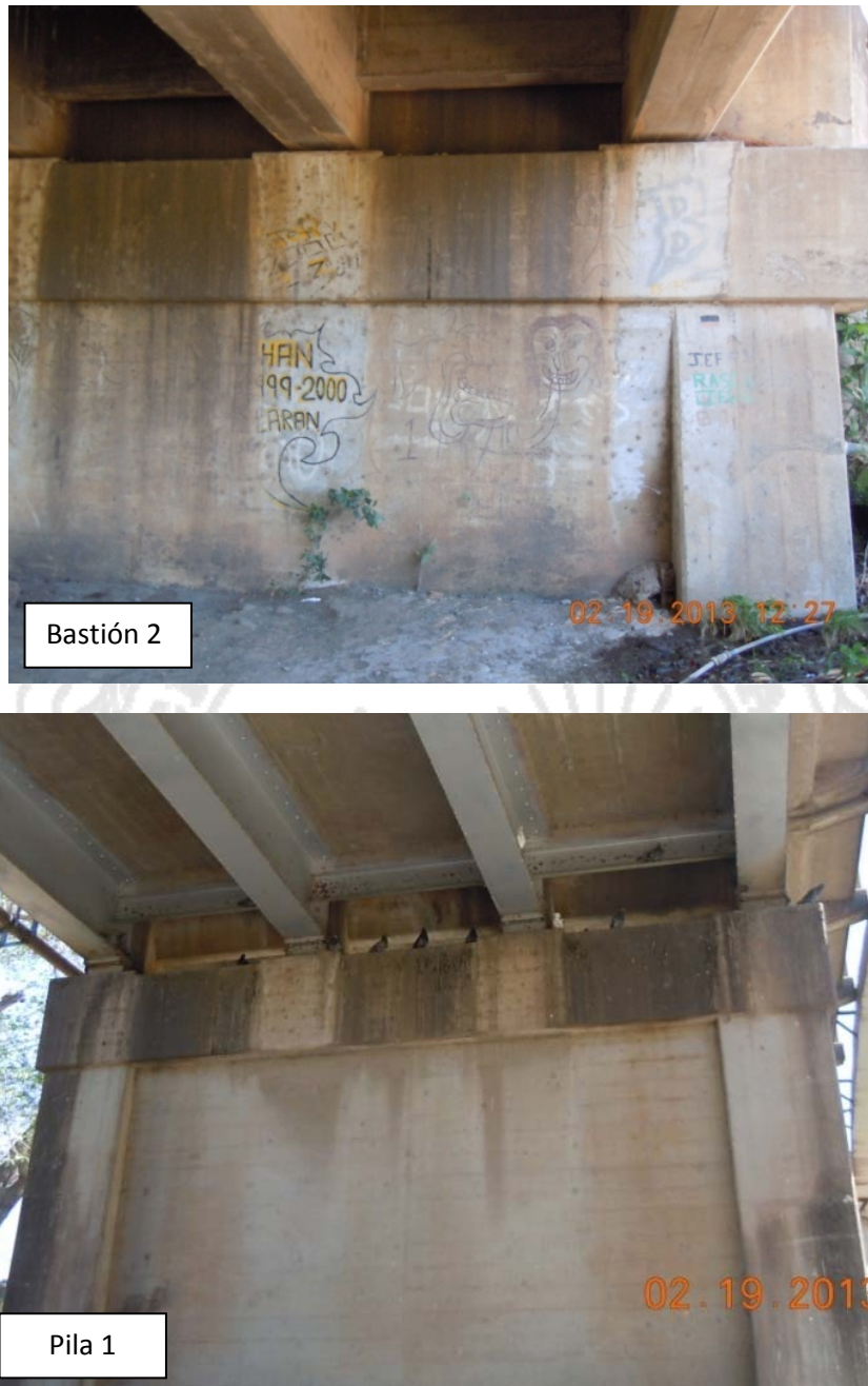
Figura 19: Filtraciones a través de las juntas de expansión en bastiones y pilas.
