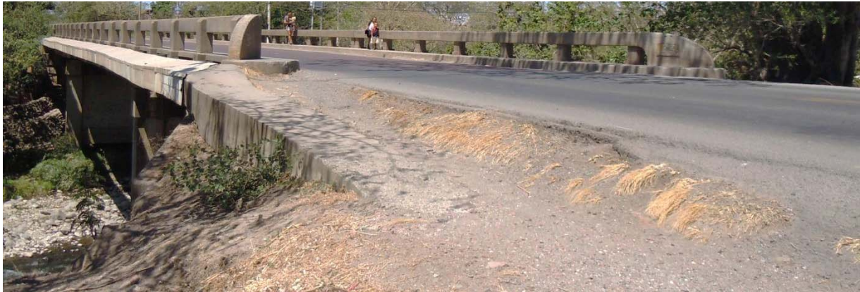
Figura 11: Falta de sistema de drenaje en los accesos, Bastión 1 – hacia Lagartos.
