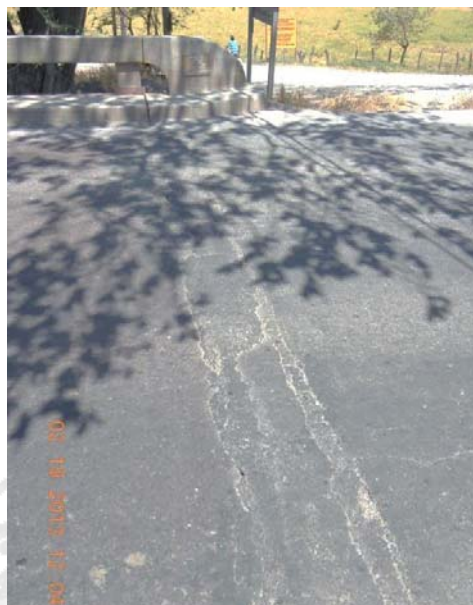
Figura 17: Juntas de expansión obstruidas del acceso del lado hacia Lagartos.
