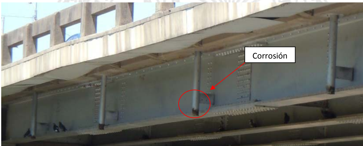
Figura 16: Extensión de los drenajes mostrando corrosión del tubo de desagüe debajo de la superestructura de acero.
