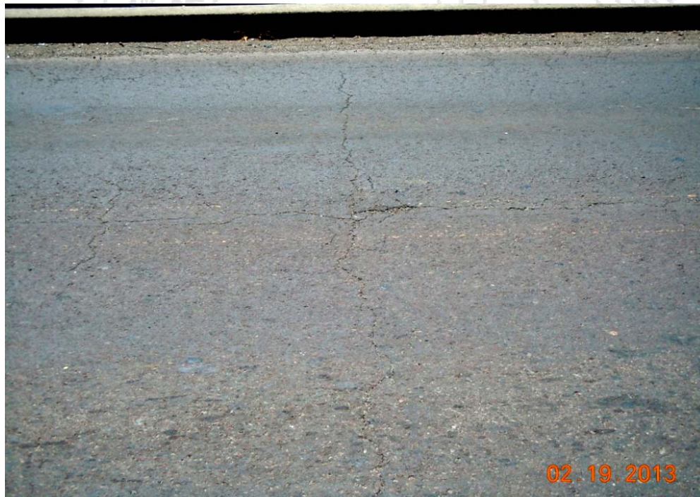
Figura 10: Agrietamiento longitudinal y transversal de la carpeta asfáltica.
