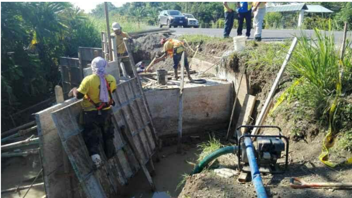
Figura 14. Vista lateral mostrando la extensión de la alcantarilla y el encofrado de los aletones.
