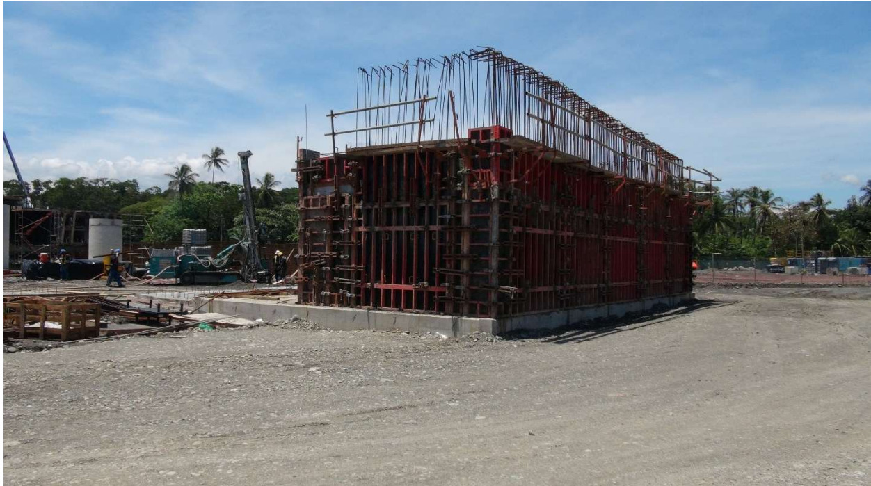
Figura 6. Construcción del bastión norte del Viaducto Oeste
