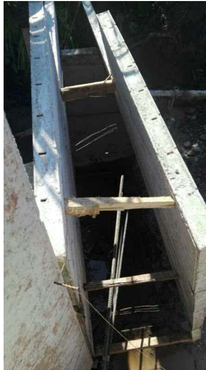
Figura 15. Acero de refuerzo de los aletones. Se observa acero de refuerzo proveniente del cajón de la alcantarilla.
