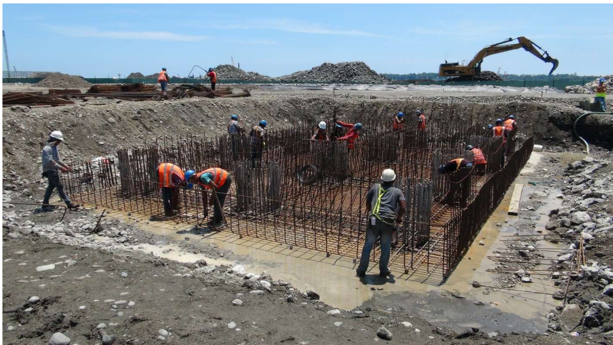
Figura 2. Vista del acero de refuerzo de la cimentación de una pila del Viaducto Este
