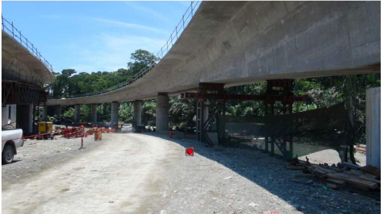
Figura 9. Vista general en el sentido sur del Viaducto Oeste.
