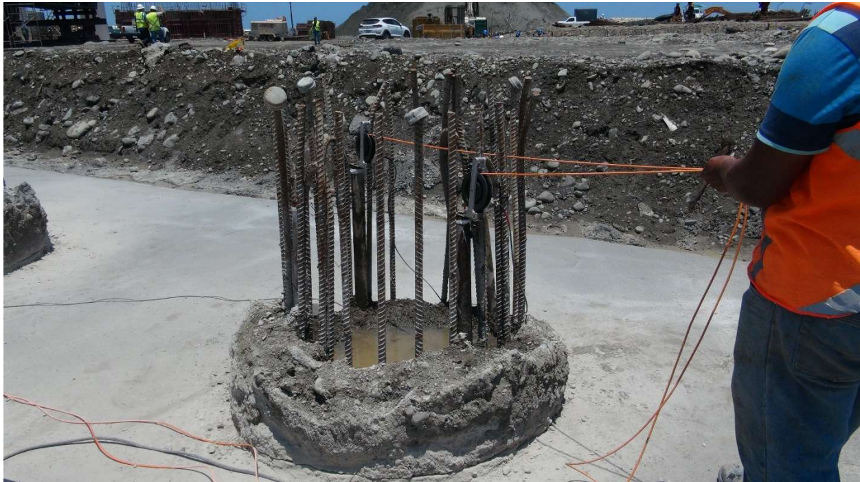
Figura 3. Ensayos realizados a los pilotes de cimentación de una pila del Viaducto Este
