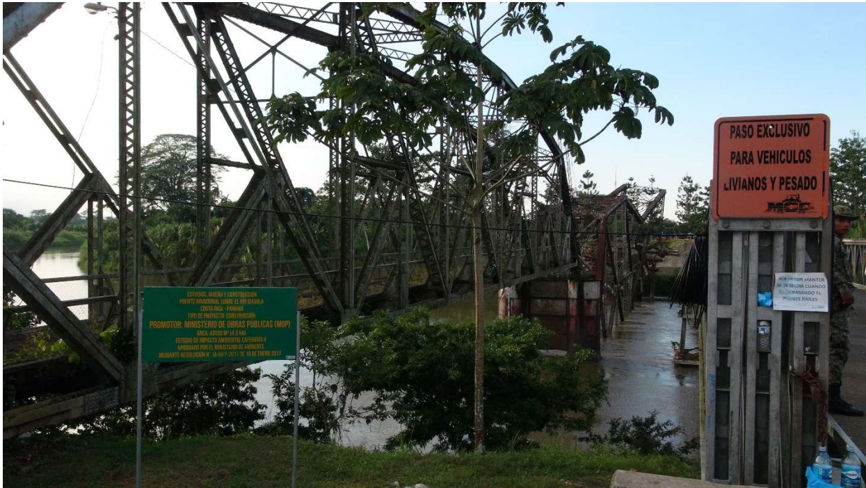
Figura 11. Vista del puente en el sentido norte (desde Panamá).
