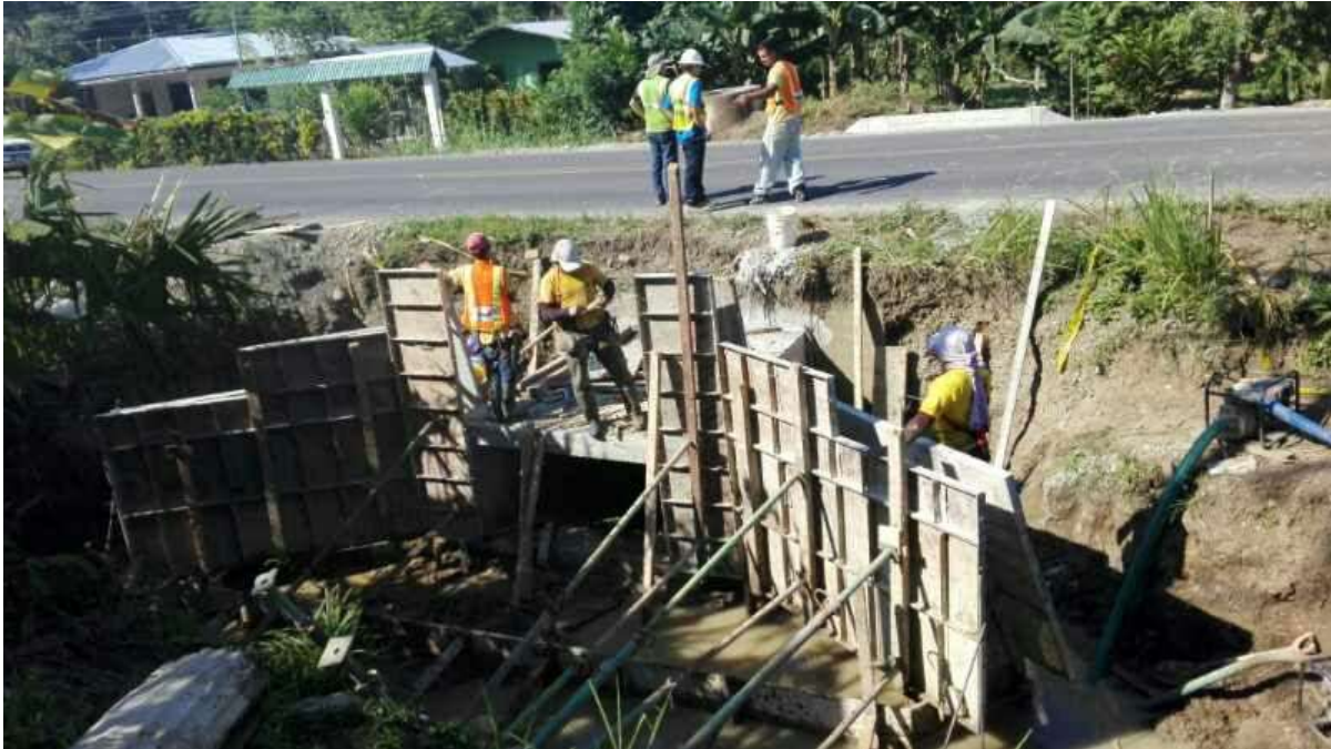
Figura 13. Extensión de la alcantarilla existente
