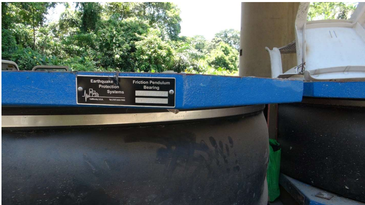
Figura 8. Tipo de apoyos utilizados en el proyecto
