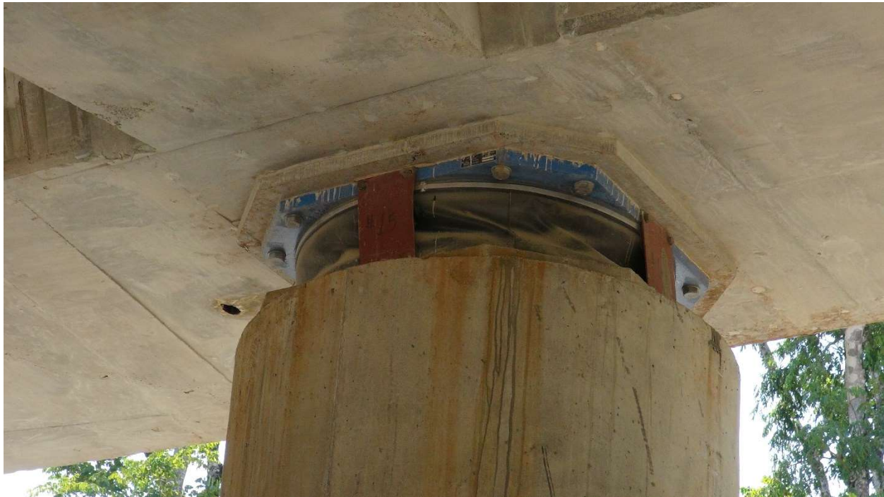
Figura 7. Vista del apoyo sobre la columna de una pila del Viaducto Oeste
