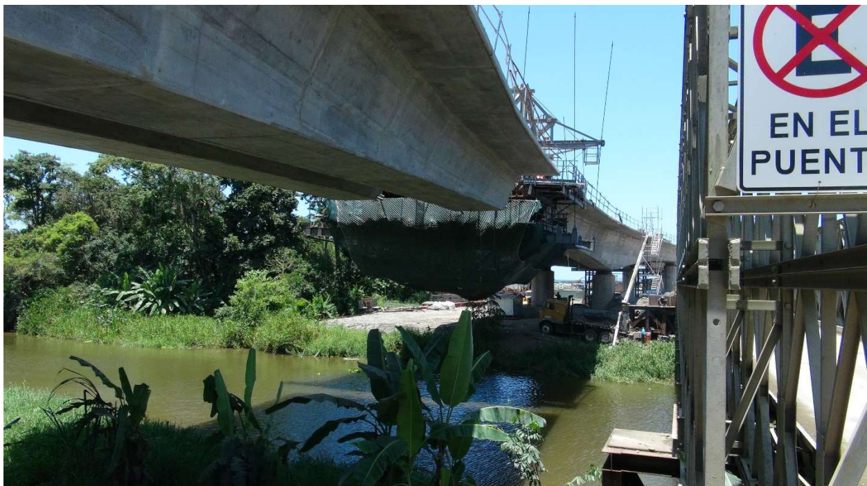
Figura 10. Construcción de la superestructura sobre el Río Moin para el Viaducto Oeste. Vista en el sentido norte.
