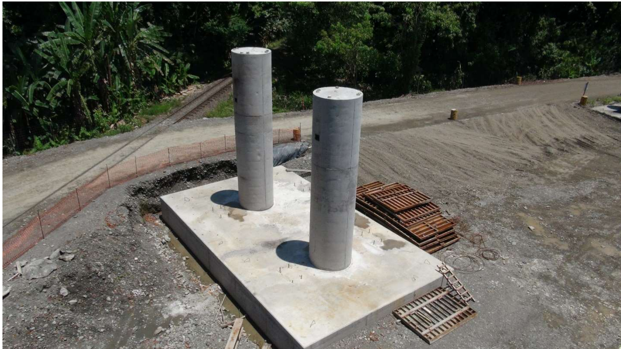
Figura 5. Columnas de una pila del Viaducto Este.
