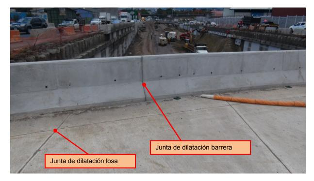
Figura 1. Las juntas de dilatación de la barrera no coindice con la junta de las losa. Puente-Este
