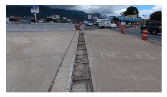
Figura 4. Falta instalar las juntas de expansión.
