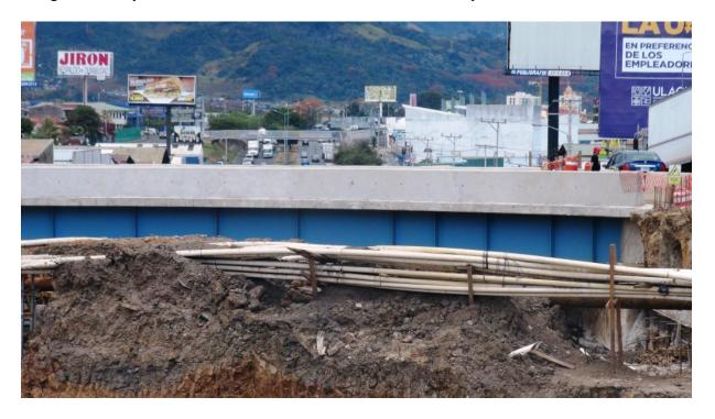
Figura 2. La barrera vehicular es continua en ambos puentes
