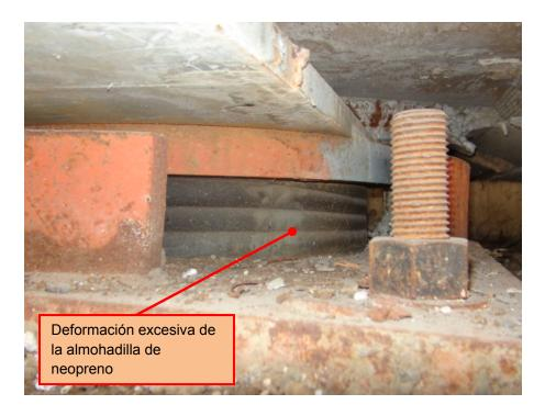
Figura 11. Deformación lateral excesiva en almohadilla de neopreno. Puente-Oeste - Bastión-Norte
