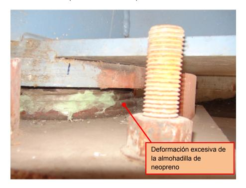
Figura 9. Deformación lateral excesiva en almohadilla de neopreno. Puente-Este - Bastión-Norte
