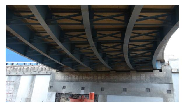
**Figura 3.** Se requiere realizar la limpieza de los elementos de acero de la superestructura de cada puente.
