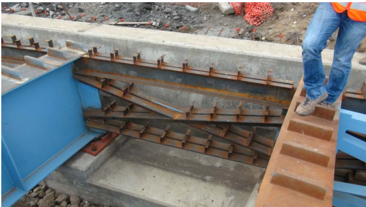
Figura 9. Marco arriostrado del puente Oeste en el extremo Sur antes de su confinamiento con acero de refuerzo.
