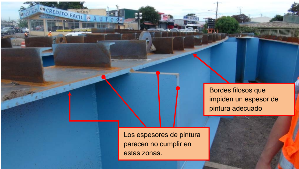
Figura 7. Acercamiento mostrando las vigas del puente Este a la espera de ser instaladas.
