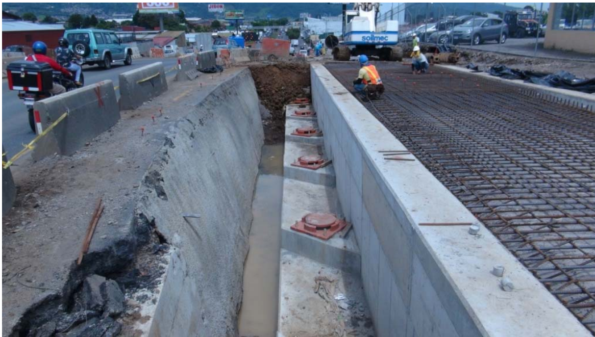
Figura 12. Línea de apoyos de disco del puente Este (extremo Norte) y preparación del armado de la losa de aproximación.
