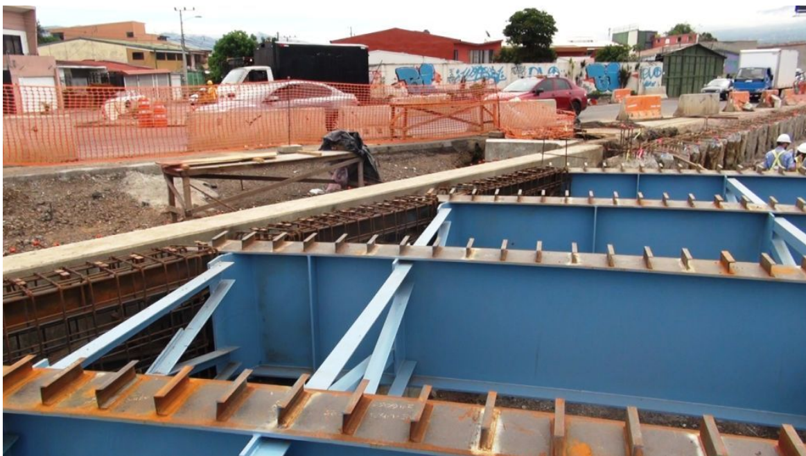
Figura 5. Avance en la construcción del puente Oeste(extremo norte)
