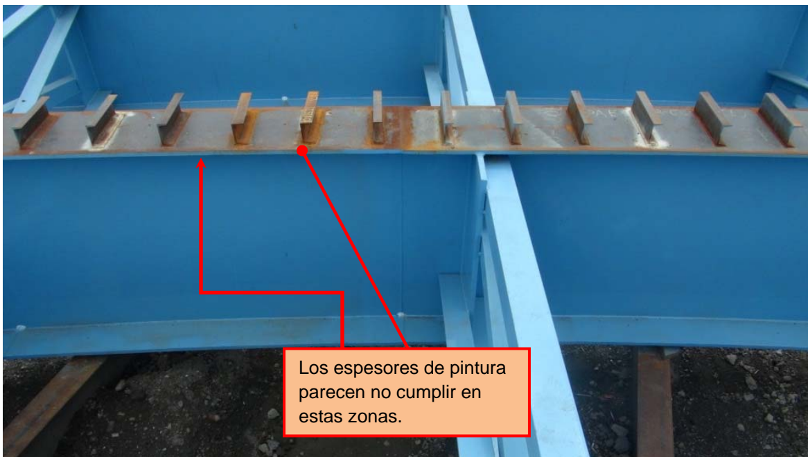
Figura 13. Vigas del puente Este a la espera de ser instaladas.
