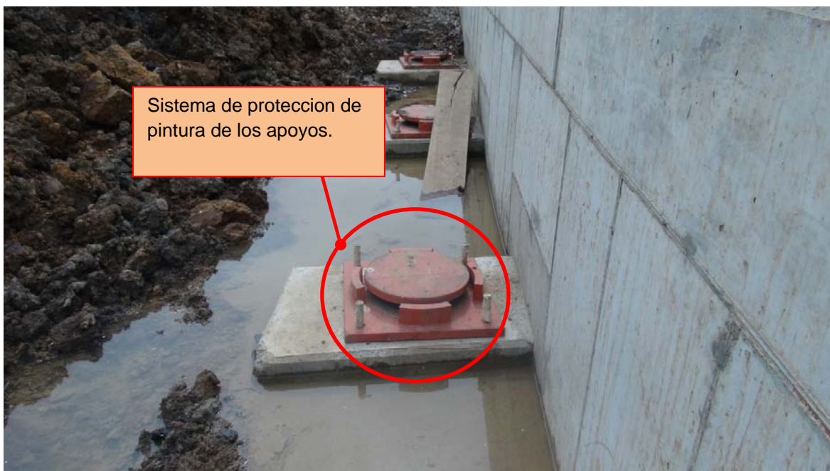
Figura 8. Vista de la línea de apoyos de disco del puente Este en el extremo Sur.
