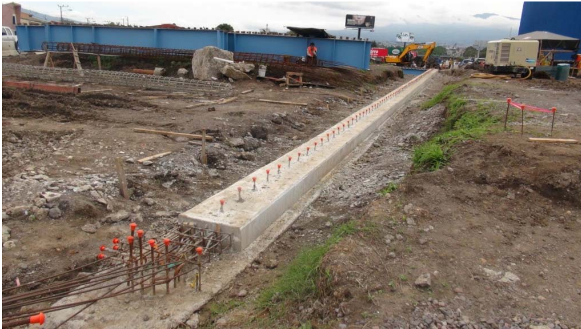
Figura 6. Vigas de acero del puente Este a la espera de ser instaladas.
