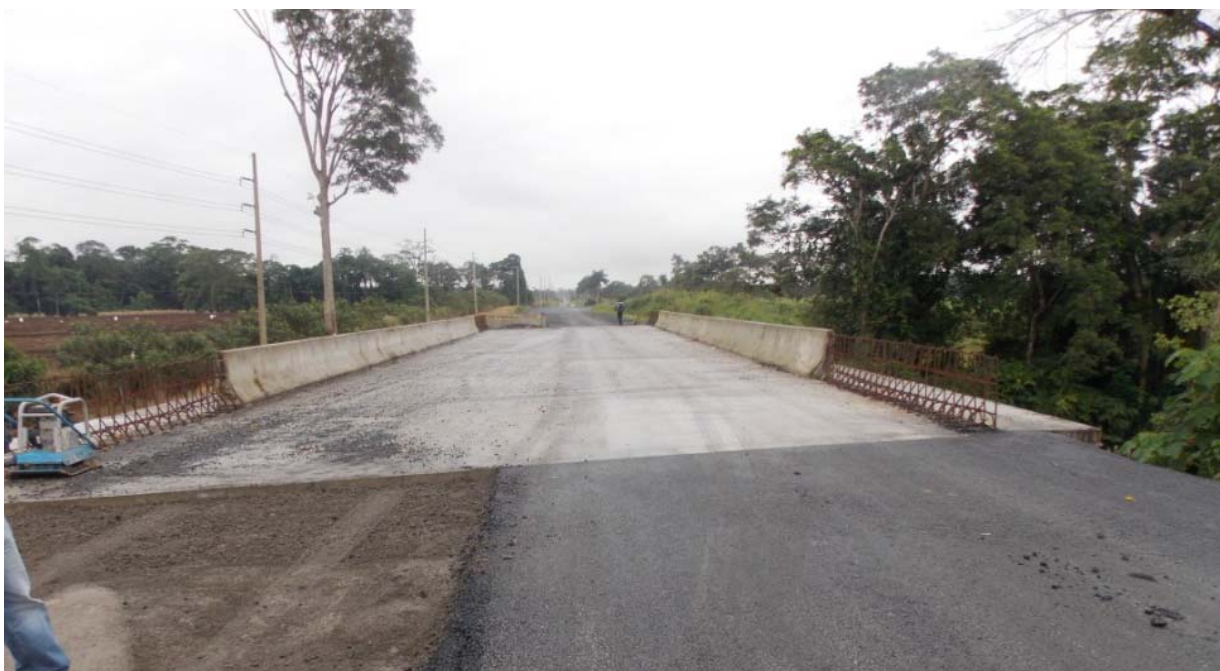
Figura 39: El borde de la losa de de aproximación en contacto con la carpeta asfáltica no contaba con angular de protección. Puente sobre la Quebrada Pericos.
