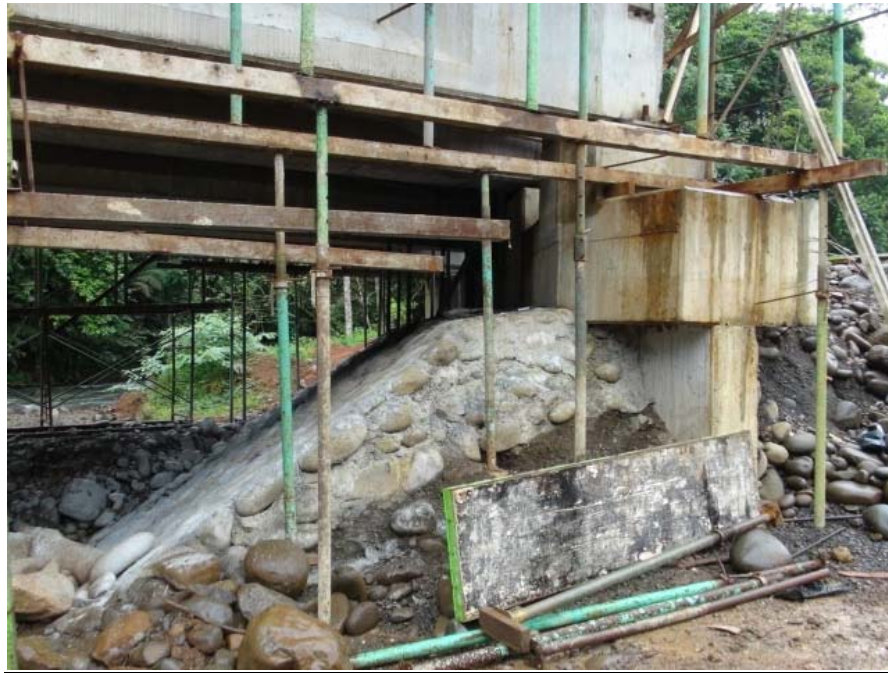
Figura 27: Construcción del enrocado para protección (escollera) de los bastiones del puente sobre el Rio Caño Negro.
