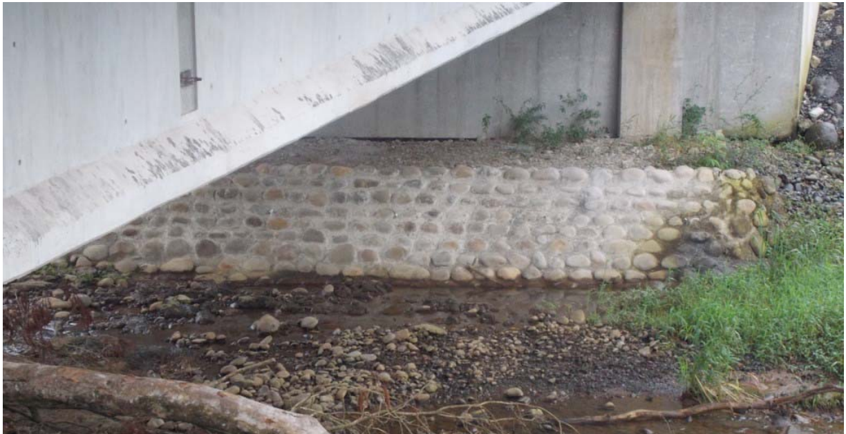
Figura 40: El enrocado se construyó frente al cuerpo del bastión únicamente. La protección no se extiende a los costados del bastión. Puente sobre la Quebrada Pericos.
