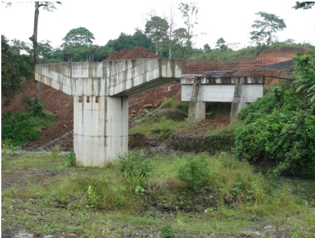
Figura 4: Vista lateral del puente sobre el Rio Cuarto
