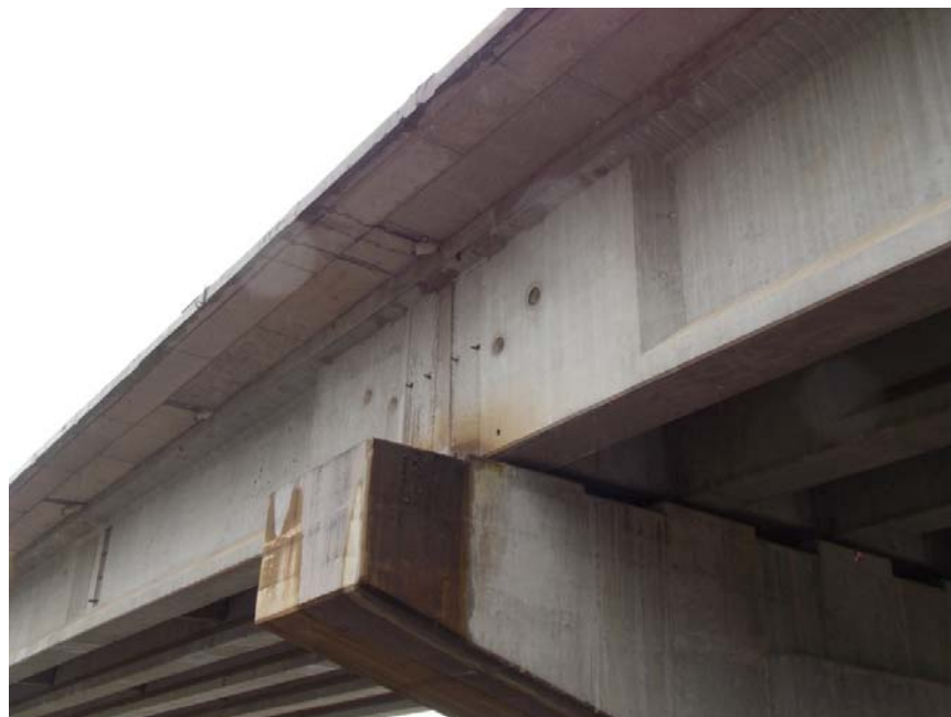
Figura 28: Indicios de que el agua descarga sobre la pila del puente sobre el Rio Toro
