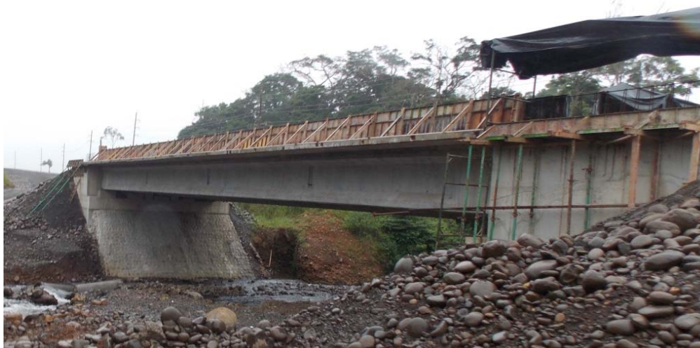
Figura 41: Construcción de barrera vehicular y la acera sobre los alerones de los bastiones. Se observa el enrocado frente al talud del bastión. Puente sobre Quebrada Campamento.
