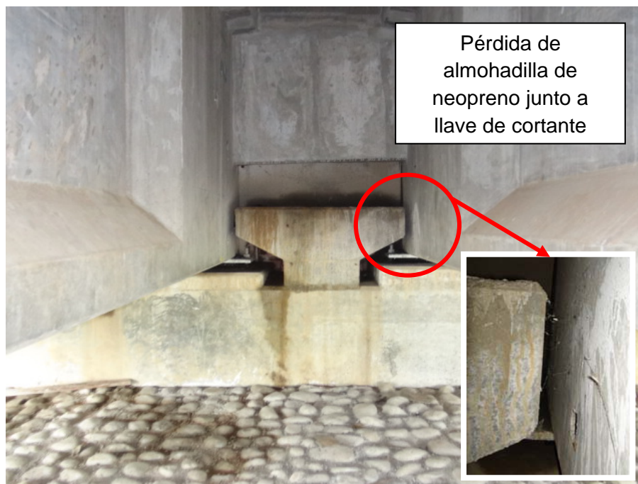
Figura 32: Pérdida de la almohadilla de neopreno que se adhiere a la viga principal junto a uno de los conectores de cortante del bastión-este. Puente sobre el Río Toro.
