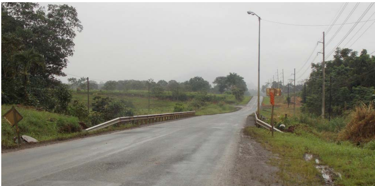
Figura 15: Vista a lo largo de la línea de centro del puente sobre el Río Tres Amigos.
