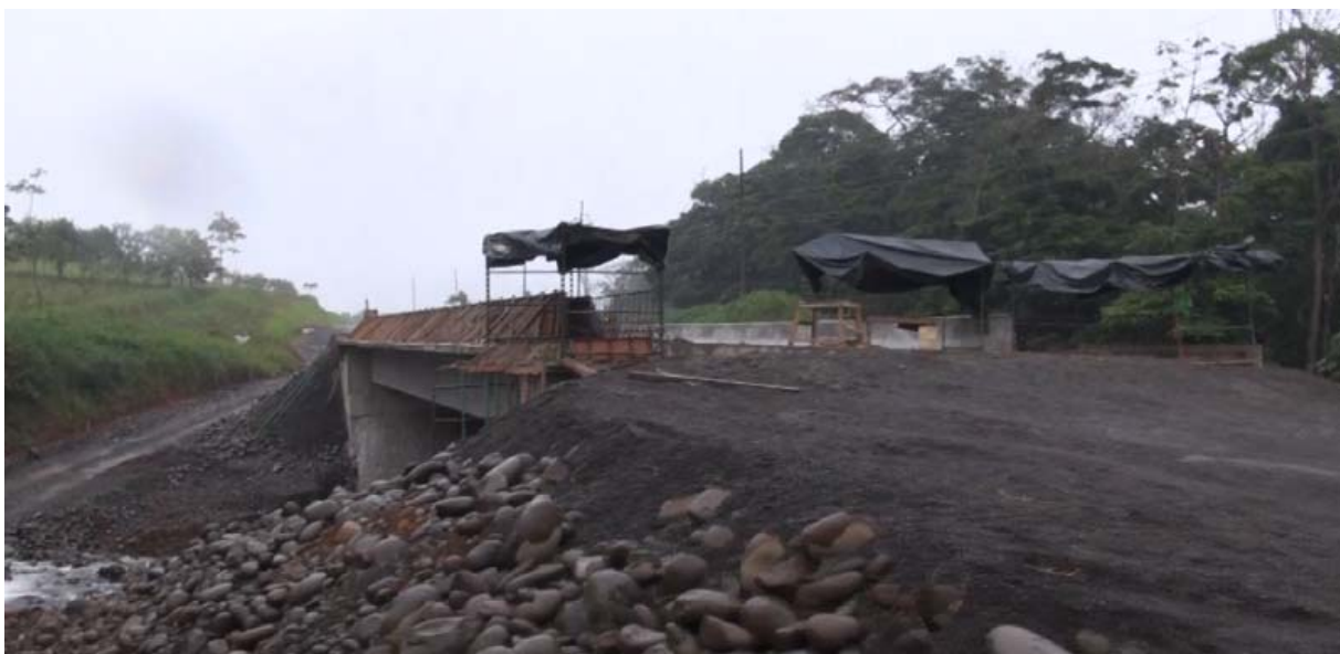
Figura 21: Vista a lo largo de la línea de centro del puente sobre la Quebrada Campamento
