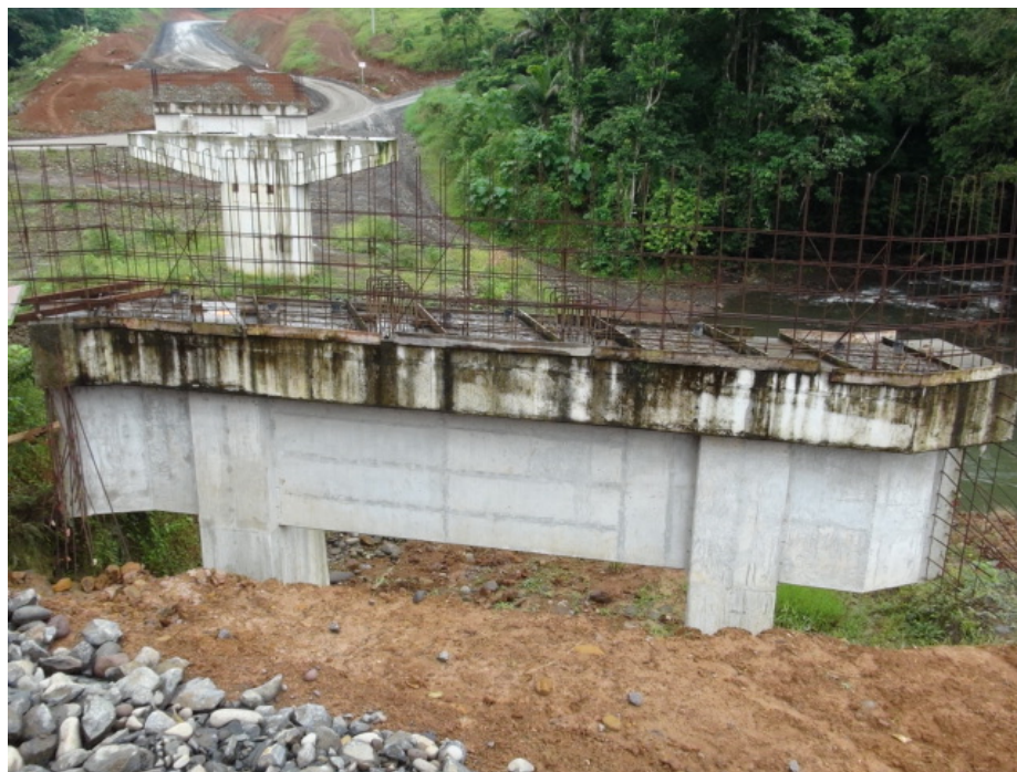
Figura 25: Faltaba construir los aletones, viga cabezal y pedestales de concreto de los bastiones del puente sobre el Rio Cuarto.
