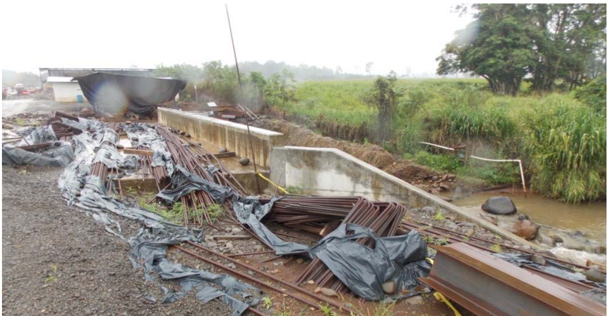
Figura 33: Faltaba completar la construcción de la barrera vehicular, la baranda peatonal y la acera. Alcantarilla sobre la Quebrada San Pedro.
