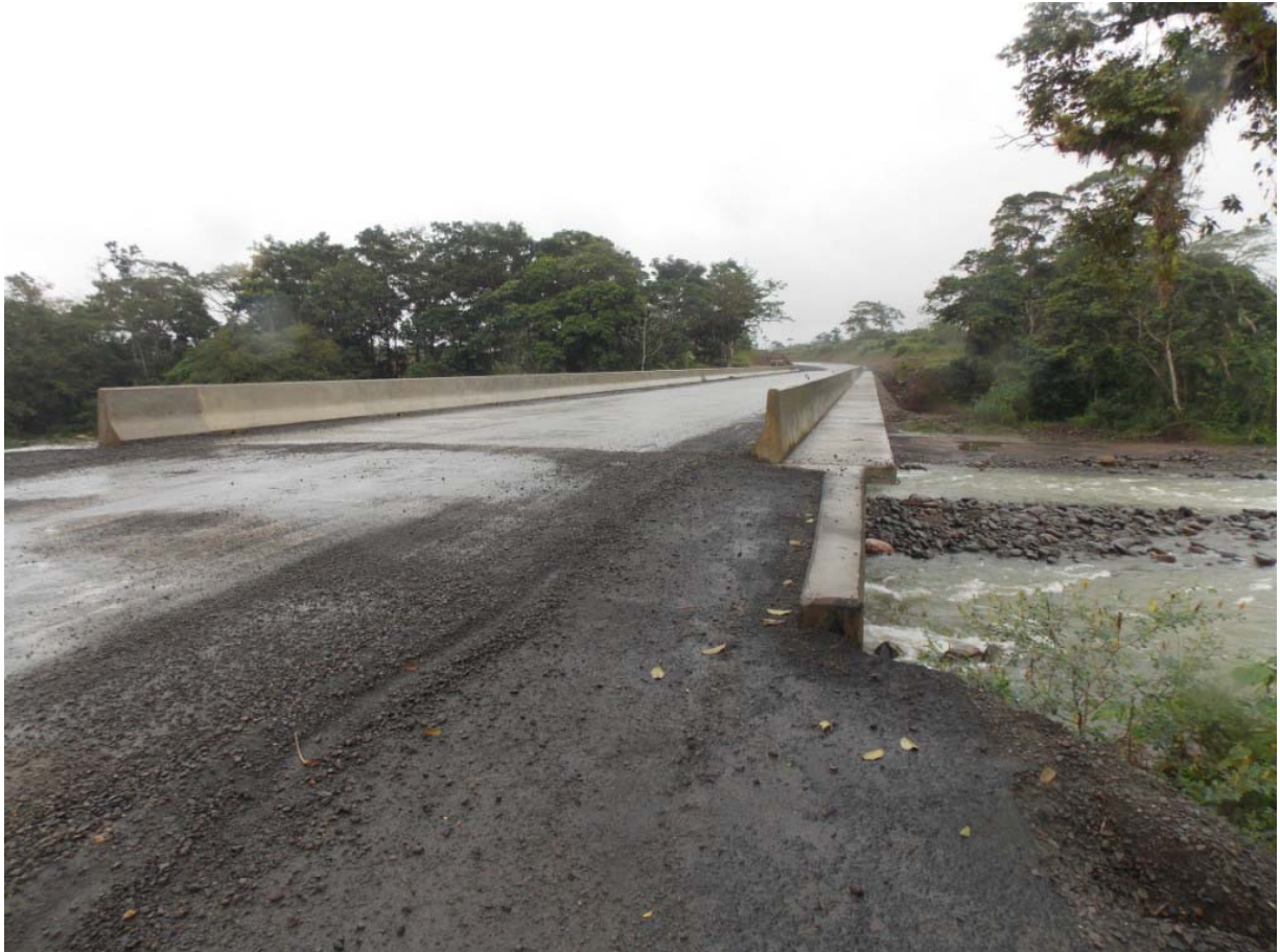
Figura 9: Vista a lo largo de la línea de centro del puente sobre el Río Toro.
