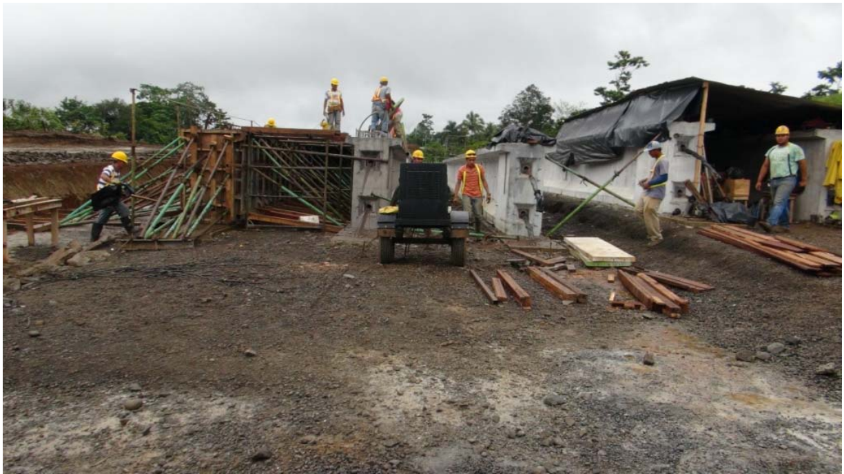
Figura 24: Trabajos en prefabricado y preesfuerzo de las vigas principales del puente sobre el Río Cuarto.
