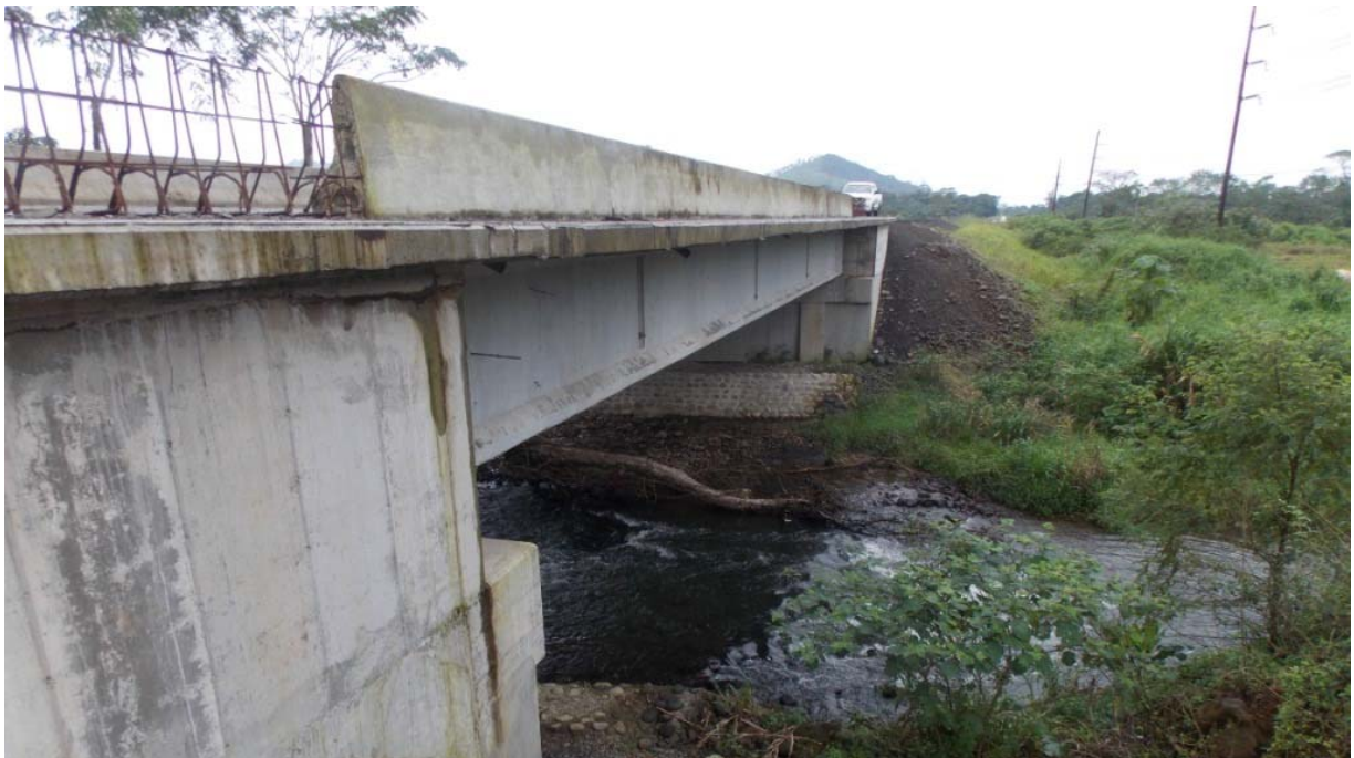
Figura 37: Los tubos de desagüe del puente son muy cortos. Puente sobre Quebrada Pericos.
