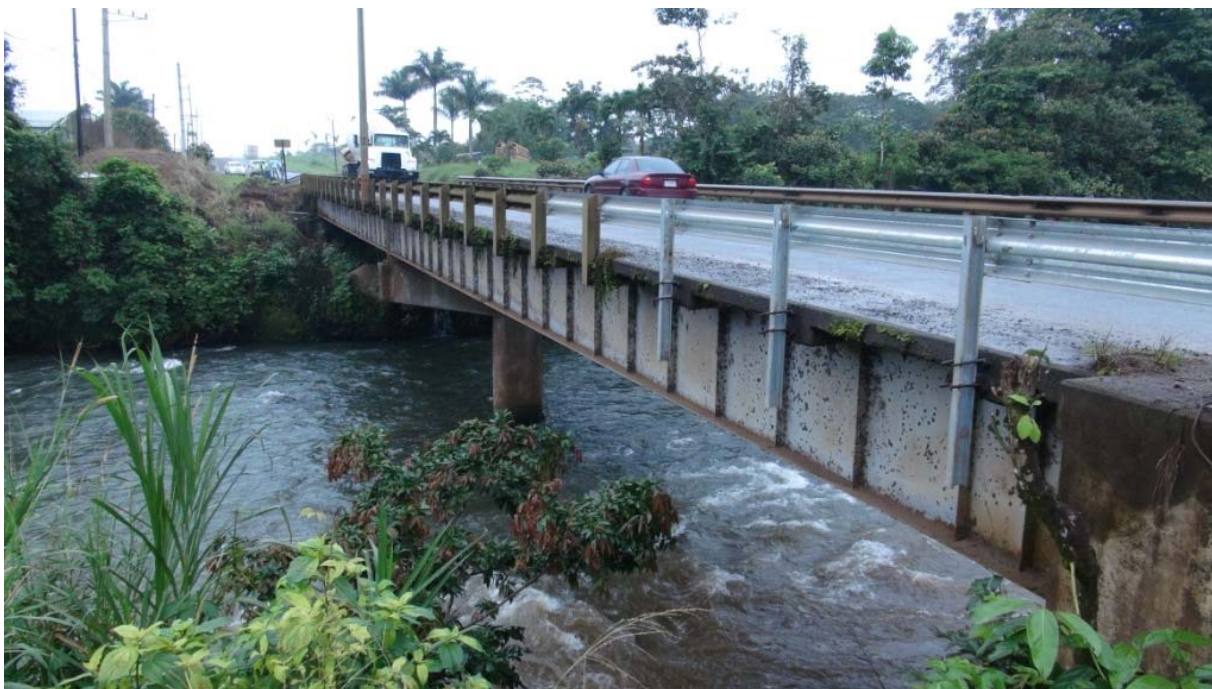
Figura 16: Vista lateral del puente sobre el Río Tres Amigos
