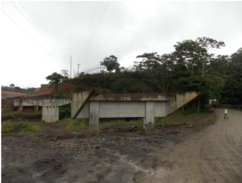
Figura 3: Vista a lo largo de la línea de centro del puente sobre el Río Cuarto
