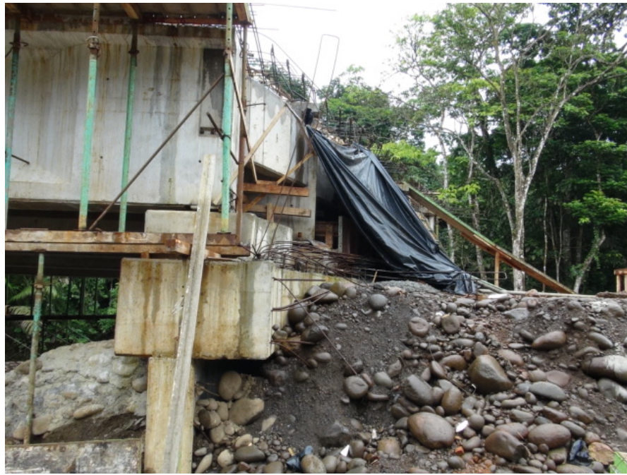
Figura 26: Faltaba construir los aletones, viga cabezal y pedestales de los bastiones del puente sobre el Rio Caño Negro.
