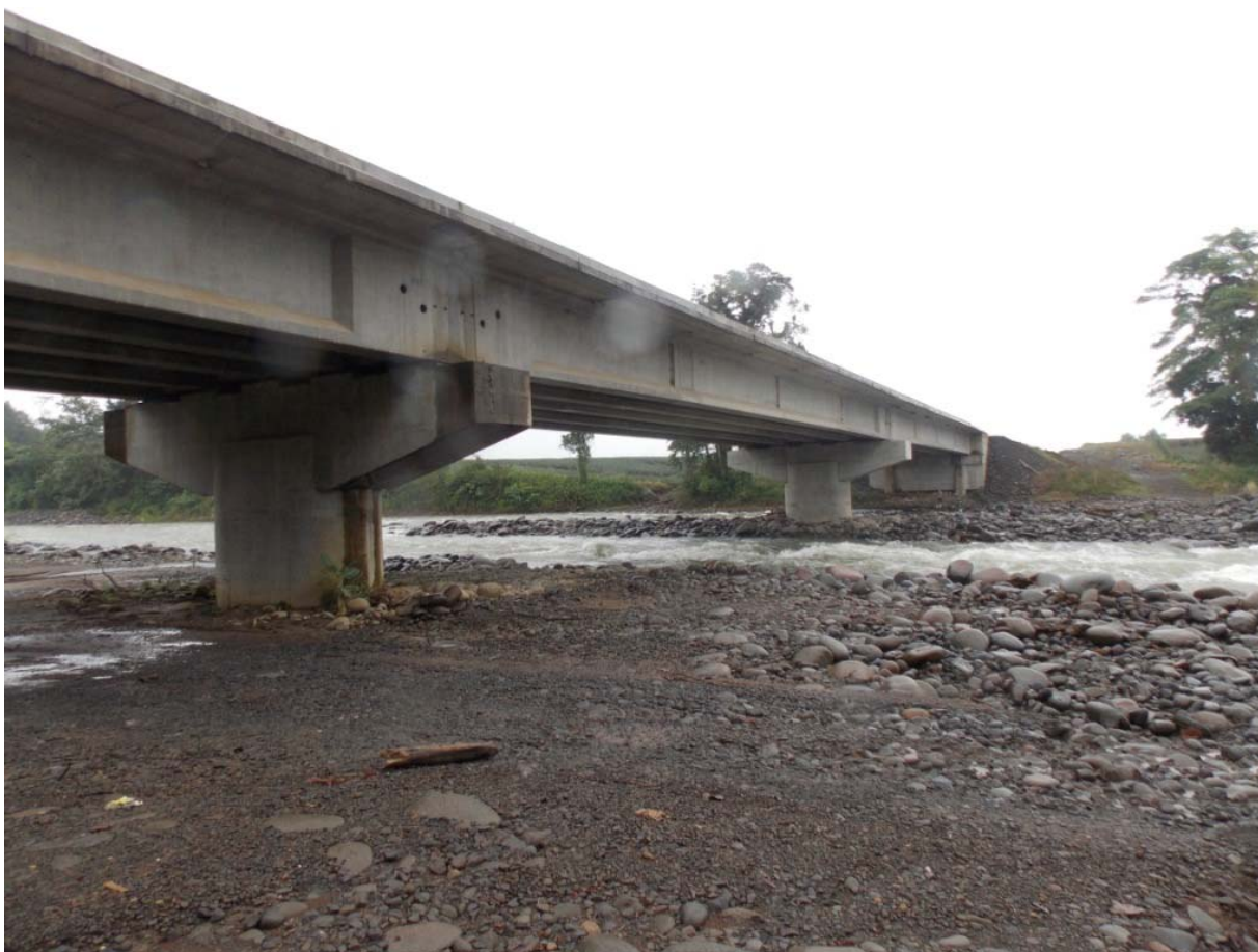
Figura 10: Vista lateral del puente sobre el Rio Toro
