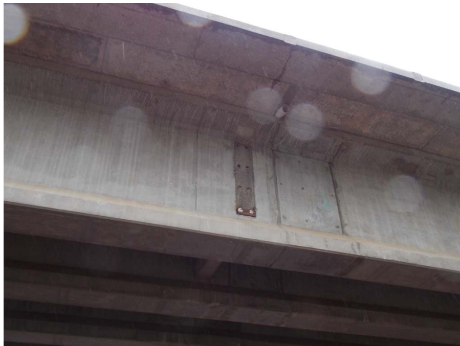
Figura 31: Anclaje inapropiado del acero de refuerzo en las vigas diafragma intermedias. El detalle no coincide con lo indicado en planos. Puente sobre el Rio Toro.
