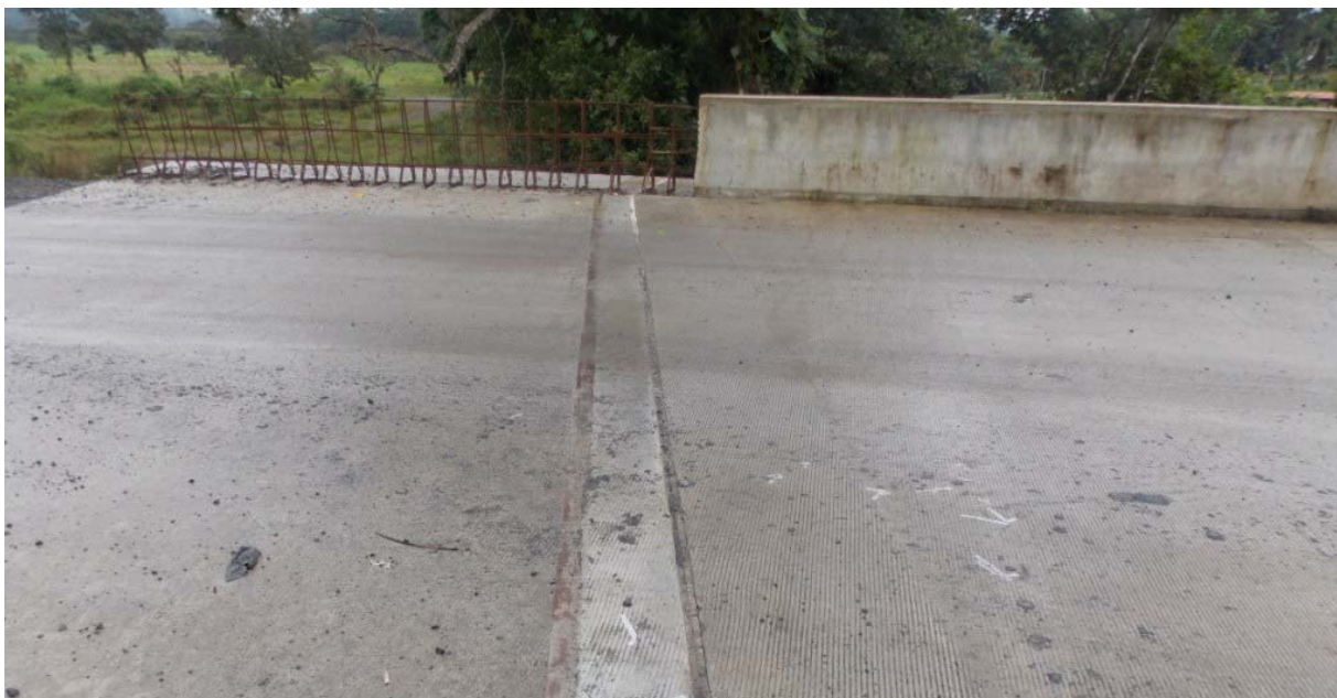
Figura 38: Faltaba colocar el sello de la junta de expansión. Puente sobre la Quebrada Pericos.
