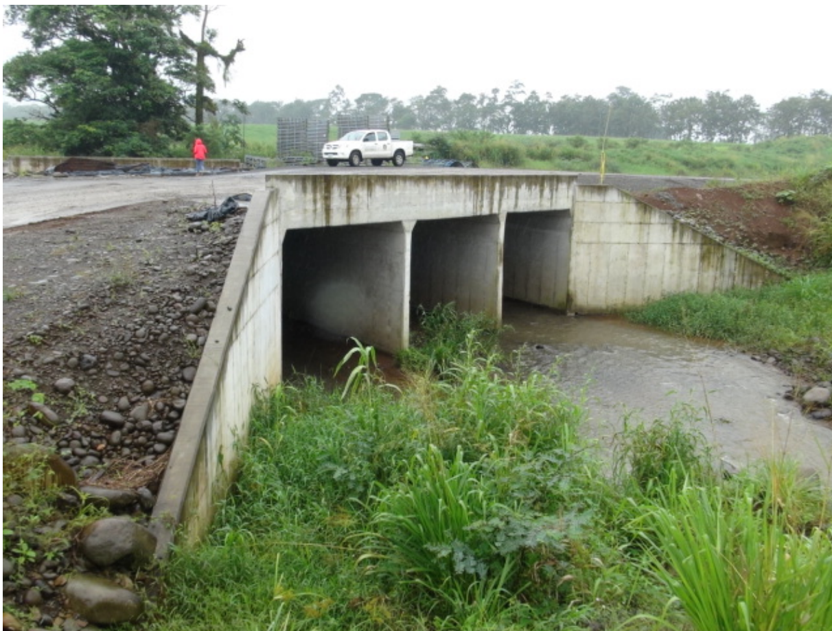
Figura 13: Vista lateral de la alcantarilla sobre la Quebrada San Pedro
