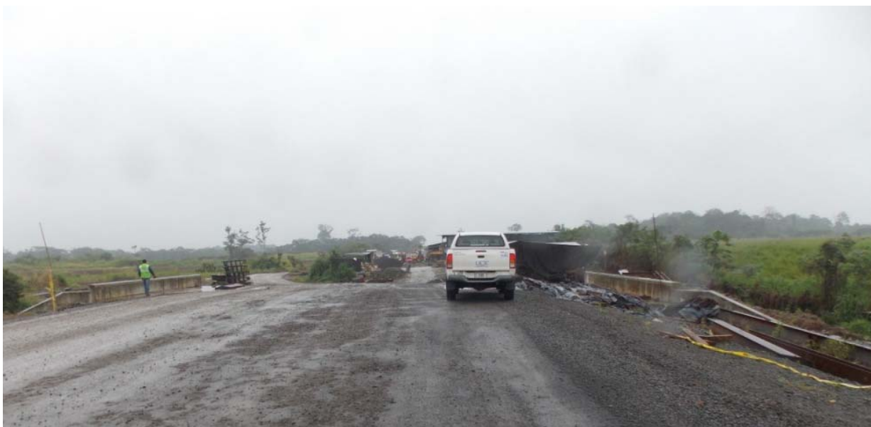
Figura 12: Vista a lo largo de la línea de centro de la alcantarilla sobre la Quebrada San Pedro.
