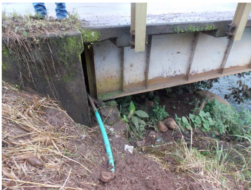
Figura 36: Se observó acumulación de sedimento y humedad alrededor de los apoyos y además corrosión de vigas principales y sus respectivos apoyos mecánicos. Puente sobre el Rio Tres Amigos.
