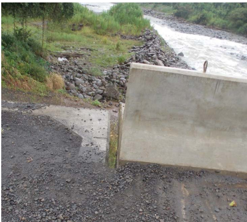
Figura 29: Juntas de expansión sin sello que impida el ingreso de sedimentos y descarga de agua sobre apoyos y la viga cabezal del bastión del puente sobre el Rio Toro.
