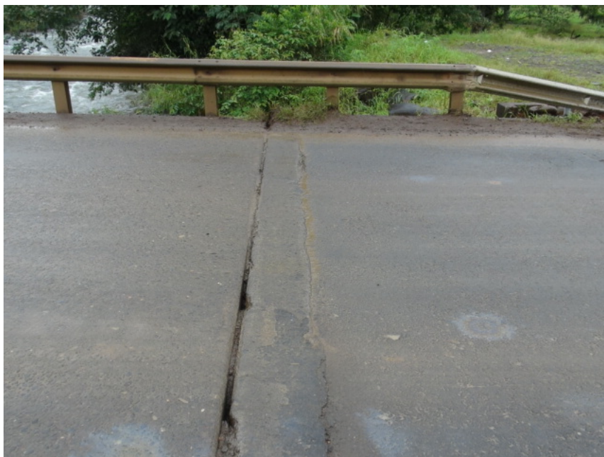
Figura 35: Se observó juntas de expansión sin sello, asentamiento de los accesos de aproximación y desprendimiento del concreto de la pared del cabezal. Puente sobre el Rio Tres Amigos.
