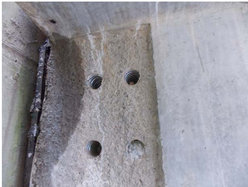
Figura 30: Anclaje inapropiado del acero de refuerzo de la viga diafragma ubicada sobre el bastión-este. El detalle no coincide con lo indicado en planos. Puente sobre el Rio Toro.
