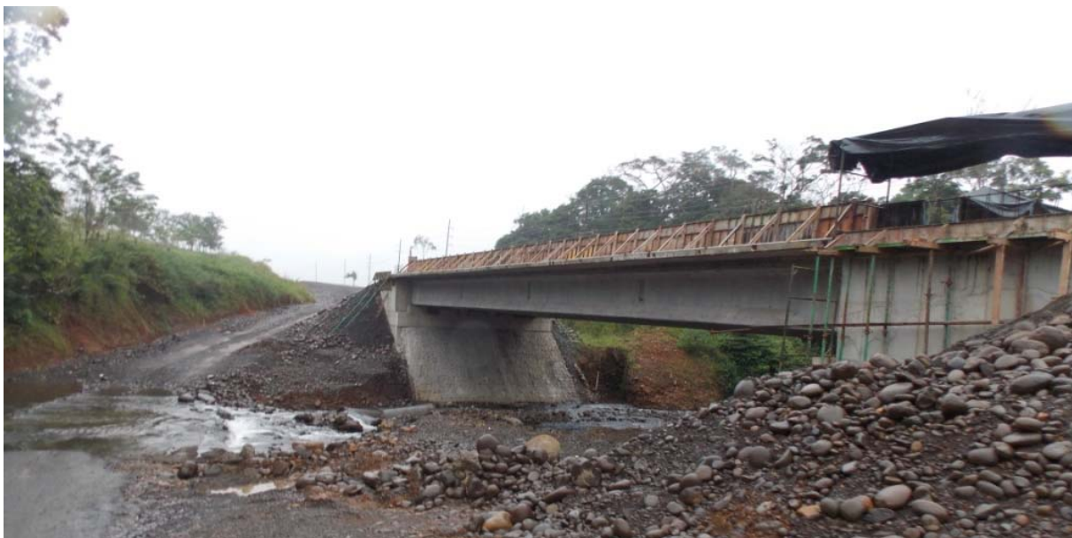
Figura 22: Vista lateral del puente sobre la Quebrada Campamento
