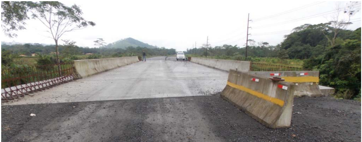
Figura 18: Vista a lo largo de la línea de centro del puente sobre la Quebrada Rio Pericos
