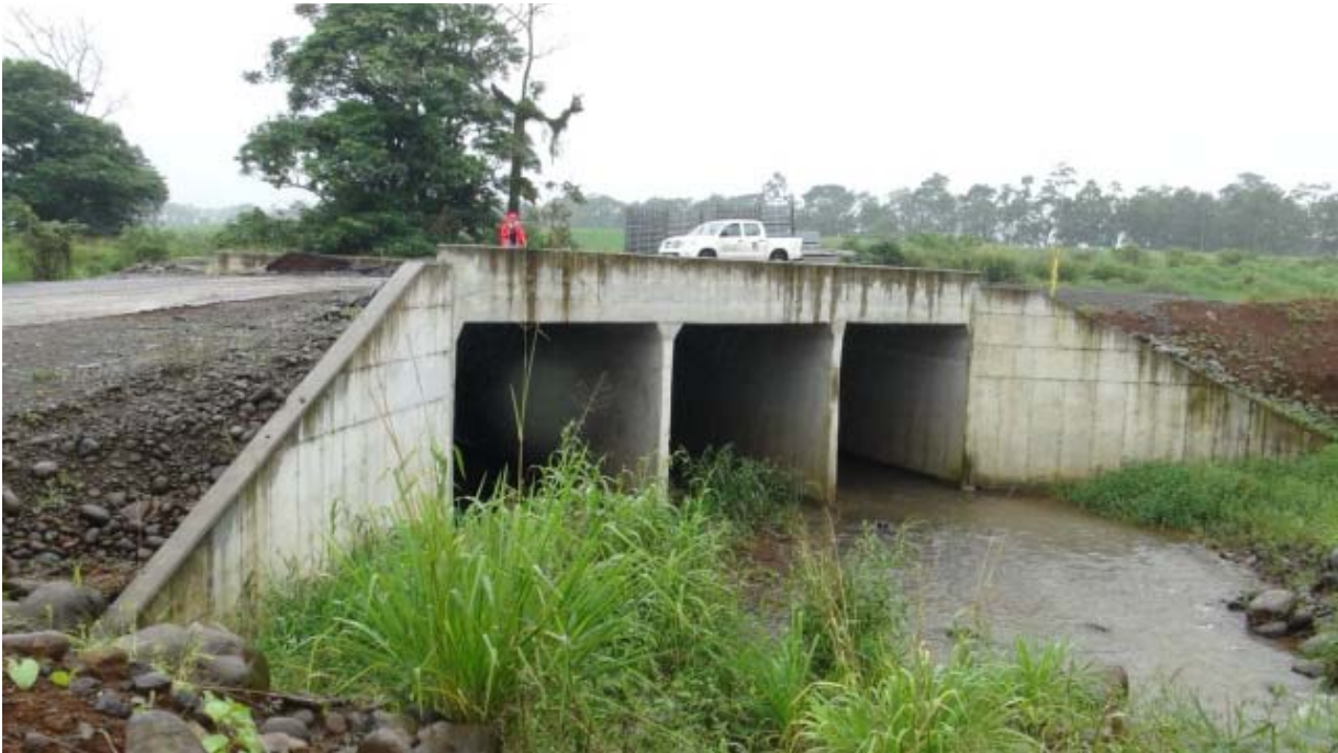
Figura 34: Faltaba construir el revestimiento de protección de los taludes a la entrada y a la salida de la alcantarilla. Alcantarilla sobre la Quebrada San Pedro.
