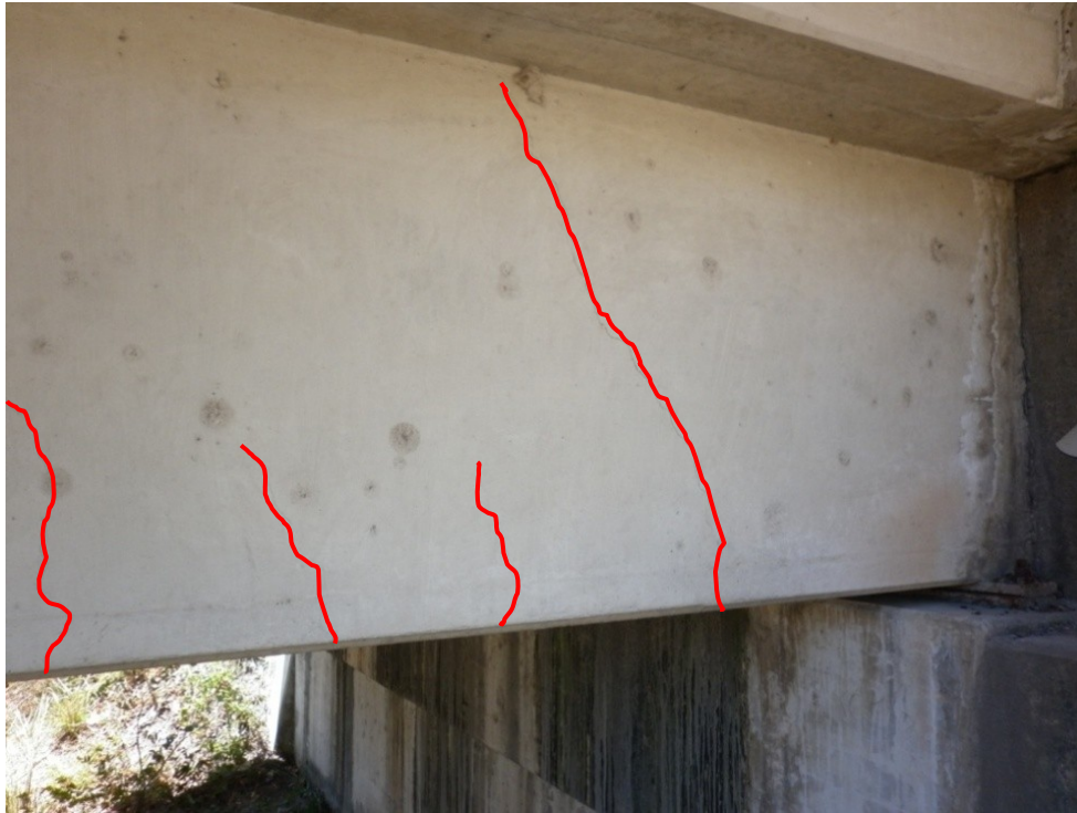
Figura 13: Grietas por cortante en las vigas principales (típico).
