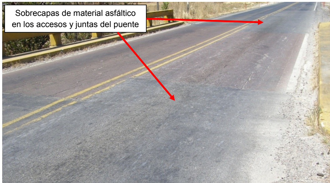
Figura 11: Sobrecapas de material asfáltico en los accesos y juntas del puente.
