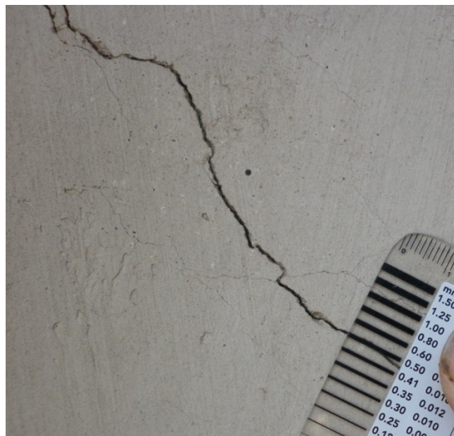
Figura 14: Ancho de grieta superior de 0,5 mm en una grieta por cortante.
