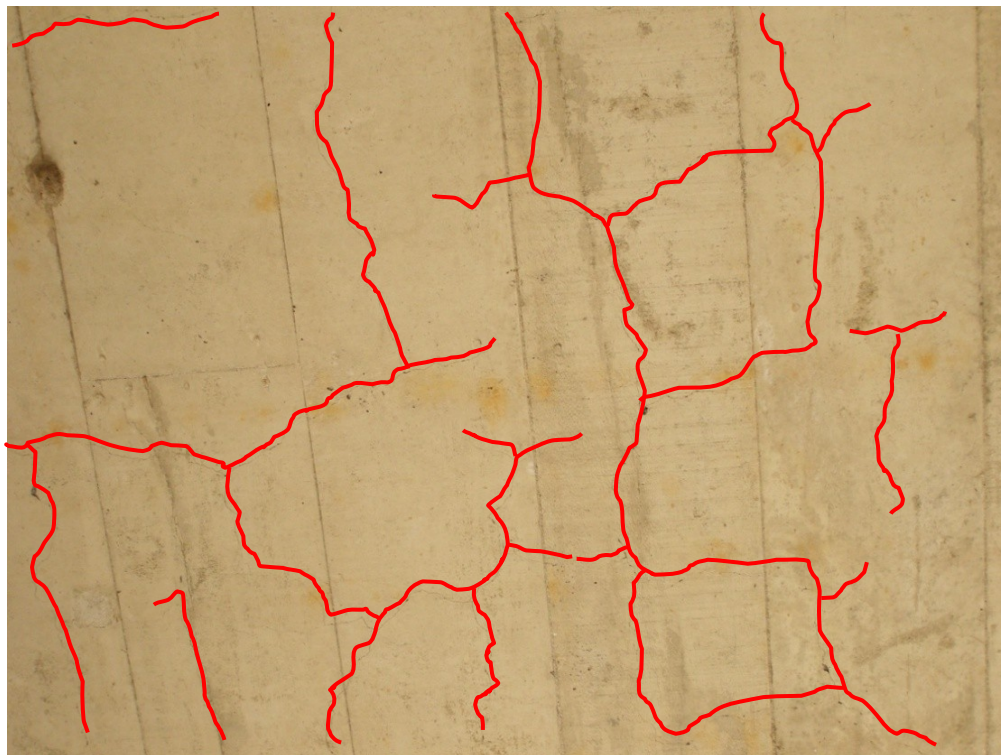
Figura 12: Agrietamiento en dos direcciones en la superficie inferior de la losa (típico)
