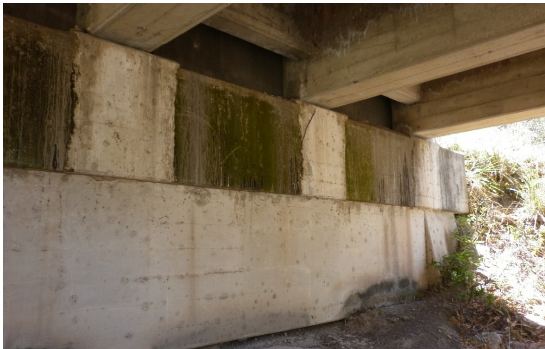
Figura 18: Acumulación de humedad y moho en la viga cabezal del bastión 1.
