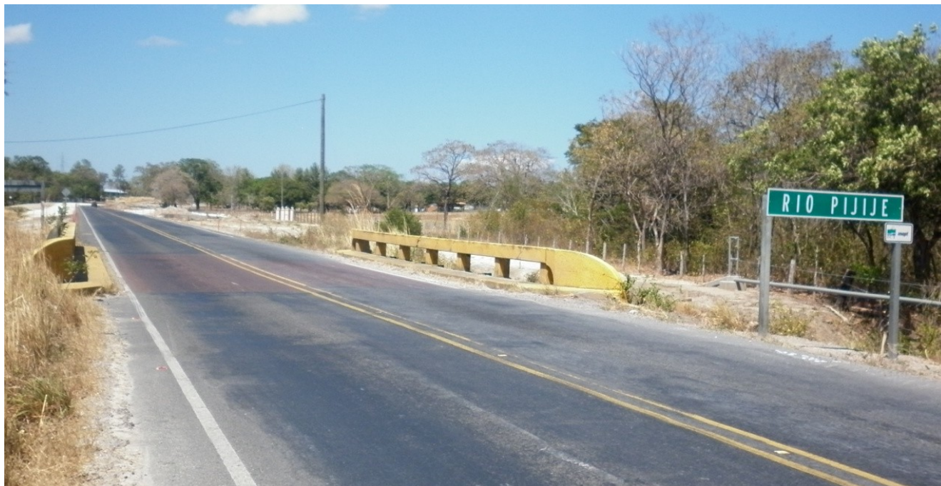
Figura 2: Vista a lo largo de la línea de centro del puente Río Pijje.
