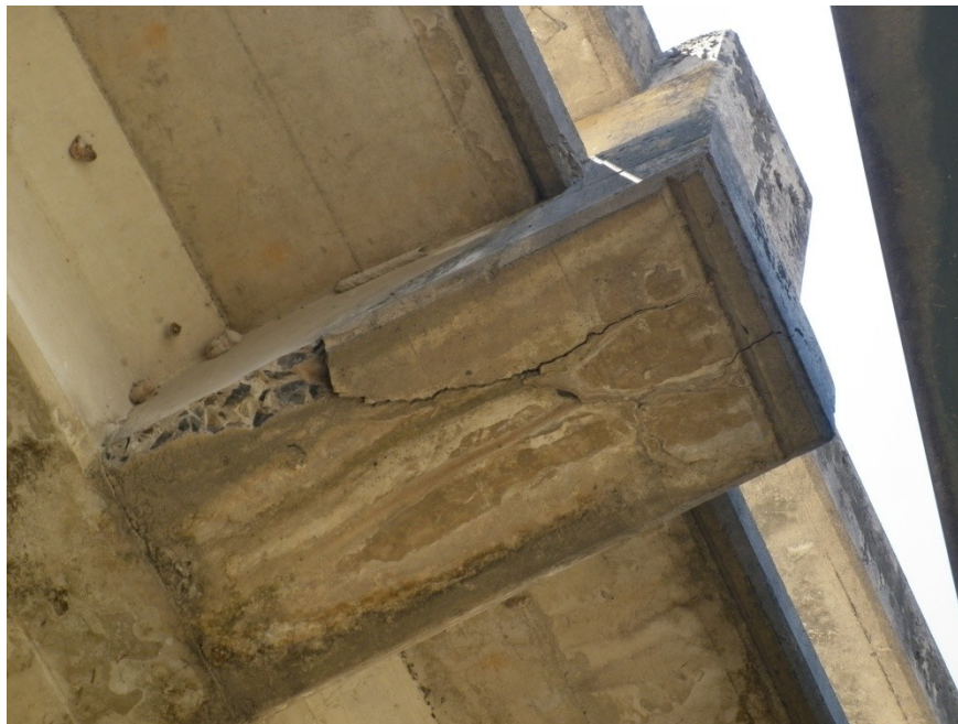
Figura 6: Desprendimientos de concreto en el elemento de refuerzo en voladizo de la barrera vehicular.
