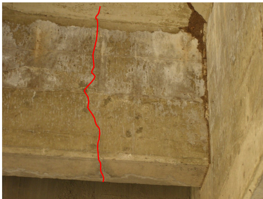
Figura 16: Grieta vertical típica en vigas diafragma.
