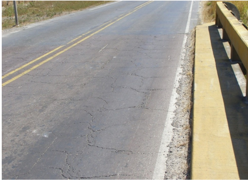
Figura 9: Grietas en dos direcciones sobre la carpeta asfáltica.
