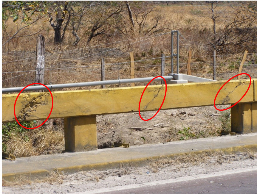
Figura 5: Grietas en la barrera vehicular producidas por el impacto de vehículos.
