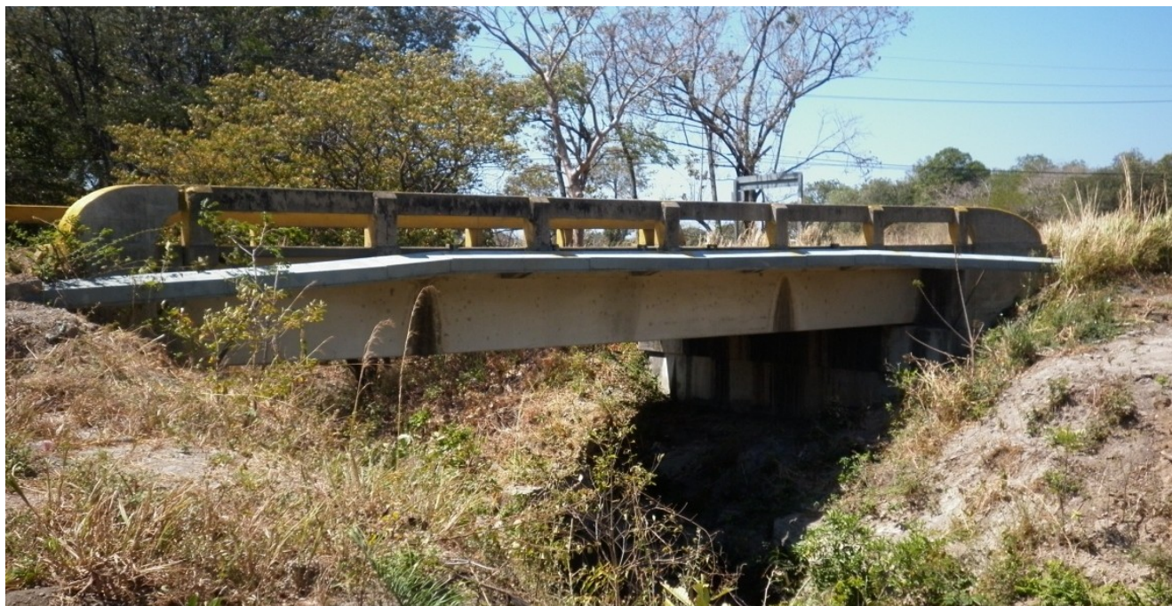
Figura 3: Vista lateral del puente Río Pijje.
