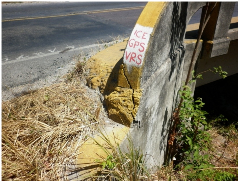
Figura 7: Grieta en el remate de la baranda
