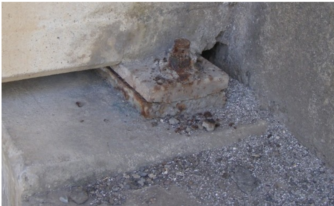
Figura 17: Corrosión y acumulación de sedimentos sobre el apoyo del bastión 2.
