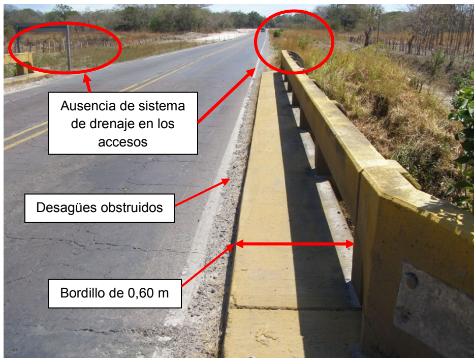
Figura 10: Ausencia de un sistema drenaje en los accesos (acceso este), obstrucción de bordillos y desagües del puente
