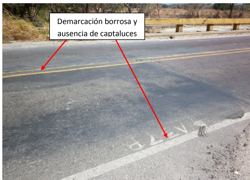
Figura 8: Demarcación horizontal borrosa y ausencia de captaluces en buen estado (acceso oeste).
