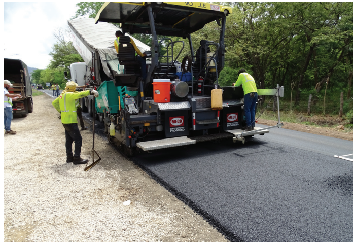
Figura 8. Colocación de la sobrecapa asfáltica, Ruta Nacional N°155
