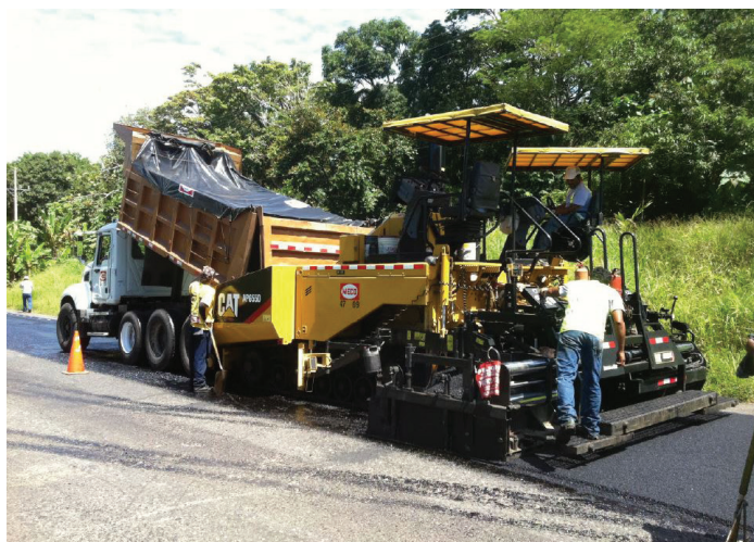
Figura 3. Preenivelación de la superficie con mezcla asfáltica, Ruta Nacional N°34
