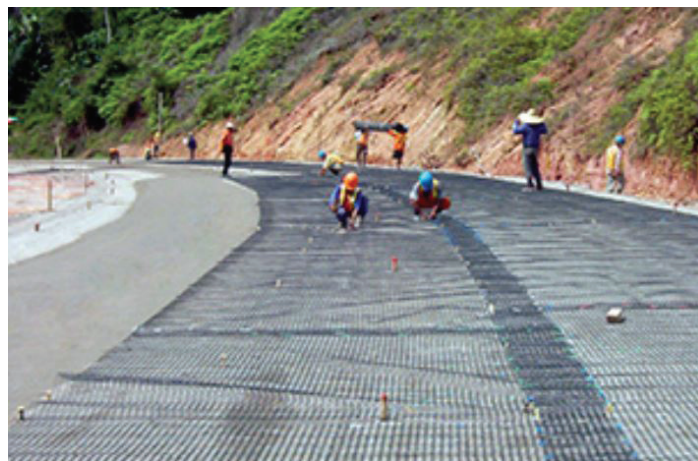
Figura 7. Fraccionamiento de geomallas coladas en curvas
