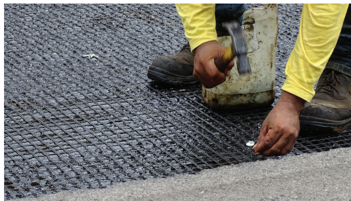
Figura 4. Anclaje de la geomalla
