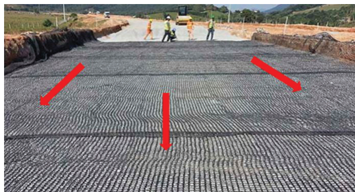
Figura 5. Traslapes transversales en dirección de la pavimentación
