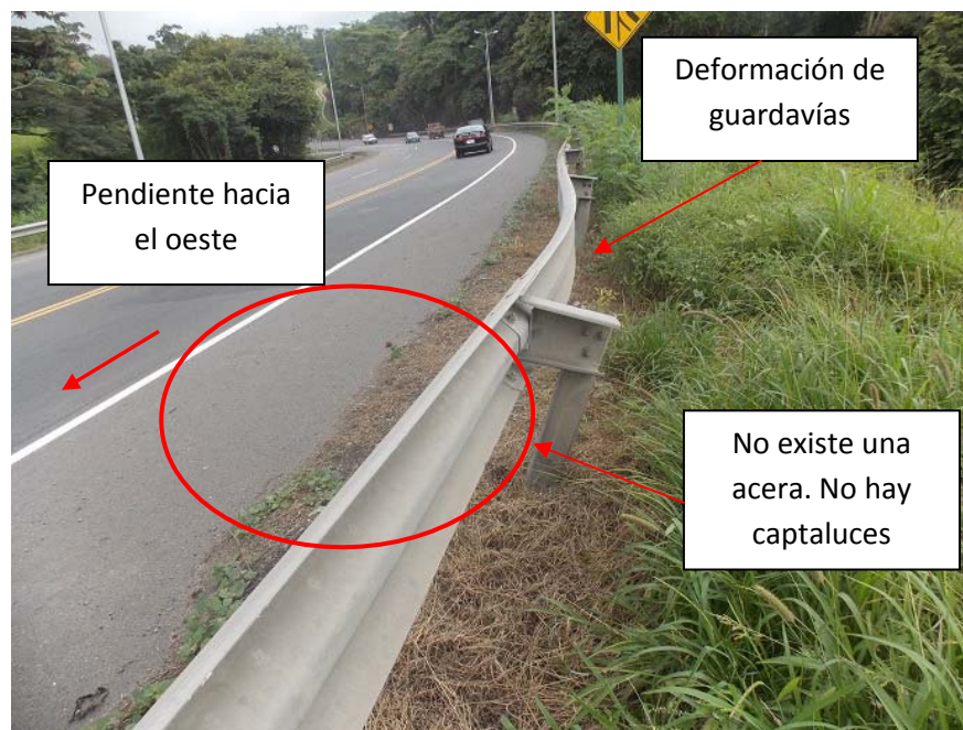
Figura 2: Daño en guardavías del costado sur. Nótese además la ausencia de aceras y captaluces, además la presencia de vegetación.
