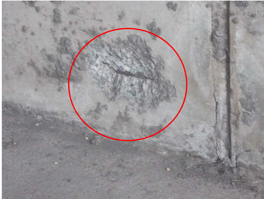
Figura 9: Desprendimiento del recubrimiento y oxidación del refuerzo horizontal en la base del muro del bastión 2.
