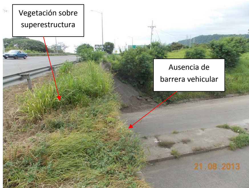
Figura 1: Ausencia de barreras vehiculares. Vista del costado norte. Nótese la presencia de vegetación.
