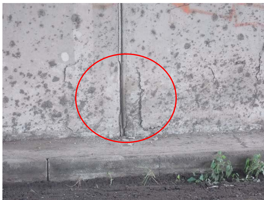
Figura 8: Desprendimiento del recubrimiento en la base del muro del bastión 2.
