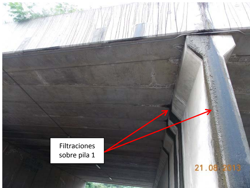
Figura 10: Filtración de agua proveniente de la superestructura sobre la pila 1.
