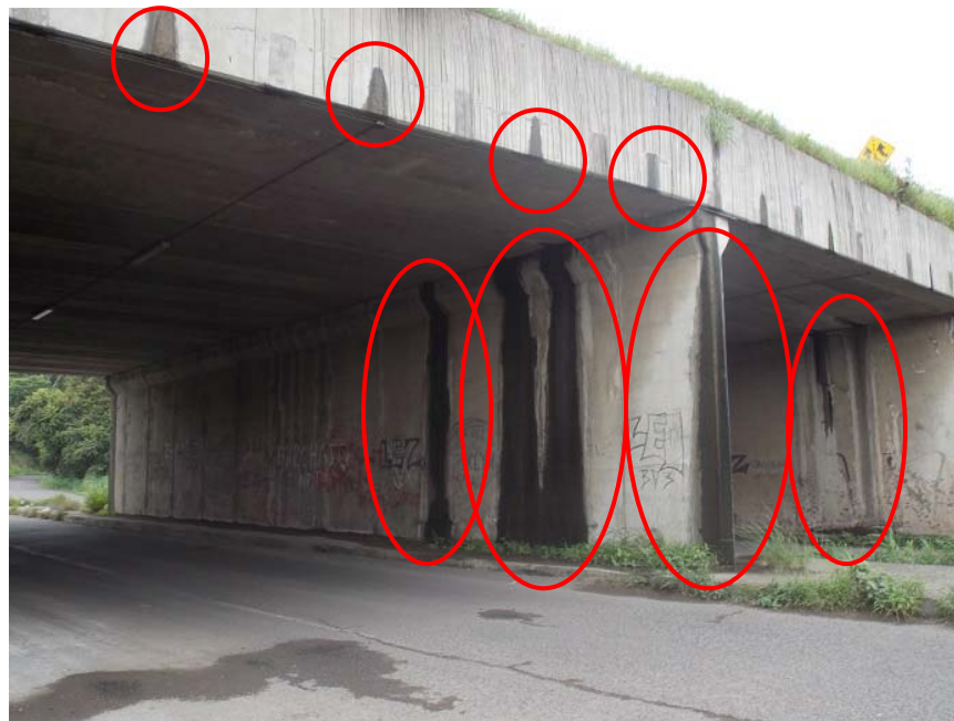
Figura 6: Filtraciones a través de la barrera vehicular, pila 1 y bastión 2. Vista desde el costado sur
