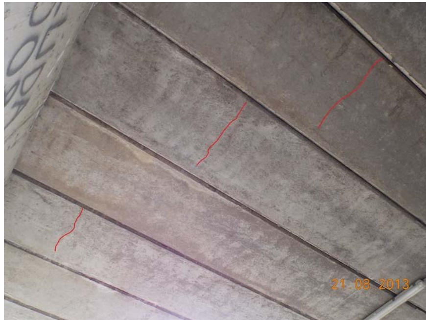
Figura 5: Grietas en las losetas prefabricadas en la cercanía del apoyo del bastión 1.
