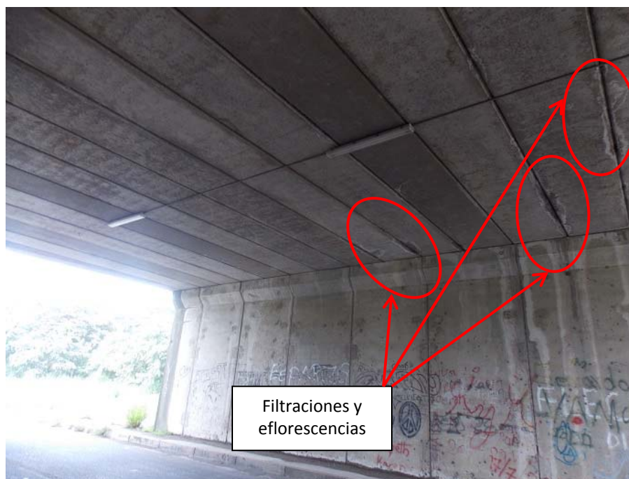
Figura 4: Filtraciones y eflorescencias en el tramo 1.
