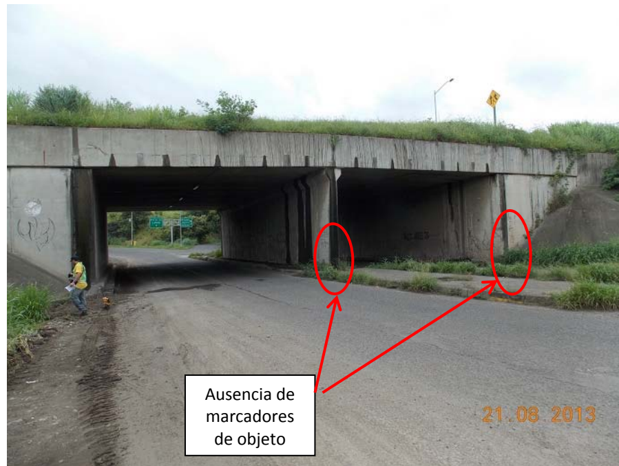
Figura 3: Ausencia de marcadores de objeto en pilas y bastiones en ambos accesos.
