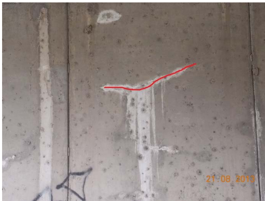
Figura 7: Grieta en paneles prefabricados del bastión 2. Nótese la eflorescencia por filtración de agua
