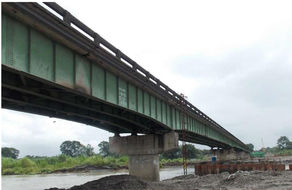
**Figura 11.** Vista lateral de la superestructura de vigas de acero continuas del puente sobre el río Chirripó.
