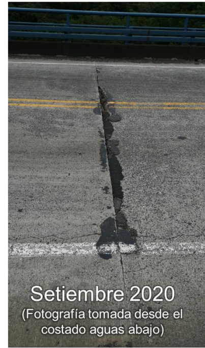
Figura 2.3. Histórico de la condición de la junta de construcción n.º 11 debido a los desprendimientos de concreto.
