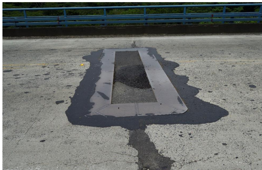
Figura 1.2. Medida de atención inadecuada que se aplicó debido a los desprendimientos de concreto en la junta de construcción n.º 8.
