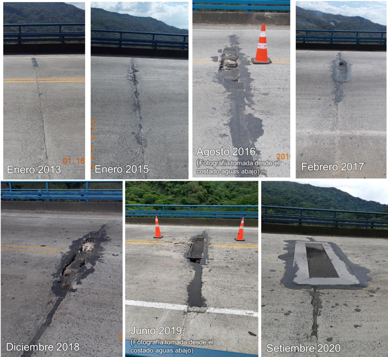
Figura 2.1. Histórico de la condición de la junta de construcción n.º 8 debido a los desprendimientos de concreto.
