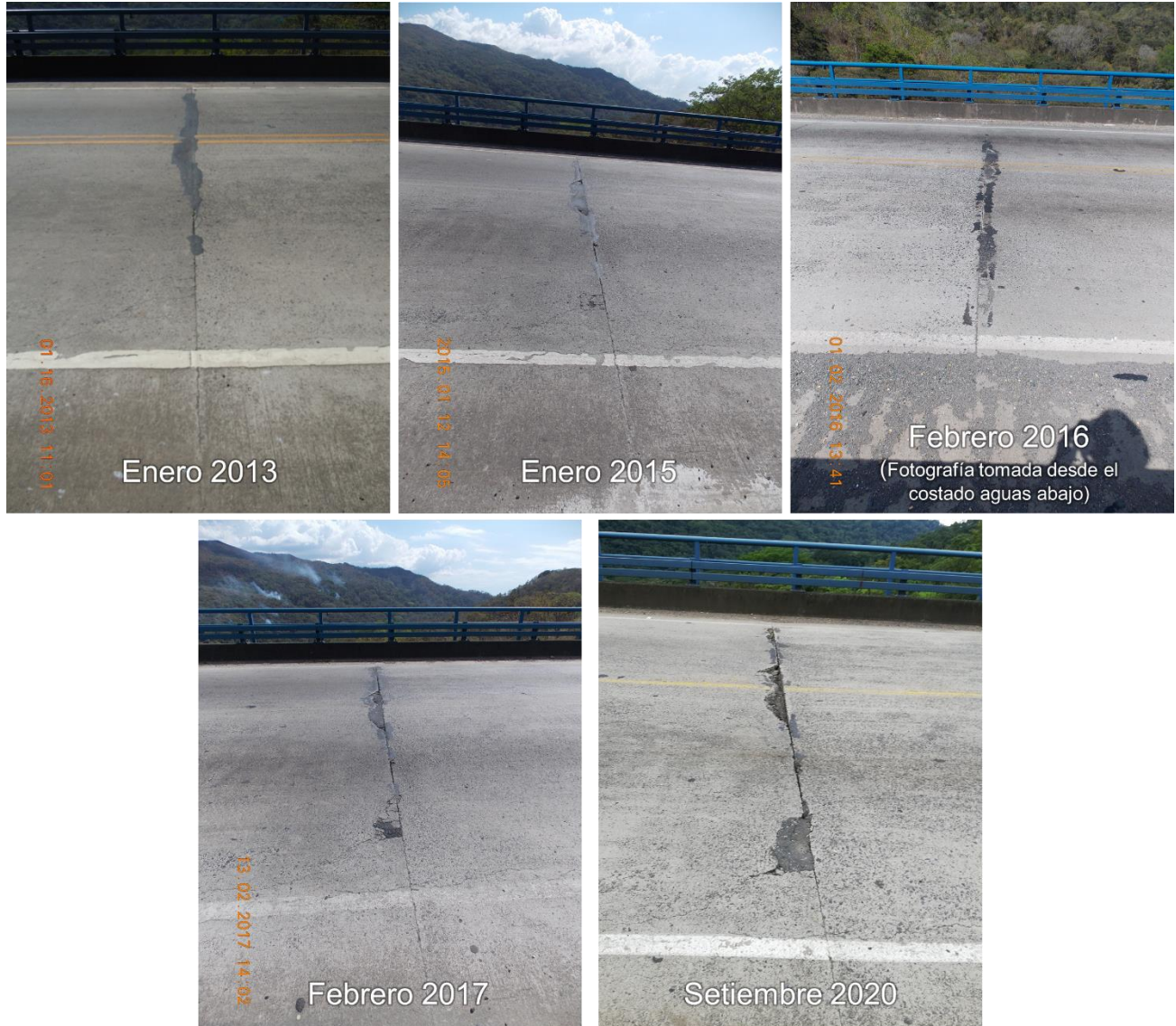
Figura 2.7. Histórico de la condición de la junta de construcción n.º 30 debido a los desprendimientos de concreto. (Las fotografías fueron tomadas desde el costado aguas arriba del puente, excepto, donde se indique lo contrario)
