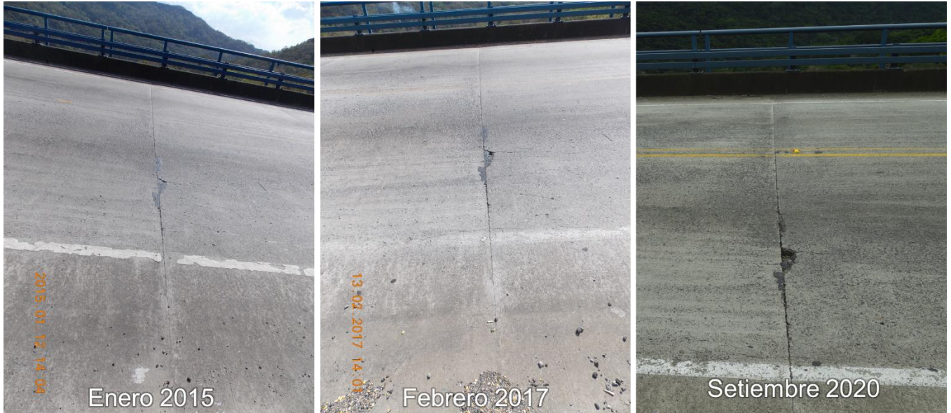
Figura 2.5. Histórico de la condición de la junta de construcción n.º 18 debido a los desprendimientos de concreto.
