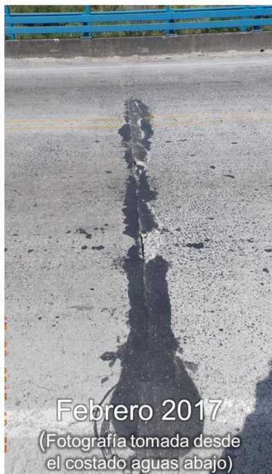
Figura 2.3. Histórico de la condición de la junta de construcción n.º 11 debido a los desprendimientos de concreto.
