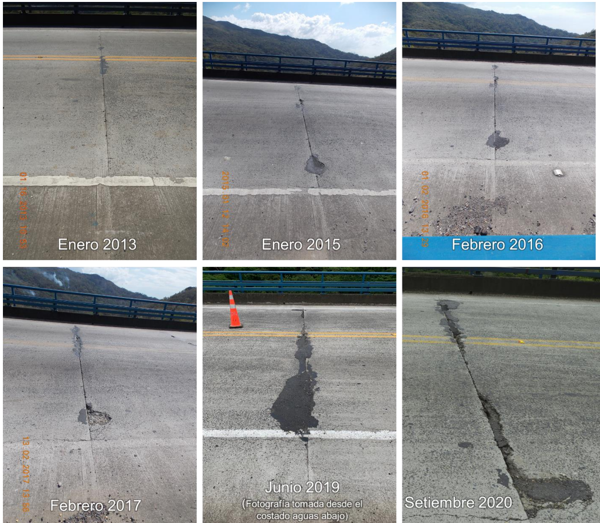
Figura 2.2. Histórico de la condición de la junta de construcción n.º 10 debido a los desprendimientos de concreto.
