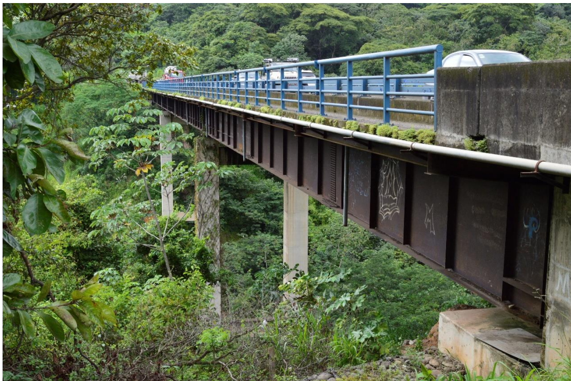
Figura C. Vista lateral del puente (aguas abajo).
