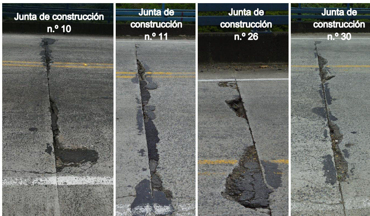
Figura 1.3. Desprendimientos de concreto en juntas de construcción n.º 10, n.º 11, n.º 26 y n.º 30 atendidos con mezcla asfáltica.
