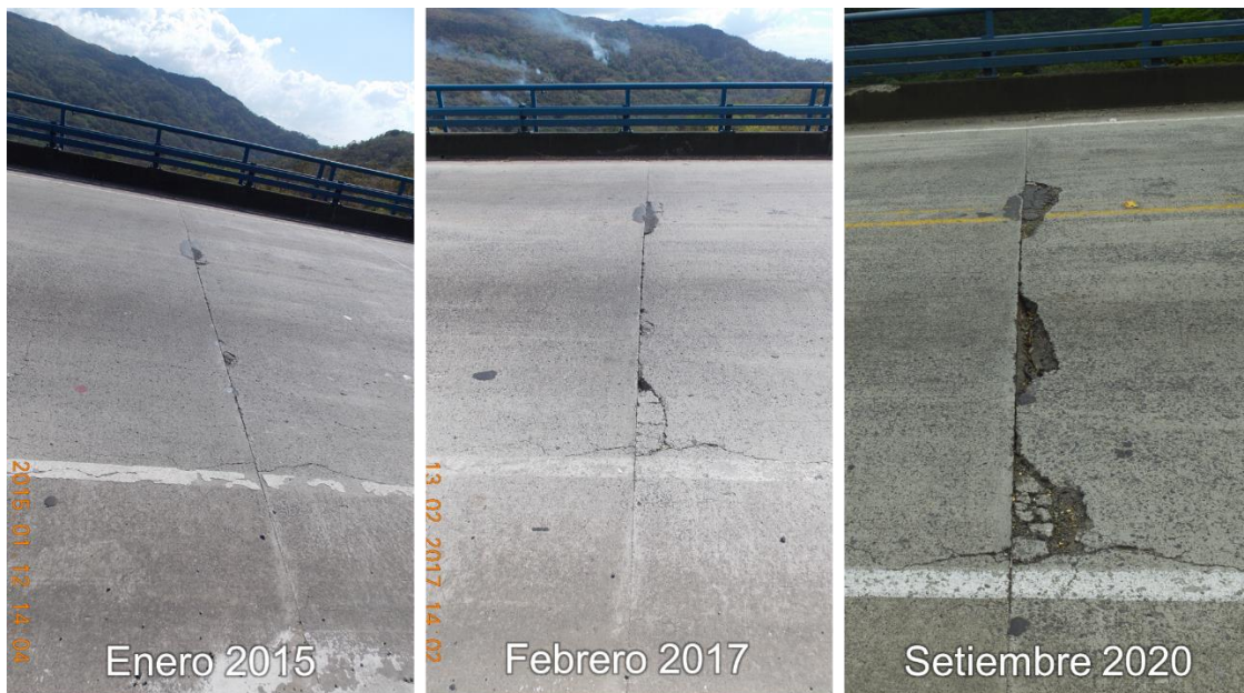
Figura 2.6. Histórico de la condición de la junta de construcción n.º 26 debido a los desprendimientos de concreto.
