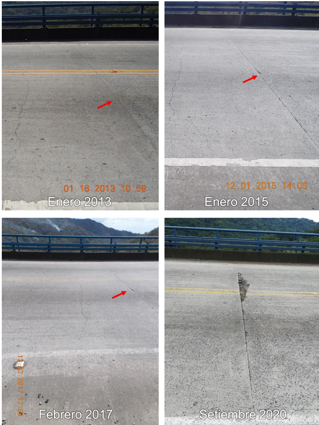
Figura 2.4. Histórico de la condición de la junta de construcción n.º 14 debido a los desprendimientos de concreto.
