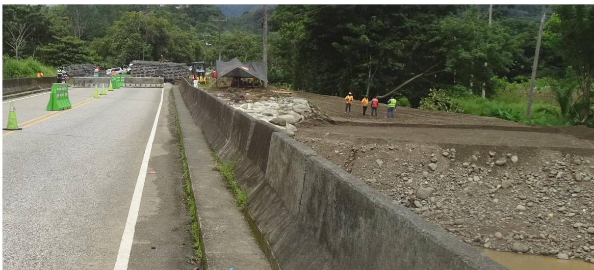
Figura 2.2. Obras de construcción del puente temporal tipo modular observadas durante la inspección.
