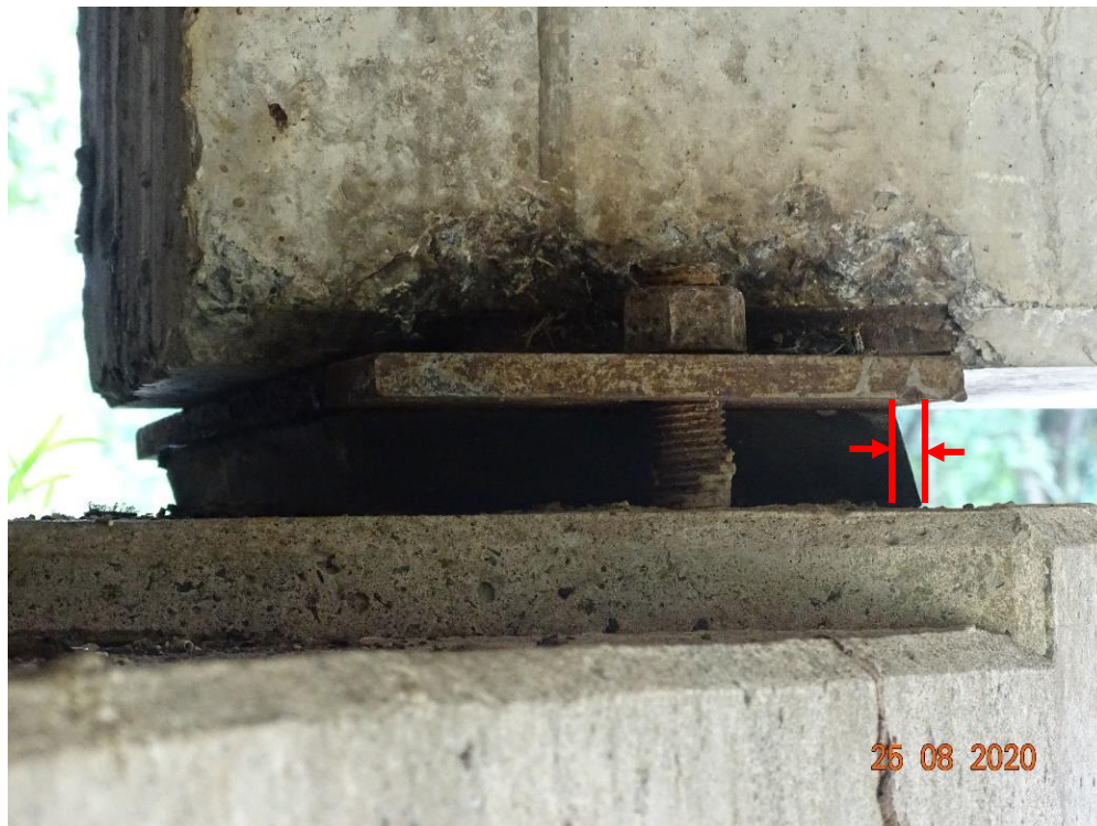
Figura 2.3. Deformación del 25 % de la altura del apoyo del costado aguas abajo de la superestructura n°. 3 sobre el bastión n°. 2
