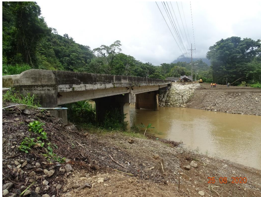
Figura C. Vista lateral del puente (aguas abajo).
