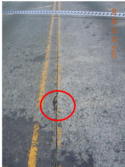
Figura 8. Desprendimiento de concreto adyacente a la junta de construcción longitudinal de la losa de aproximación del acceso desde San José.
