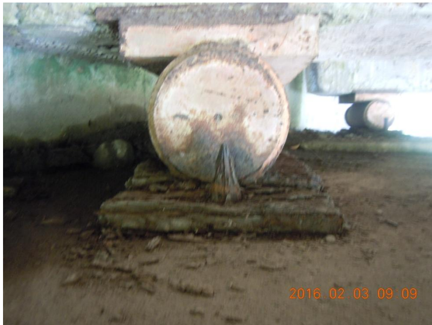
Figura 15. Perno y tuerca con sección reducida por corrosión en apoyo sobre bastión 2.
