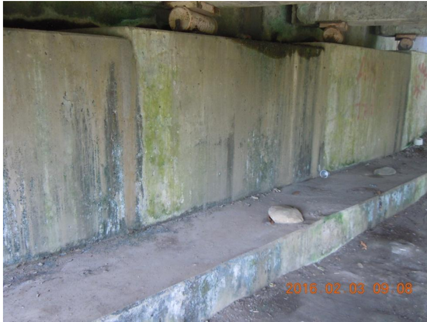
Figura 7. Manchas de humedad en la viga cabezal de los bastiones.
