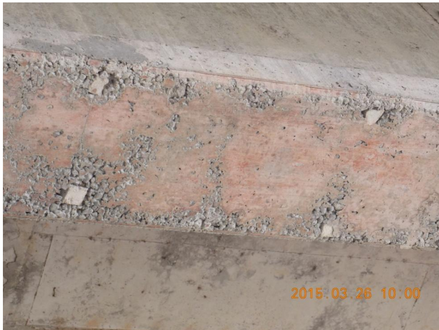
Figura 13. Nidos de piedra en el ala inferior de las vigas presforzadas.
