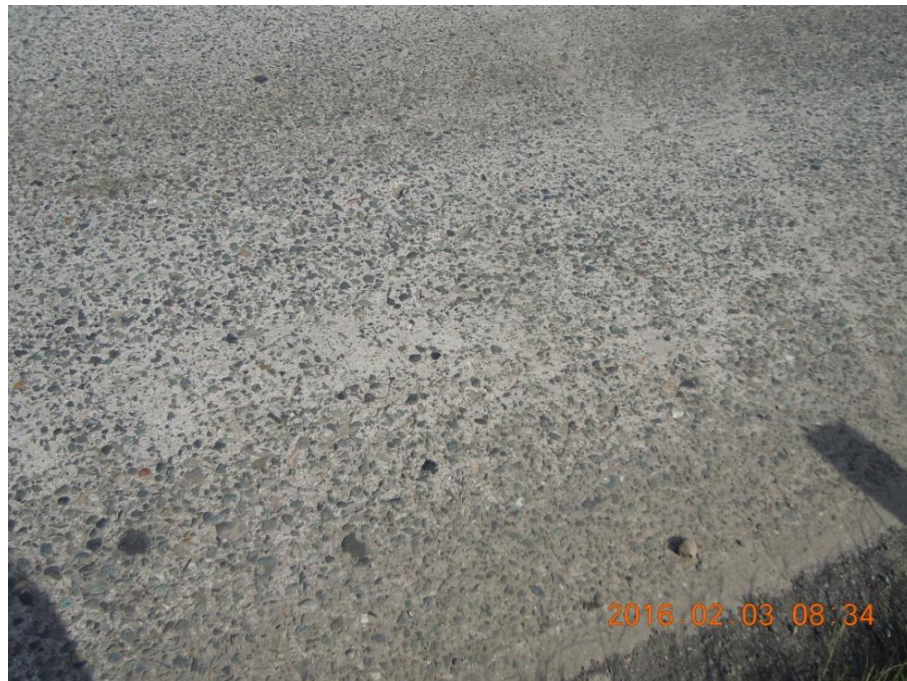
Figura 4. Desgaste de la superficie superior de losa con desprendimiento y pulimiento de agregado.
