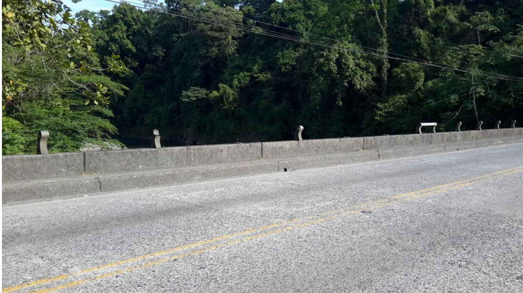
Figura 1. Ausencia de los elementos metálicos superiores de la barrera vehicular.
