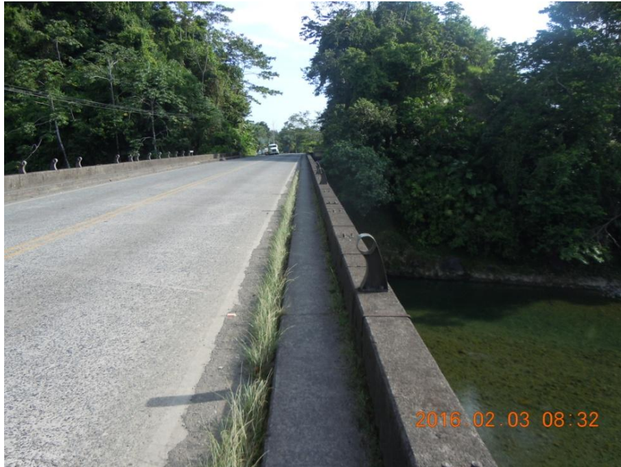
Figura 5. Acumulación de sedimentos y vegetación en el bordillo aguas abajo del puente.
