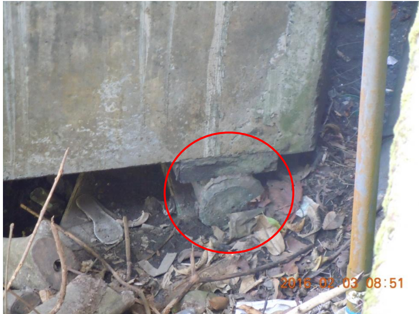
Figura 16. Acumulación de basura y sedimentos alrededor de los apoyos sobre los bastiones que podrían obstruir el movimiento.
