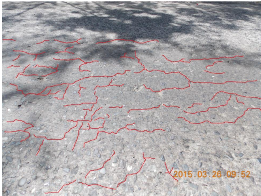
Figura 11. Agrietamiento en la cara superior de la losa de concreto.
