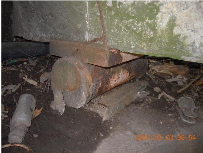
Figura 14. Corrosión de los apoyos sobre los bastiones con pérdida de sección y acumulación de basura y sedimentos a su alrededor.
