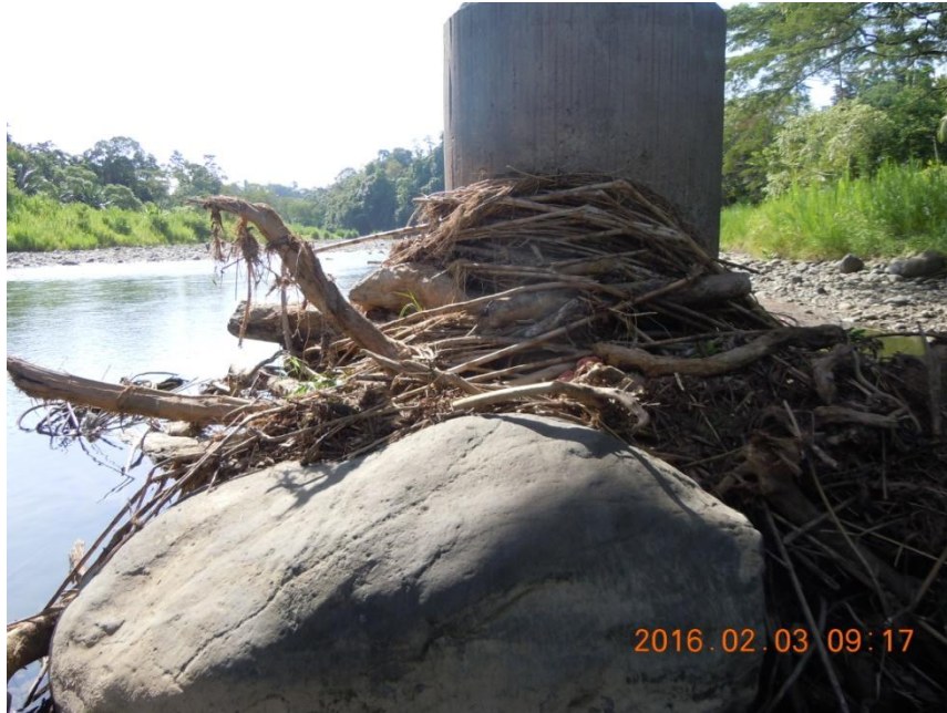
Figura 18. Acumulación de piedras y ramas frente a una de las pilas.
