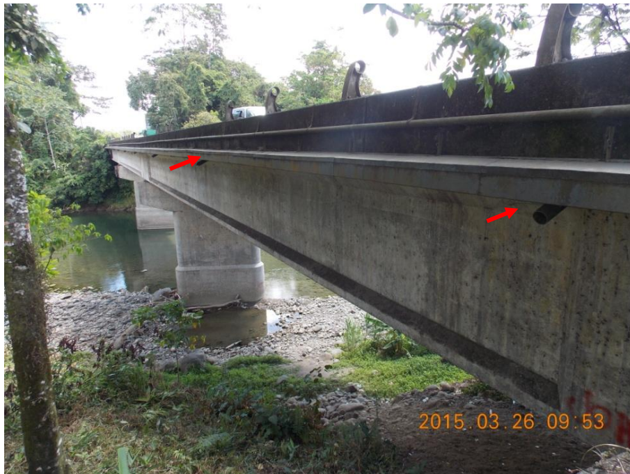
Figura 6. Extensión insuficiente de los ductos de salida del sistema de drenaje de la superestructura.
