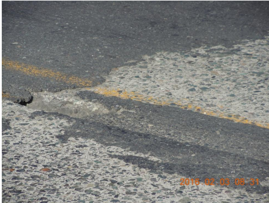
Figura 10. Junta de construcción longitudinal de la losa de aproximación del acceso desde Limón.
