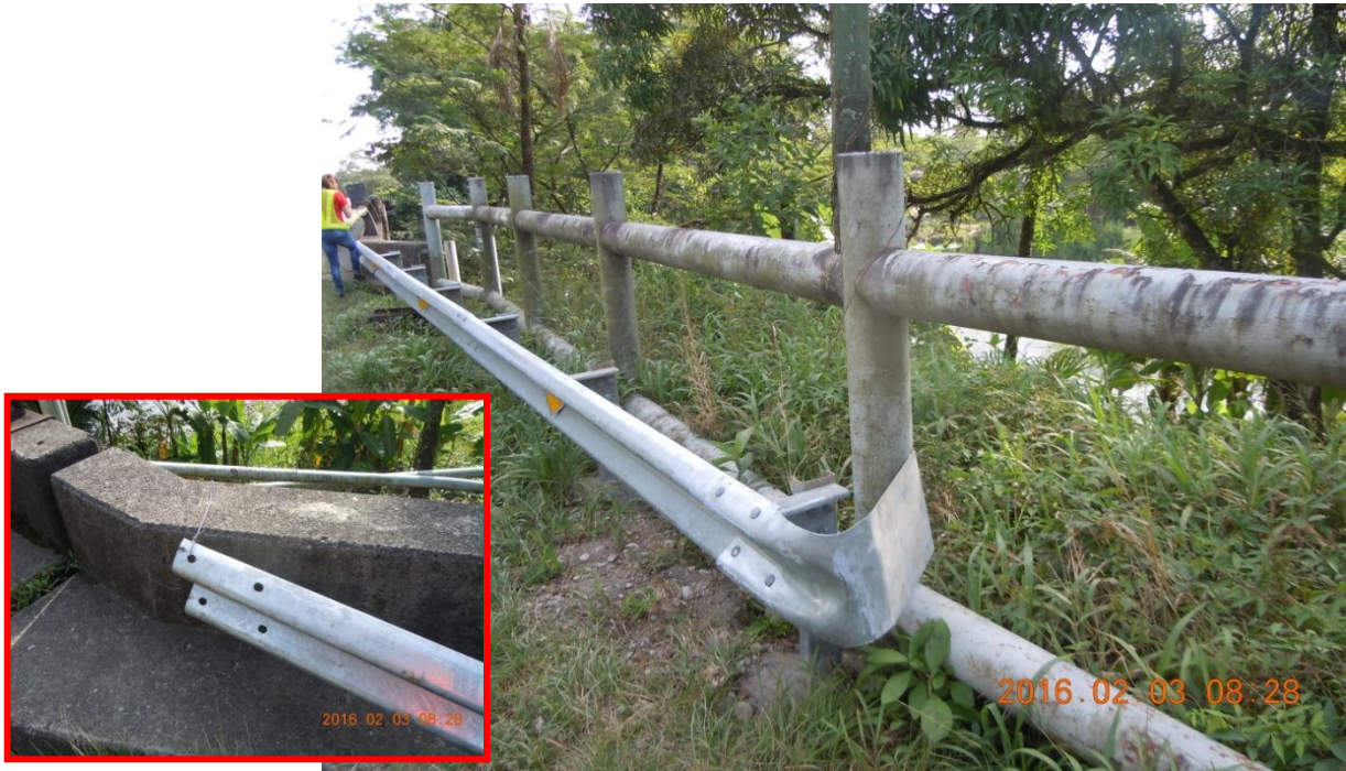
Figura 2. Terminal, longitud, sistema de transición hacia el sistema rígido del puente y anclaje inadecuados del guardavía tanto al sistema rígido como al suelo (postes enterrados en concreto).
