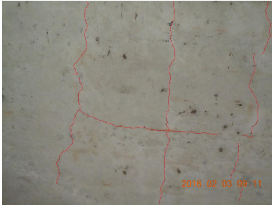
Figura 12. Agrietamiento en la cara inferior de la losa de concreto.
