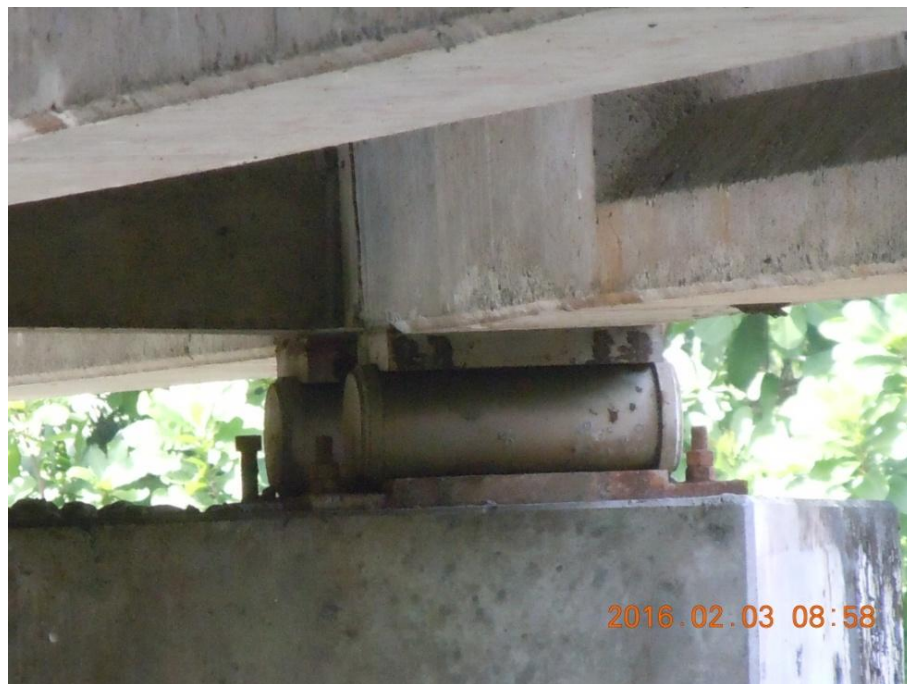
Figura 17. Apoyos sobre pila del puente.
