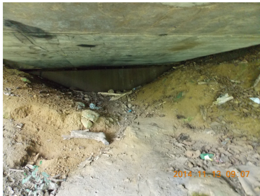
Figura 8: Falla de taludes hacia el bastión, bastión 1.
