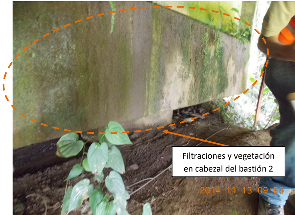
Figura 7: Evidencia de filtraciones desde juntas de expansión en el bastión 2.
