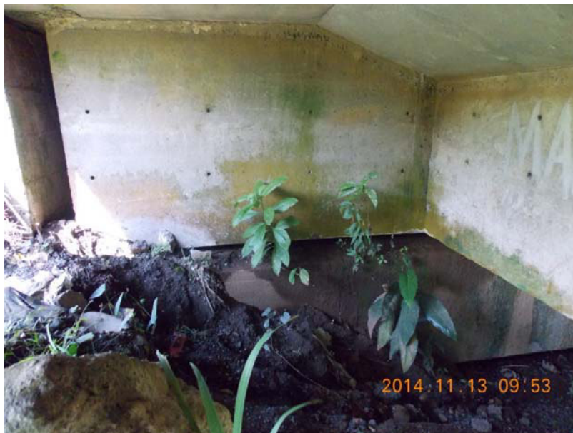
Figura 13: Acumulación de sedimentos en el área vecina a los apoyos y su ubicación dificulta la inspección.
