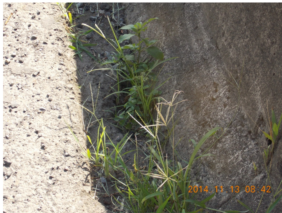
Figura 4: Presencia de vegetación y escombros en el espaldón del puente.
