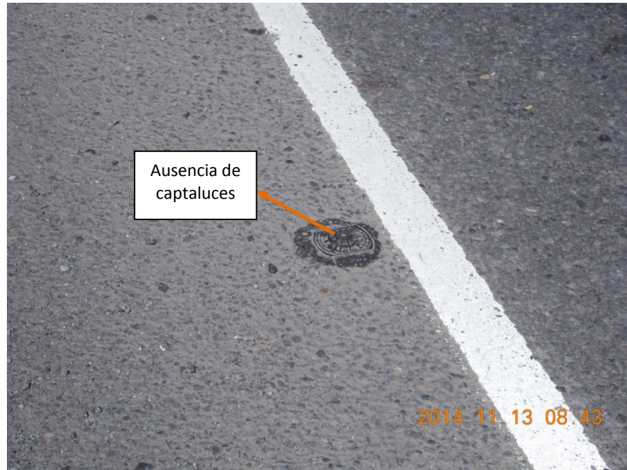
Figura 3: Ausencia de captaluces en la vía.
