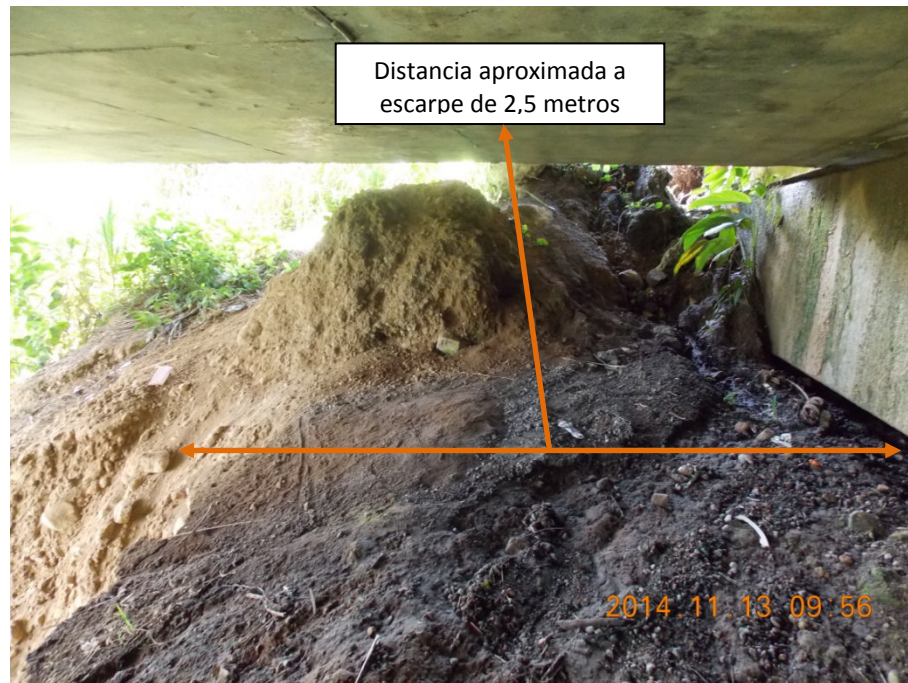
Figura 9: Proximidad del escarpe de deslizamiento al bastión 2.
