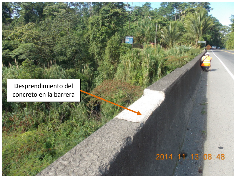
Figura 1: Daño observado en la barrera del puente.
