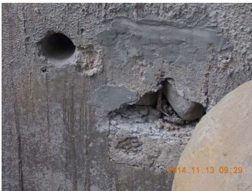
Figura 14: Practicas constructivas inapropiadas a la hora de rellenar agujeros en la pila del puente.
