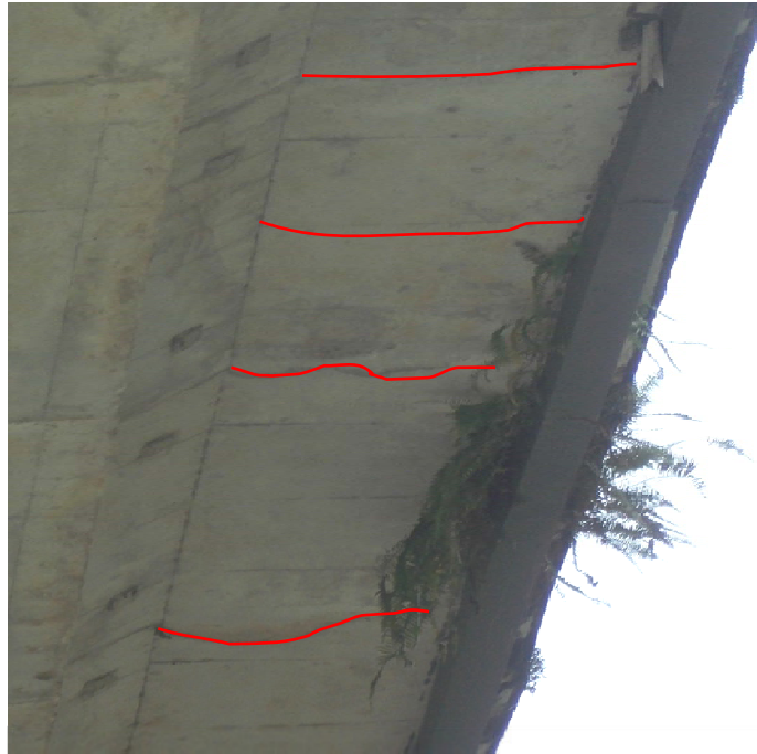
Figura 11: Grieta transversal con presencia de eflorescencia en la losa de concreto.
