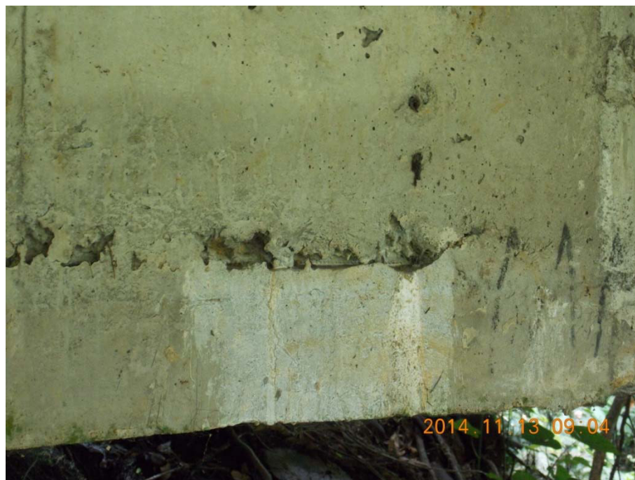
Figura 12: Nido de piedra en cajón con presencia de acero de refuerzo expuesto.
