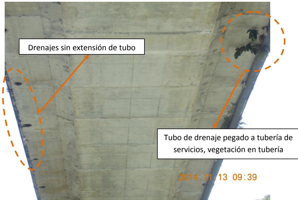
Figura 5: Condición de las salidas de los drenajes en el puente.
