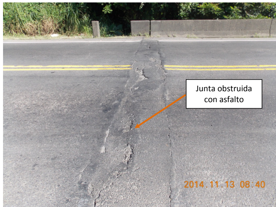
Figura 6: Obstrucción de junta de expansión con asfalto y pequeños baches.
