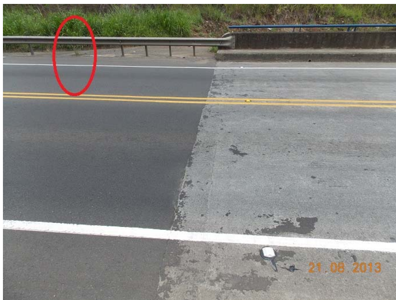
Figura 1: Ausencia de elemento vertical en guardavía del acceso este costado sur
