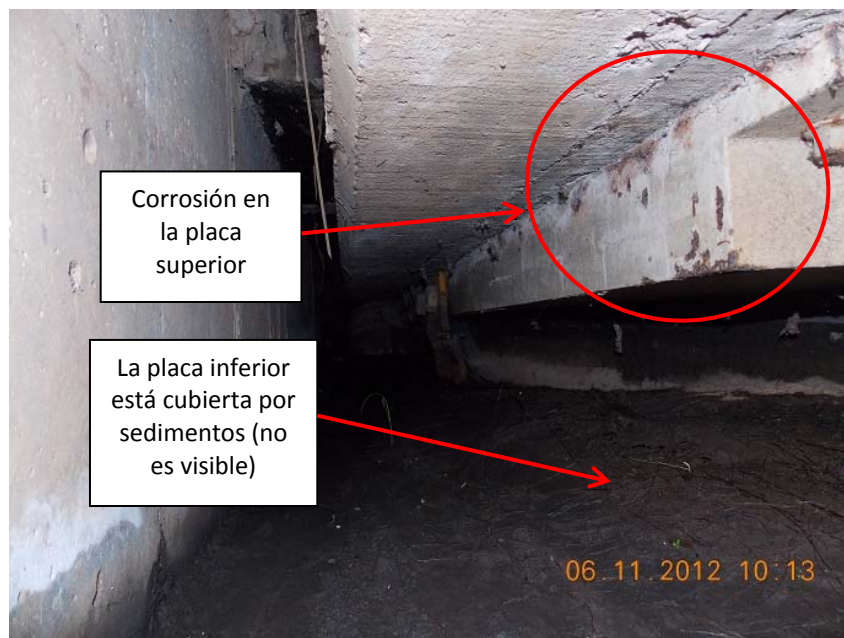
Figura 12: Apoyo norte del bastión 2. Corrosión de la placa superior del apoyo. La placa inferior está cubierta con sedimentos.
