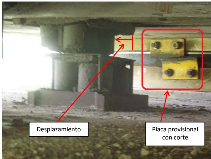
Figura 10: Apoyo sur del bastión 1. Nótese el desplazamiento y la placa de fijación del apoyo de disco.
