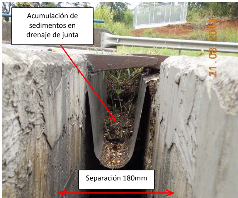
Figura 6: Drenaje obstruido con sedimentos y vegetación en junta del extremo oeste.
