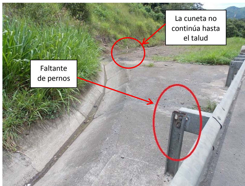
Figura 2: Faltante de pernos que conectan los guardavías al poste del acceso sur-costado oeste. Además la cuneta no continúa hasta el talud.
