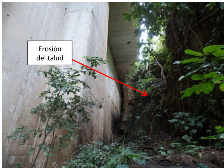
Figura 7: Talud del acceso este costado sur, nótese que no hay protección contra erosión.
