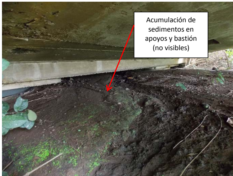
Figura 5: Acumulación de sedimentos sobre el bastión 2 y los apoyos, los cuales no son visible debido a este problema.
