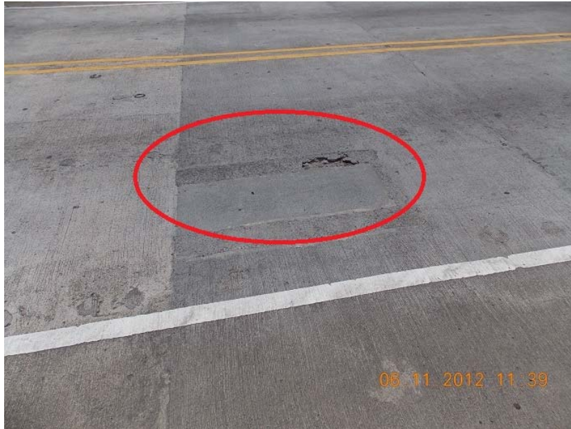
Figura 9: Desprendimiento de concreto de una reparación previa de la losa.
