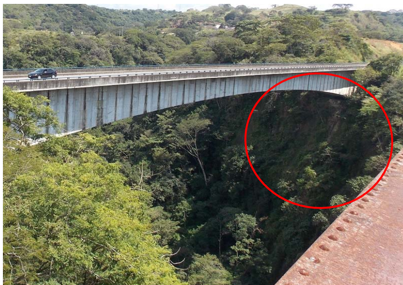
Figura 14: Talud del bastión 2. No cuenta con protección contra la erosión.
