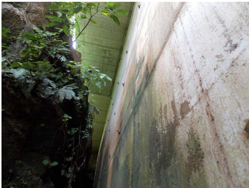
Figura 13: Aletón norte bastión 2. Humedad en la cara externa debido al mal manejo de las aguas de escorrentía.
