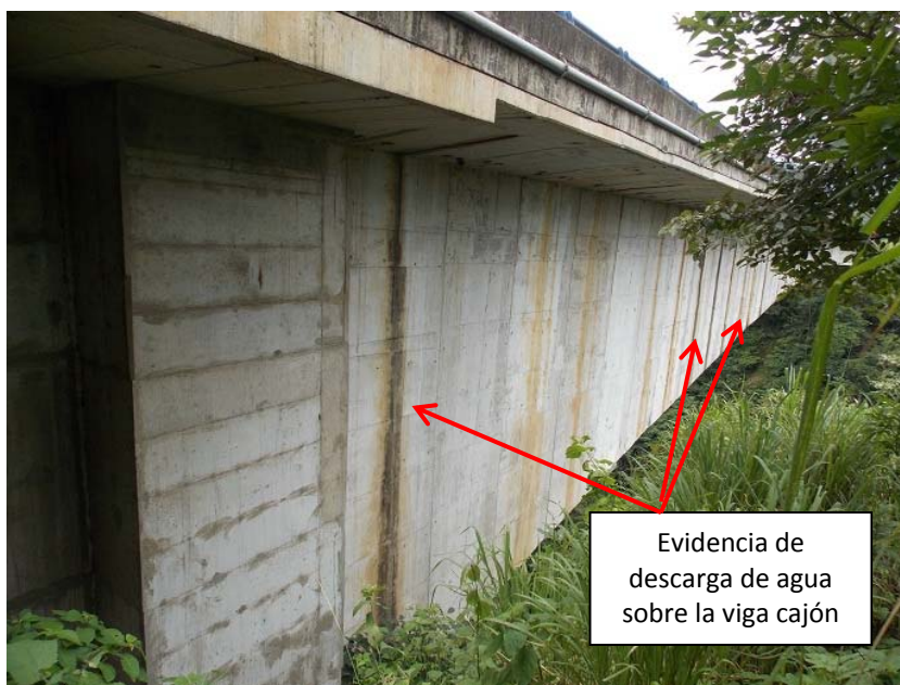
Figura 4: Manchas producto de la descarga de agua sobre la viga cajón desde los ductos drenajes que no cuentan con tubos de extensión.
