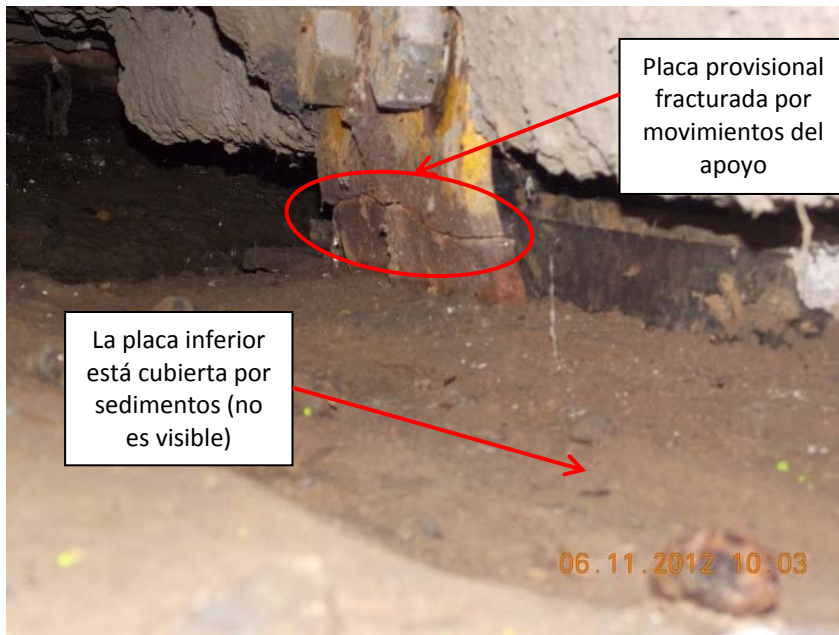
Figura 11: Apoyo sur del bastión 2. Nótese la ruptura de la placa provisional que no fue removida en el proceso constructivo.
