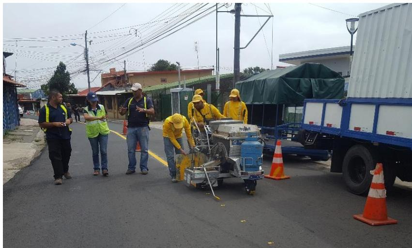
Figura 9. 18. Tramos experimentales con material termoplástico amarillo en Heredia
