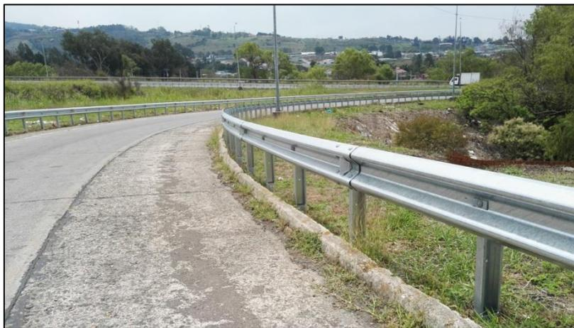
Figura 11. 4. Sistema de contención colocado en la Florencio del Castillo
