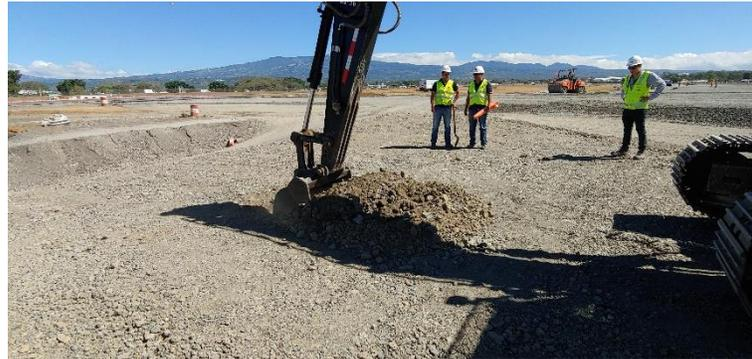
Figura 9. 9. Recolecciones de muestras pista de rodaje Bravo AIJS
