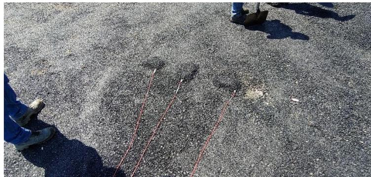
Figura 9. 10. Instalación y protección de galgas extensiométricas en primera capa de MAC
