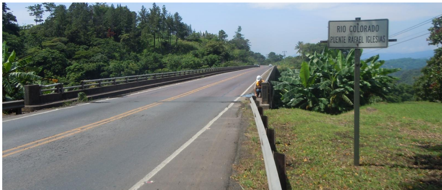
Figura B: Vista a lo largo de la línea de centro del puente.
