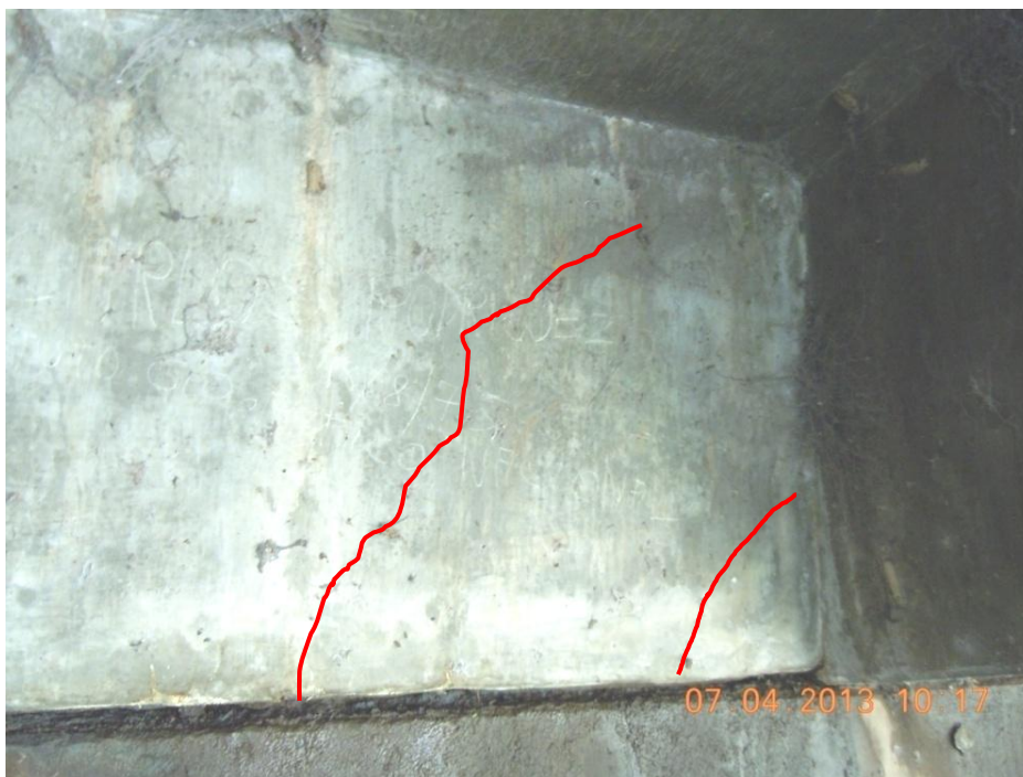
Figura 21: Grietas por cortante (diagonales) en viga diafragma sobre el bastión 1
