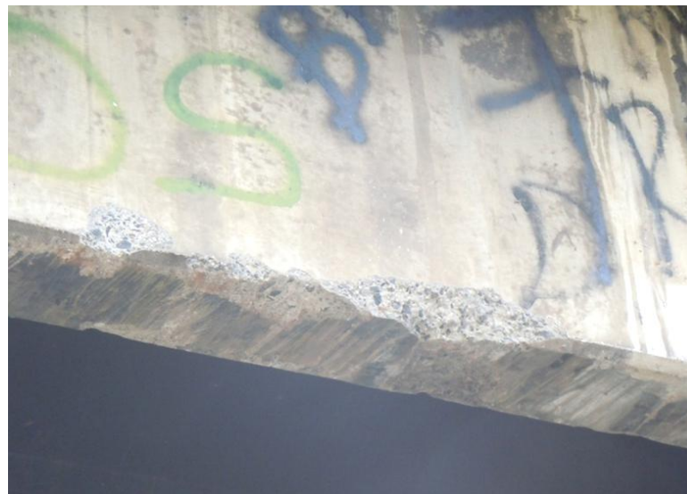
Figura 20: Detalle del desprendimiento de concreto debido a impactos vehiculares
