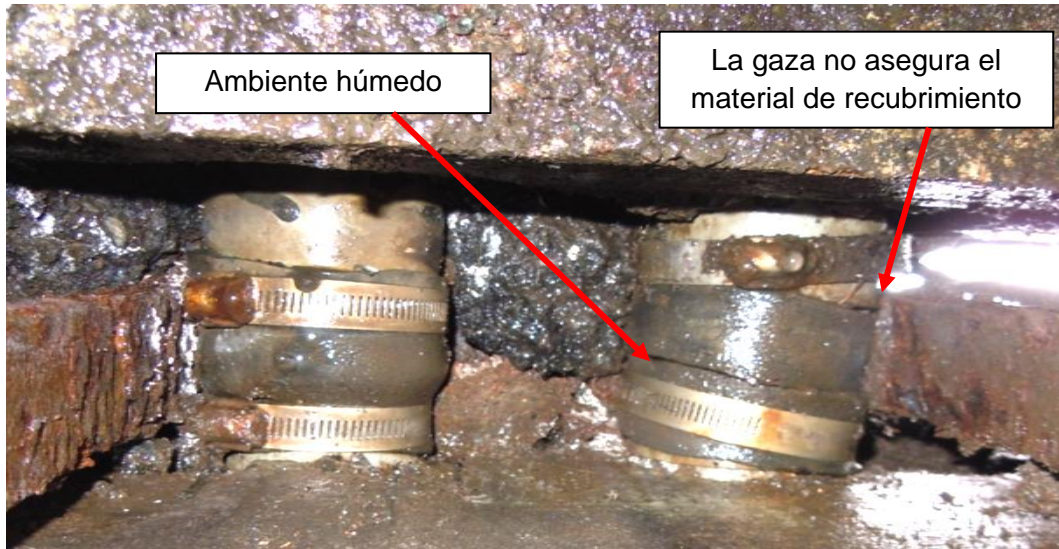
Figura 25: Ductos cubiertos por donde pasan los cables del puente, vista inferior de la junta de expansión sobre el bastión 1
