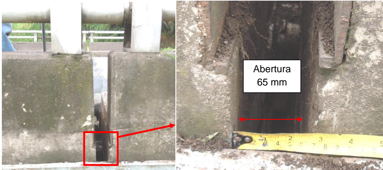
Figura 9: Abertura en la junta de expansión sobre el bastión 2 la cual excede lo indicado en planos.
