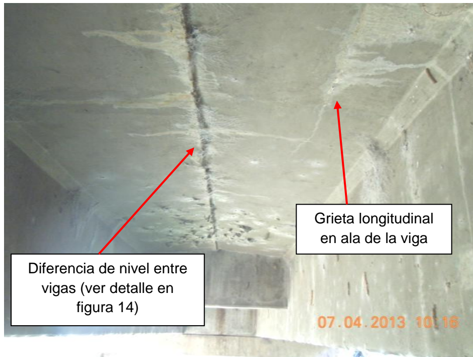
Figura 13: Diferencia de nivel entre vigas T longitudinales y grieta en el ala de una viga.
