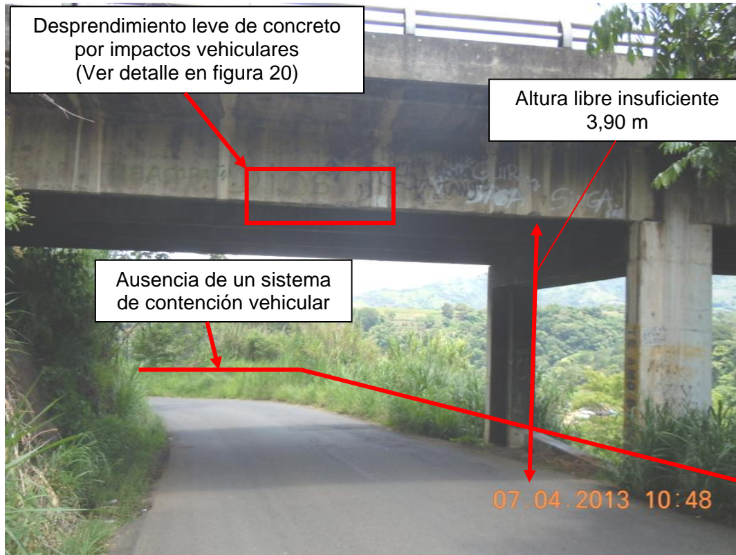
Figura 19: Ausencia de sistema de contención vehicular en ruta 716 que cruza bajo el puente, de rótulo de altura máxima y altura libre insuficiente.
