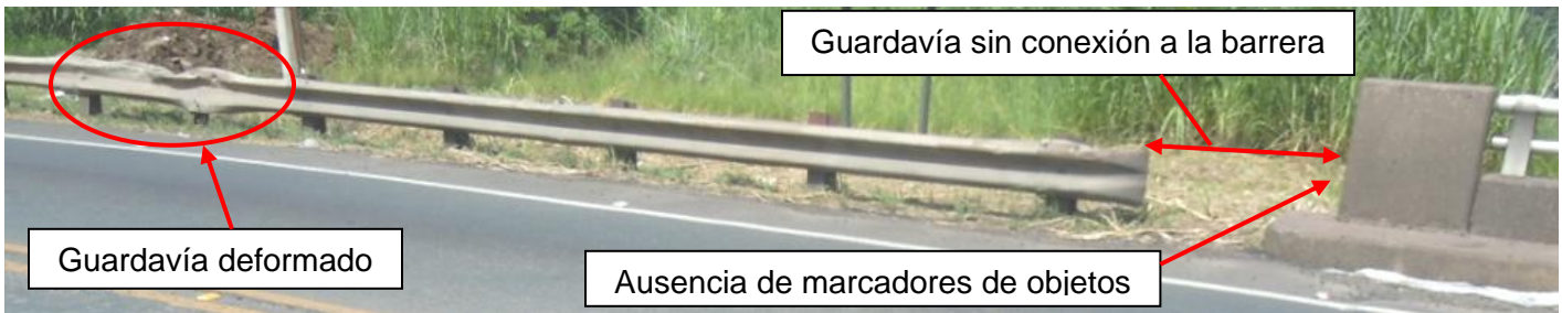
Figura 3: Guardavías Oeste del acceso 1 deformado y sin conexión a la barrera. Ausencia de marcadores de objetos (típico).
