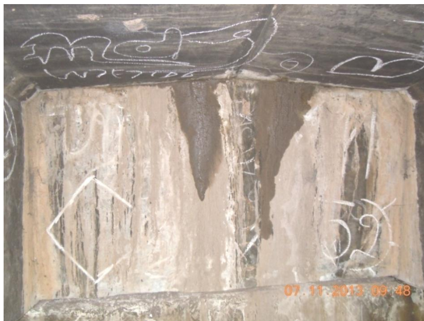
Figura 22: Filtración de agua a través de la losa y eflorescencia en viga diafragma sobre el bastión 2
