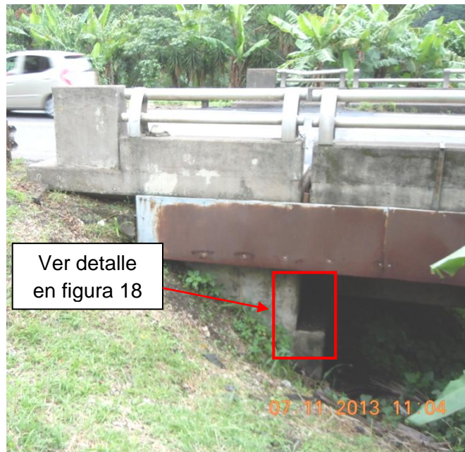
Figura 17: Ubicación de daños en la viga principal externa-este apoyada sobre el bastión 1.
