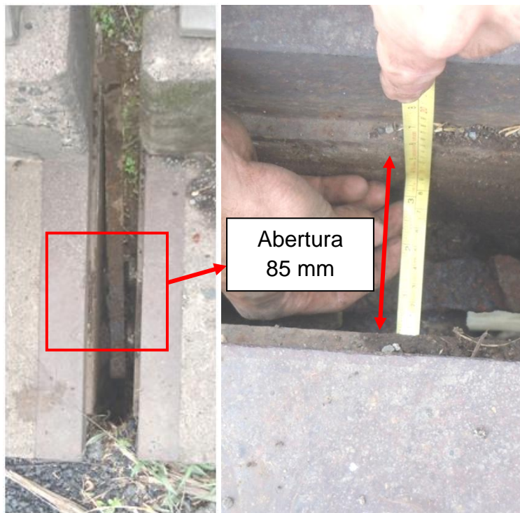
Figura 10: Abertura de la junta de expansión sobre el bastión 1 la cual excede lo indicado en planos.
