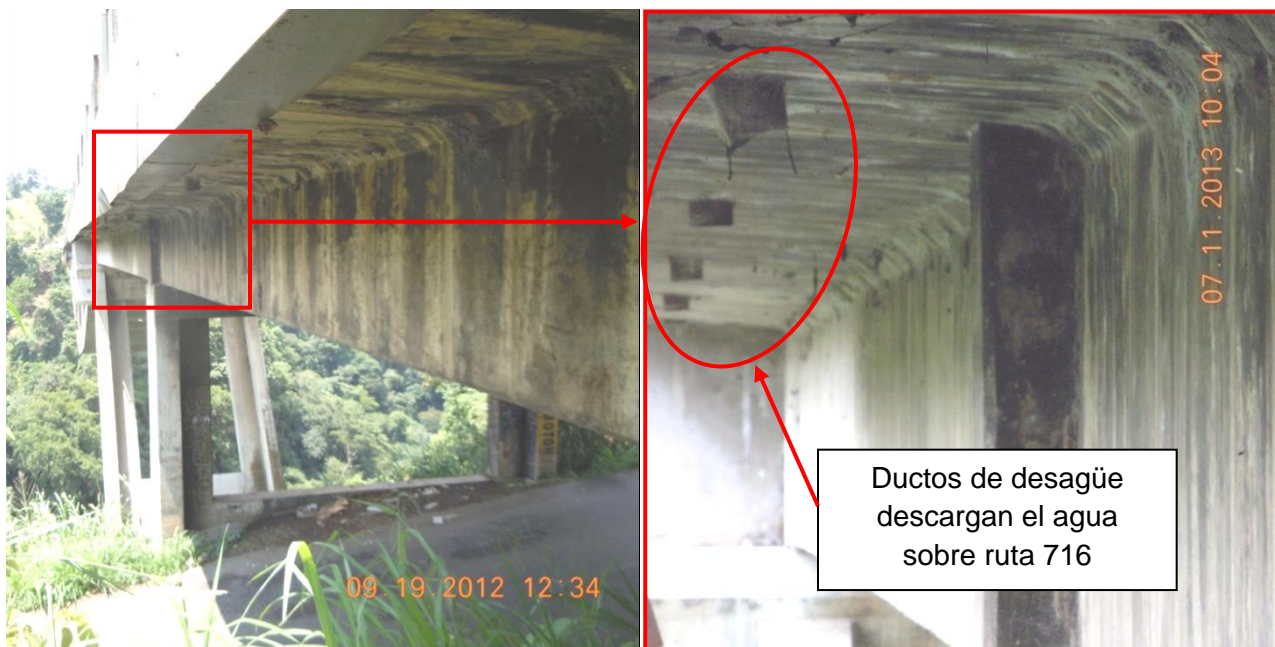
Figura 6: Ductos de desagüe sin tubos extensión y descargan sobre la ruta 716 que pasa bajo el puente.
