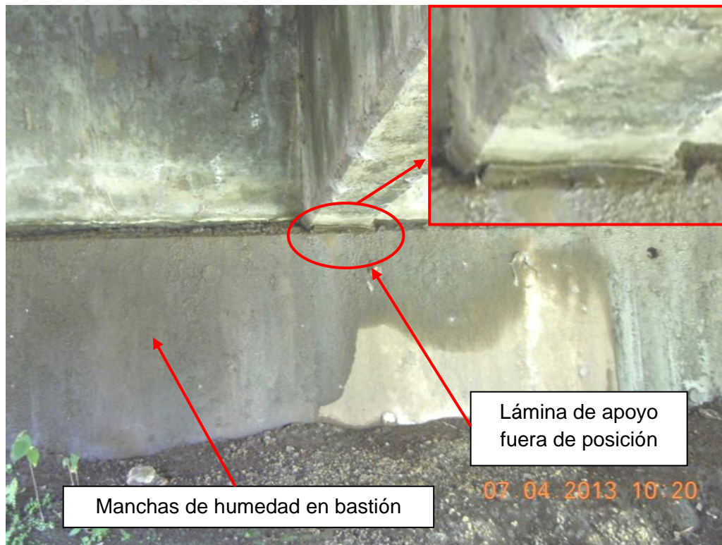
Figura 26: Lámina de apoyo fuera de posición y humedad en el bastión 1.
