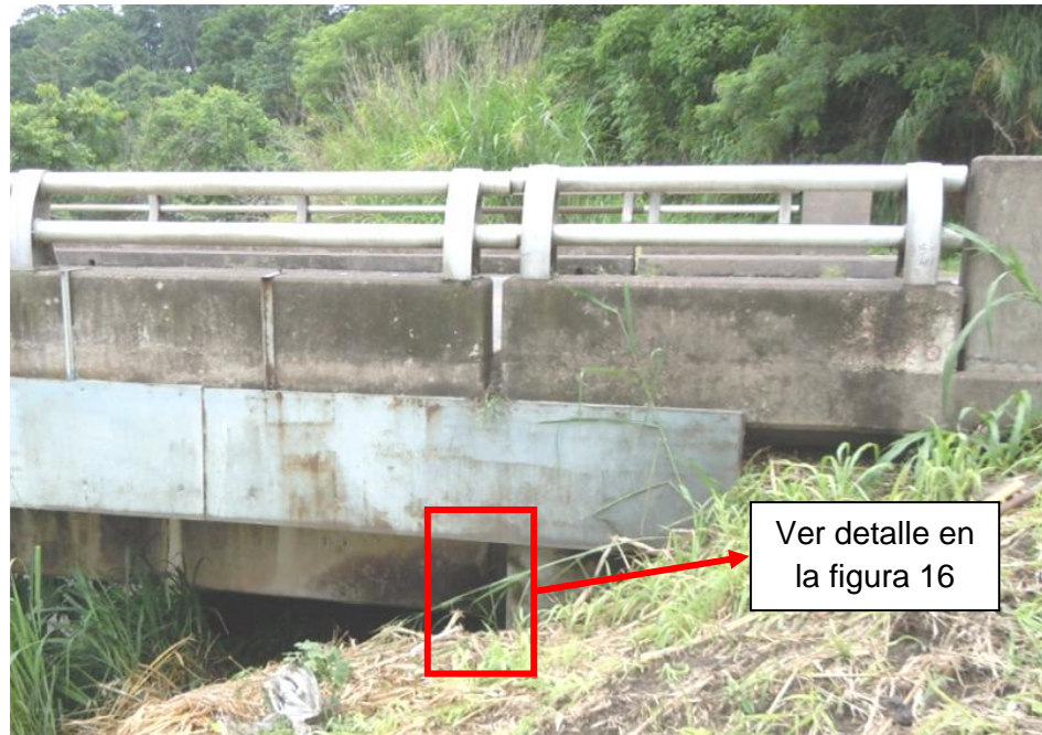
Figura 15: Ubicación de daños en la viga principal externa-oeste del bastión 2.
