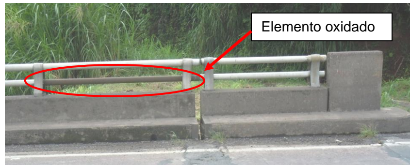
a) Barrera vehicular del lado-Este, acceso 2
