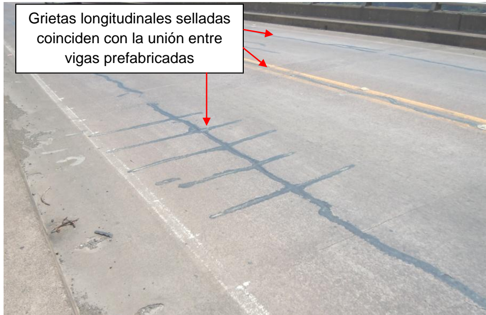
Figura 11: Grieta longitudinal que coinciden con la unión entre vigas principales prefabricadas la cuales fueron selladas en la superficie superior de la losa.
