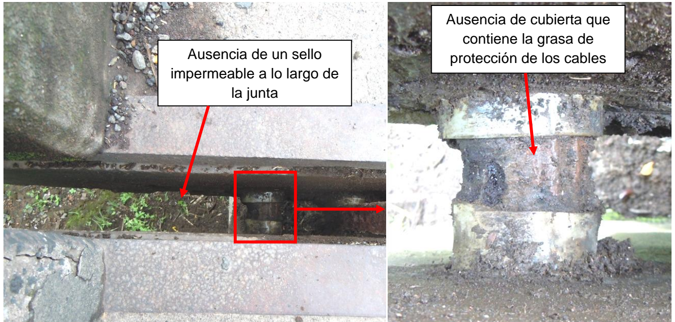
Figura 23: Ducto con cables descubiertos y oxidación del cable, vista a través de la junta de expansión del acceso 1 sobre el bordillo del lado Este.
