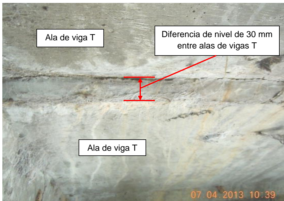
Figura 14: Detalle de diferencia de nivel típico entre vigas T longitudinales.
