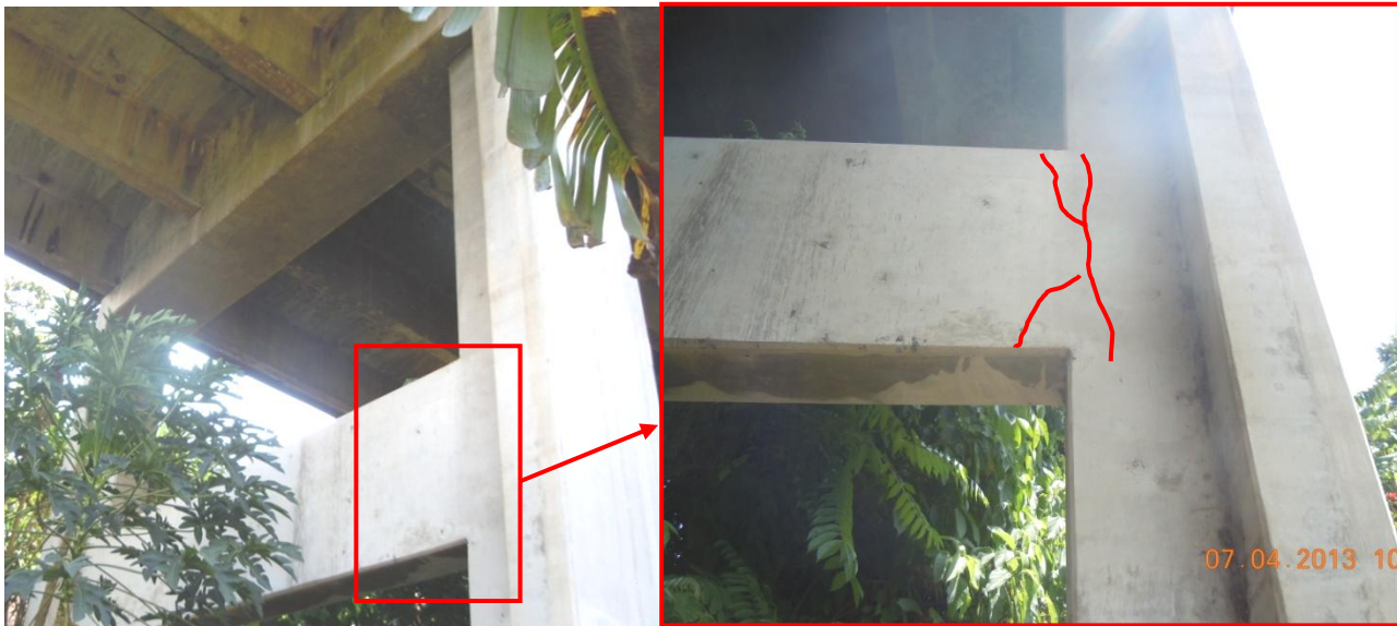
Figura 27: Grietas en la viga de unión entre columnas de la pila vertical No 1. (típico)
