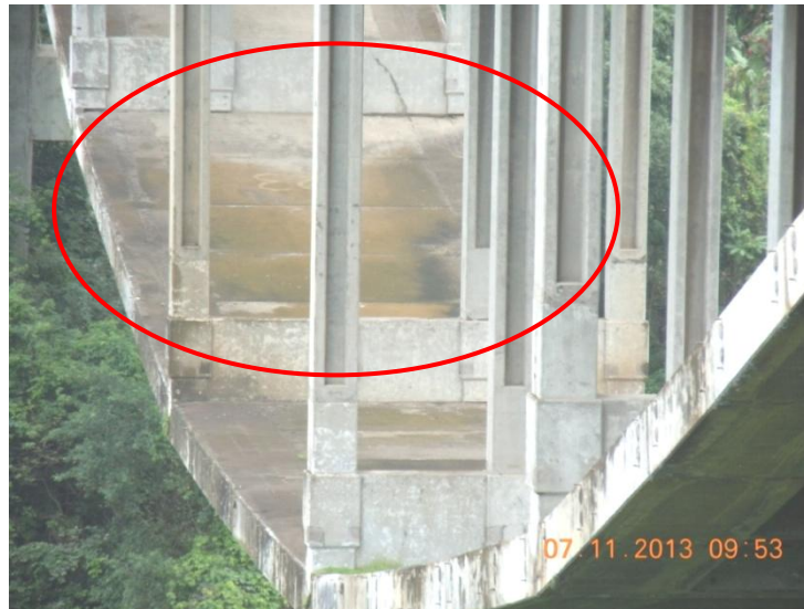
Figura 7: Manchas de humedad en los paneles prefabricados del arco invertido producto de la descarga de agua por los desagües del puente.
