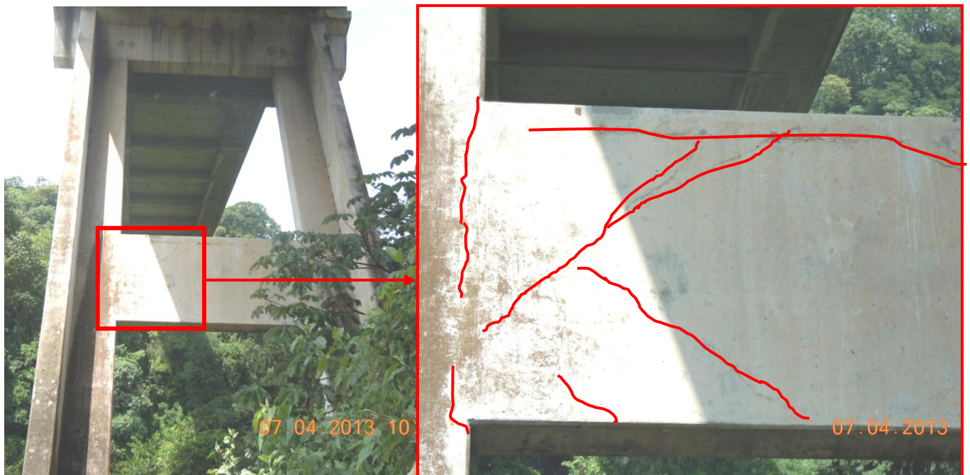
Figura 28: Grietas en la viga de unión entre columnas de la pila inclinada No 1 (típico).
