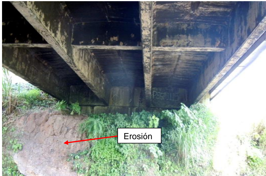
Figura 29: Erosión en el talud frente al bastión 2.
