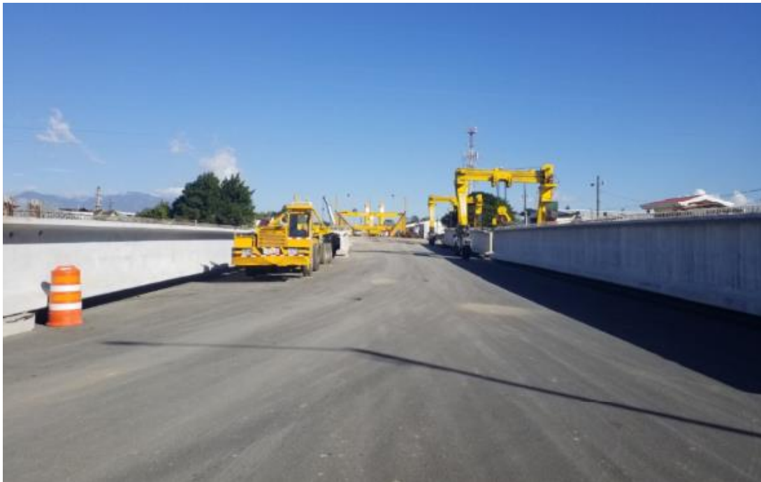
Fotografía 25: Almacenamiento de vigas del viaducto en proceso de construcción. Estacionamiento aproximado: 1+650. Fecha: 14 de enero de 2019. Fuente: LanammeUCR.
