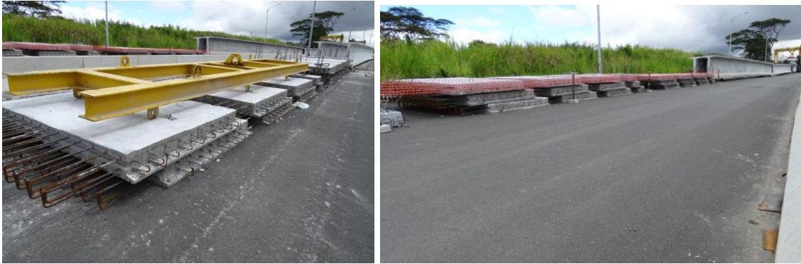
Fotografía 27: Almacenamiento de losas del viaducto en proceso de construcción. Estacionamiento aproximado: 1+400. Fecha: 3 de diciembre de 2019. Fuente: LanammeUCR.
