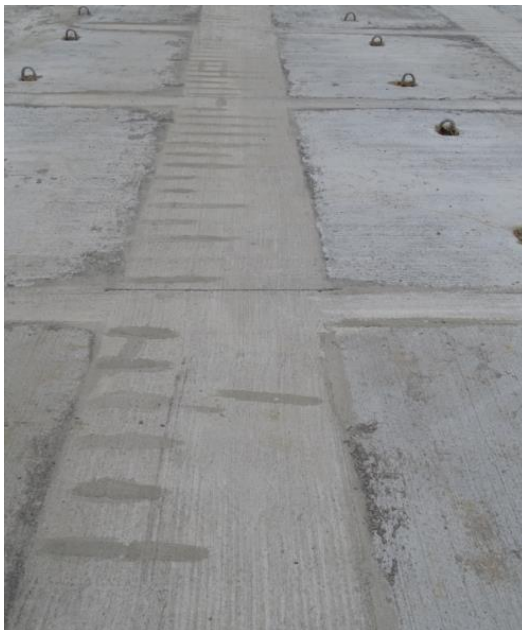
Fotografía 7: Agrietamiento y aparentes reparaciones del concreto de uniones de losa prefabricada. Junta de Tablero 23. Viaducto Unidad Funcional 3. Fecha: 5 de mayo de 2020. Fuente: LanammeUCR.
