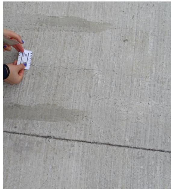
Fotografía 7: Agrietamiento y aparentes reparaciones del concreto de uniones de losa prefabricada. Junta de Tablero 23. Viaducto Unidad Funcional 3. Fecha: 5 de mayo de 2020. Fuente: LanammeUCR.
