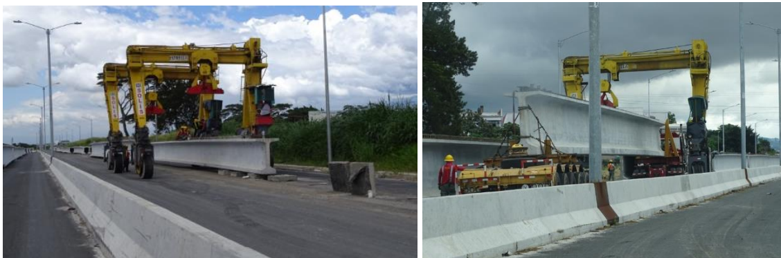
Fotografía 26: Maniobras de colocación de vigas sobre el pavimento construido. Estacionamiento aproximado: 1+600. Fecha: 18 de octubre y 3 de diciembre de 2019. Fuente: LanammeUCR.
