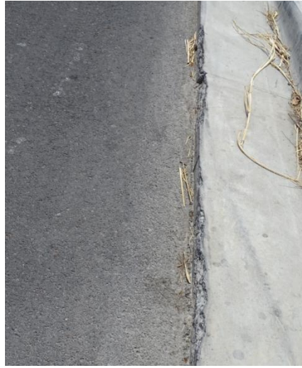
Fotografía 31: Deterioro en los bordes de las cunetas construidas en la Unidad Funcional 2B. Estacionamiento aproximado: 1+500. Fecha: 15 de abril de 2020. Fuente: LanammeUCR.
