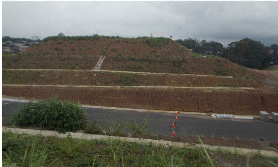
Fotografía 32: Relleno construido al lado de la Radial a Heredia. Se observa la vegetación y el sistema de conducción de agua parcialmente construido. Fecha 10 de agosto de 2018. Fuente: LanammeUCR
