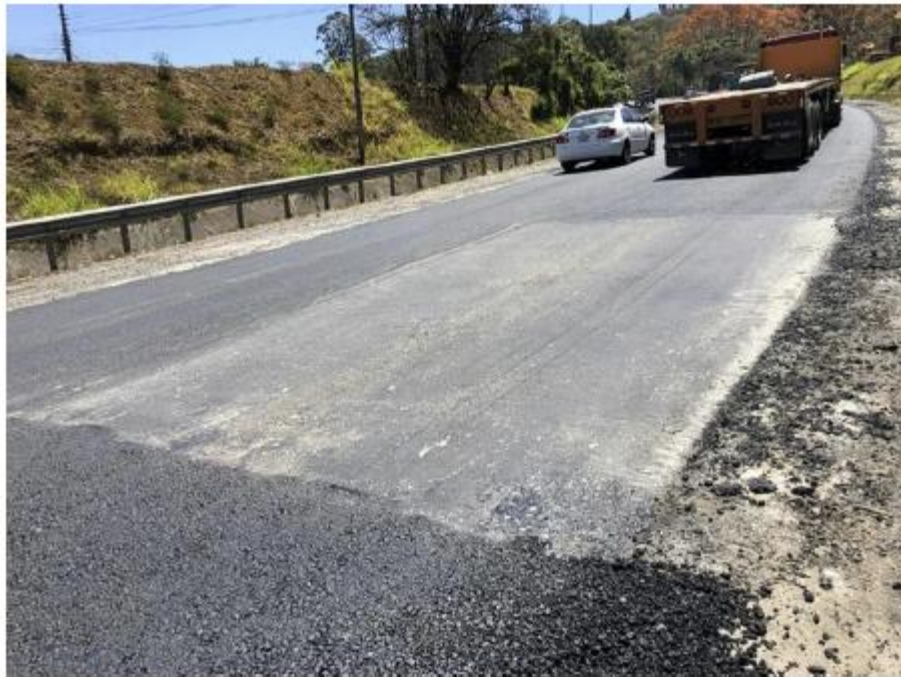
Fotografía 1: Primera etapa del proyecto, sustitución de losas.
