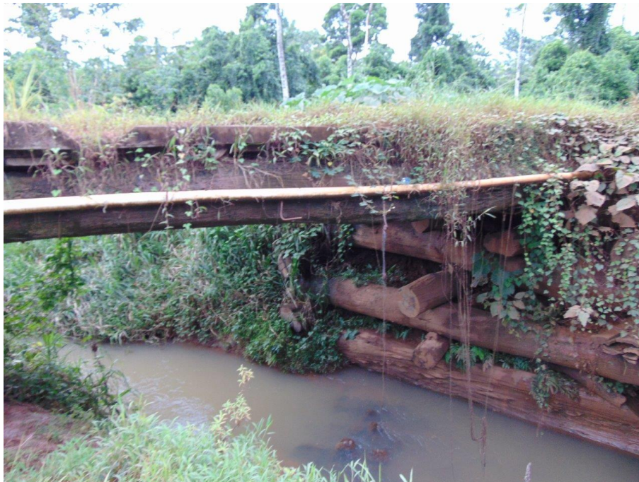
Figura A6.1. Vista del bastión de troncos del puente sobre la quebrada sin Nombre en la Ruta Nacional No. 761 (Fotografía del SAEP, MOPT, 2019).
