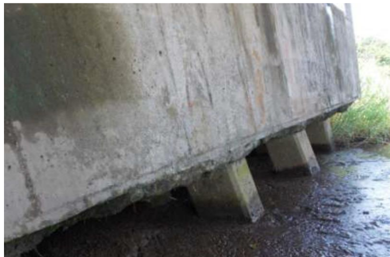
Figura 2.10. Puente sobre el río Vizcaya en la Ruta Nacional No.36, el cual fue calificado con un valor de 5 por socavación, pero la severidad del daño debería permitir corregir la deficiencia por medio de una intervención de conservación basada en la condición en el corto plazo (Fotografía tomada de Villalobos-Vega et al, 2018).
