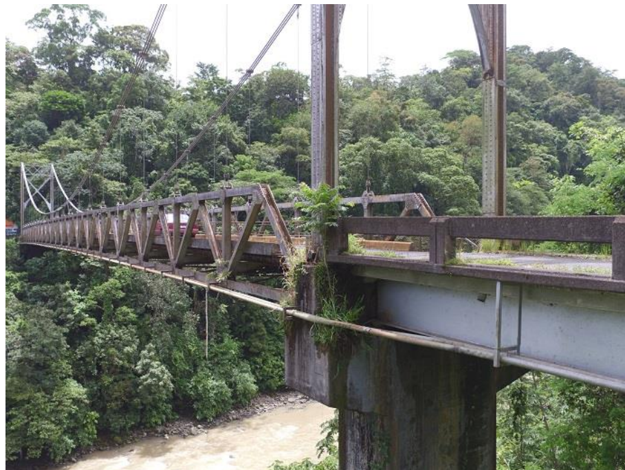
Figura C. Vista lateral (costado aguas abajo)
