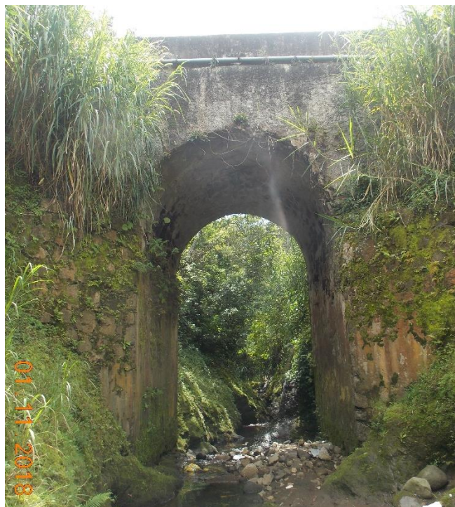
Figura C. Vista lateral costado oeste.
