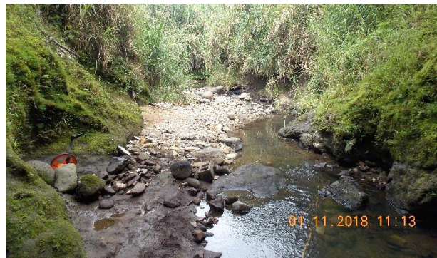
Figura 5.5(a). Cauce del río aguas arriba del puente.
