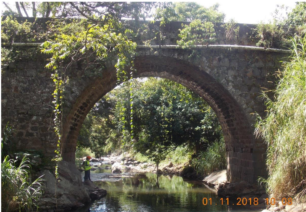
Figura C. Vista lateral costado aguas arriba del puente.
