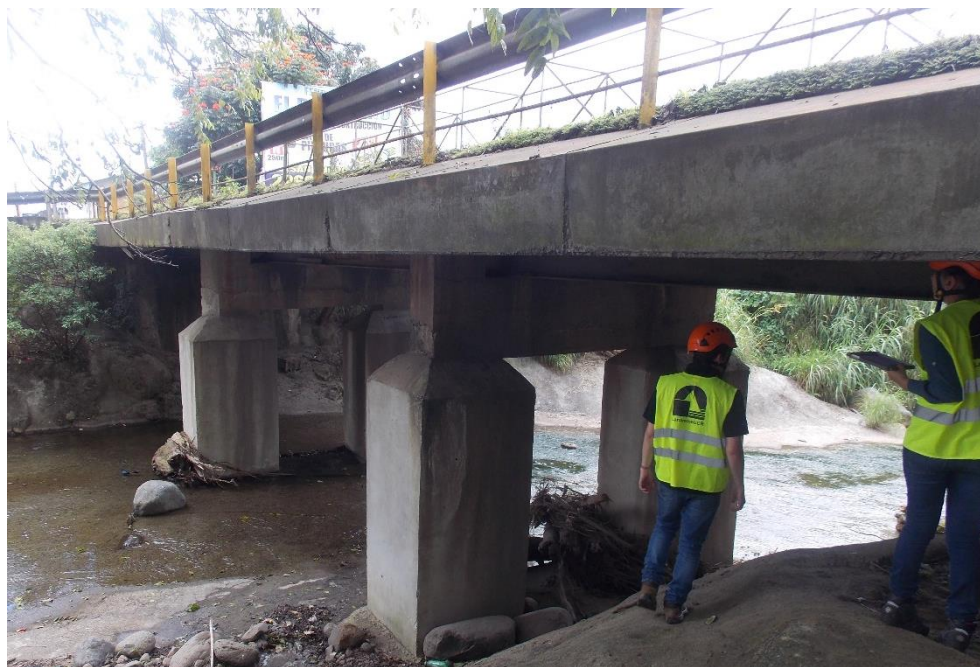
Figura C. Vista lateral (costado aguas arriba).
