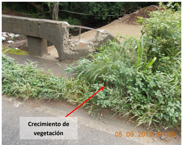
Figura 1.4(b). Crecimiento de vegetación frente a pretil rígido (acceso 2, aguas abajo).
