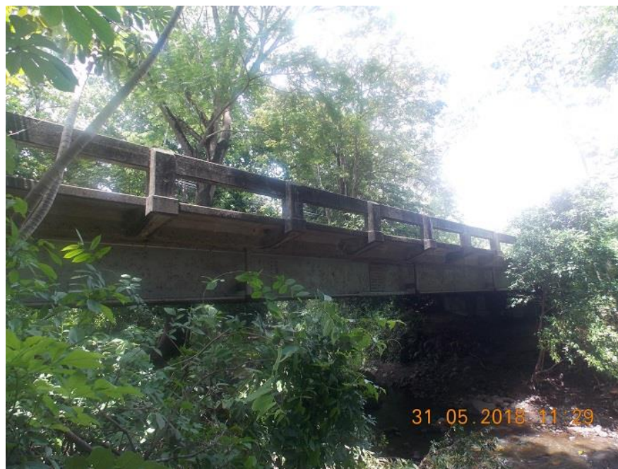
Figura C. Vista lateral (costado aguas abajo).
