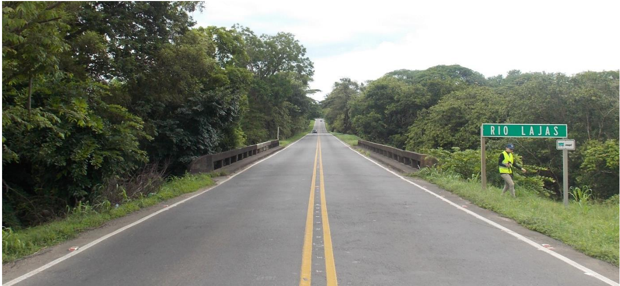
Figura B. Vista a lo largo de la línea de centro (acceso 2 desde Cañas).
