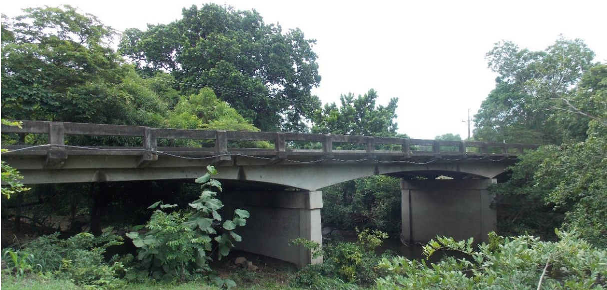
Figura C. Vista lateral (costado aguas abajo).
