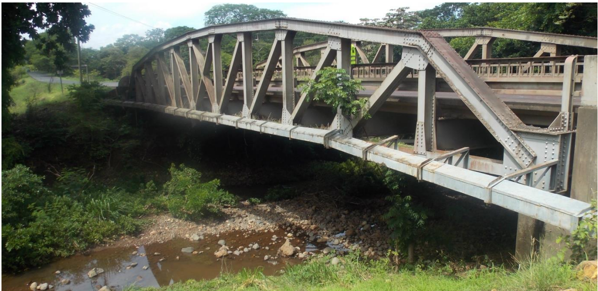
Figura C. Vista lateral (costado aguas arriba).
