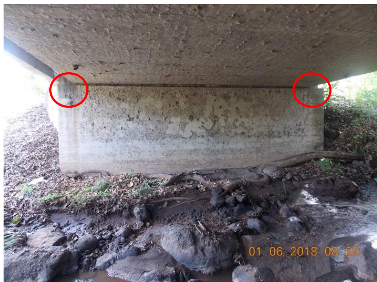
Figura 2.3(b). Descarga de agua en bastión 2.
