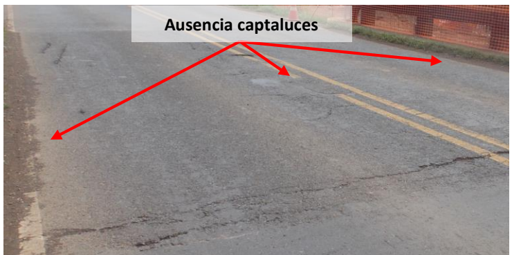
Figura 1.4(b). Ausencia de captaluces en los laterales y línea de centro.
