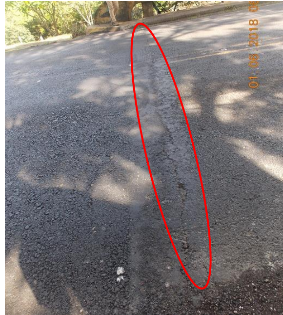
Figura 2.3(a). Obstrucción de junta de expansión sobre bastión 1.
