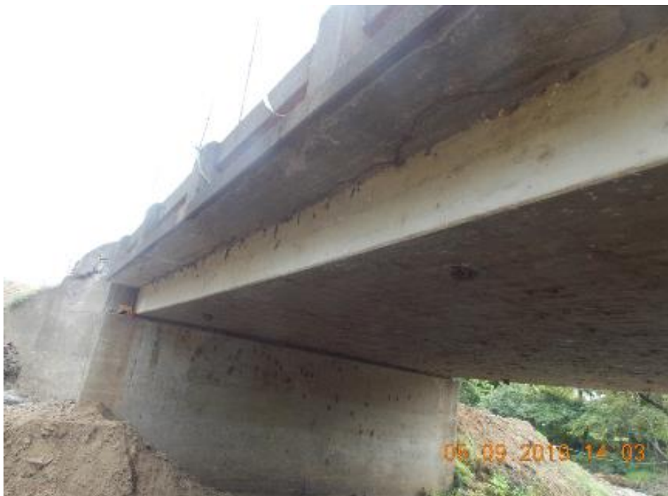
Figura C. Vista lateral (costado aguas arriba).
