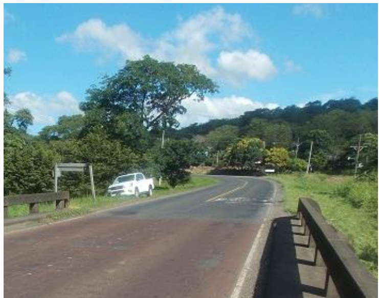
Figura 1.2(b). Vista hacia Cañas (acceso 2) en donde se observa la sección curva de la carretera.
