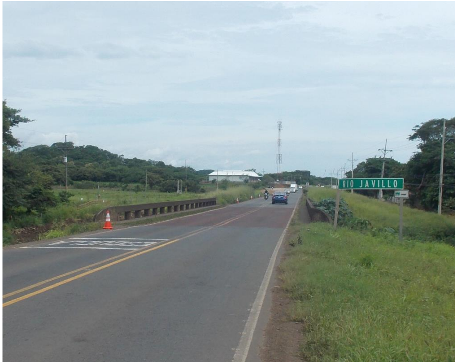
Figura B. Vista a lo largo de la línea de centro (vista hacia Limonal).
