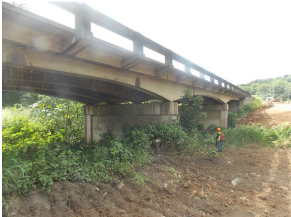
Figura C. Vista lateral (costado aguas abajo).
