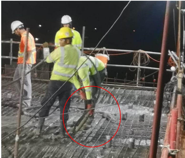
Fotografía 5. Colocación de concreto en “Losa de dovela 0” del proyecto. Fecha 10 de diciembre de 2019. Fuente: LanammeUCR.
