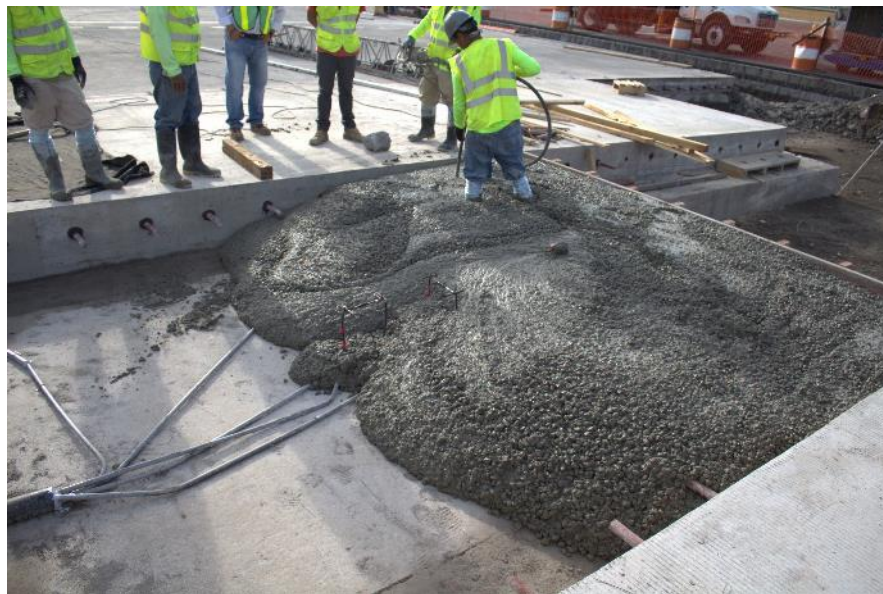
Figura 9. Colado de la losa de concreto
