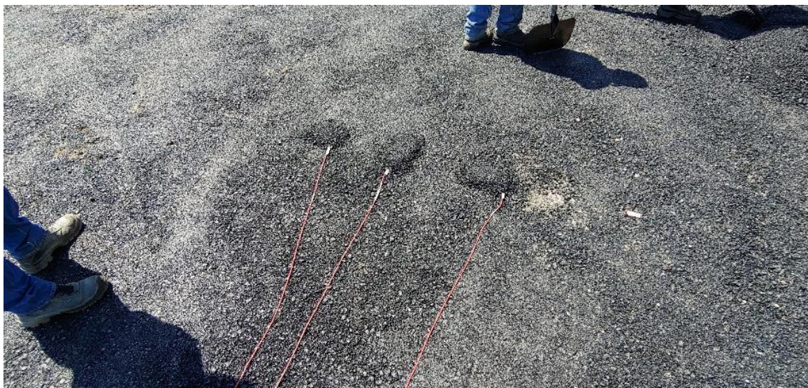
Figura 17. Protección de las galgas, con mezclas fina, tamizada en sitio previo a la colocación de la mezcla asfáltica
