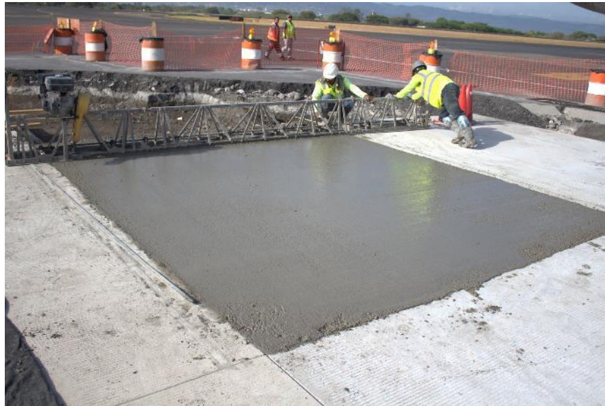
Figura 10. Losa de concreto finalizada
