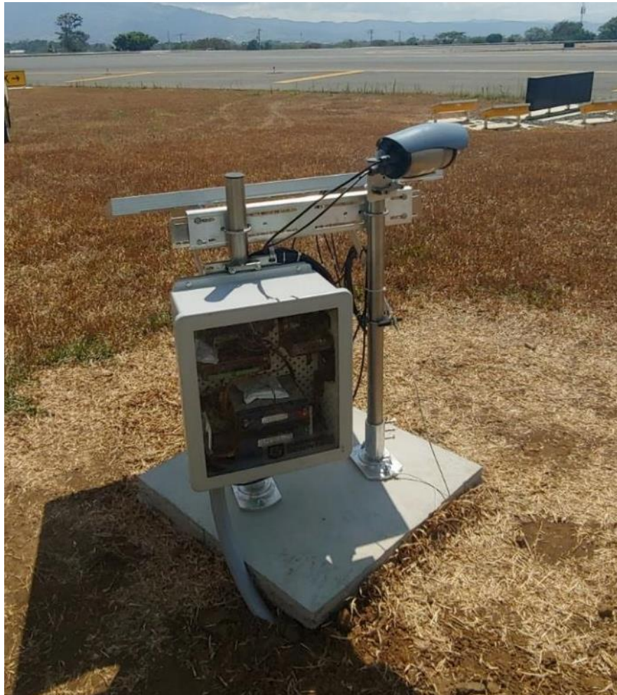
Figura 22. Sistema de adquisición de datos remoto, ubicado en el conector bravo del AIJS
