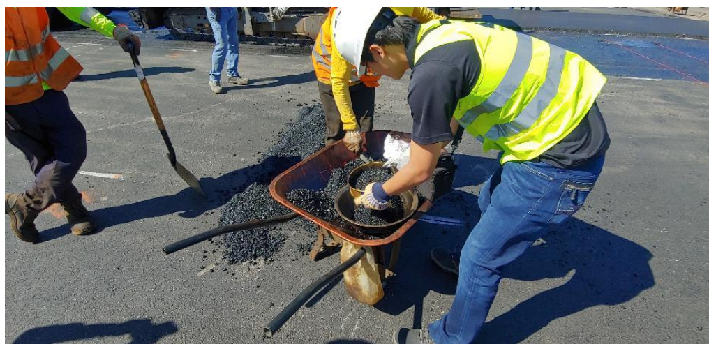
Figura 15. Tamizaje de mezcla caliente, para protección de galgas extensiométricas en mezcla asfáltica
