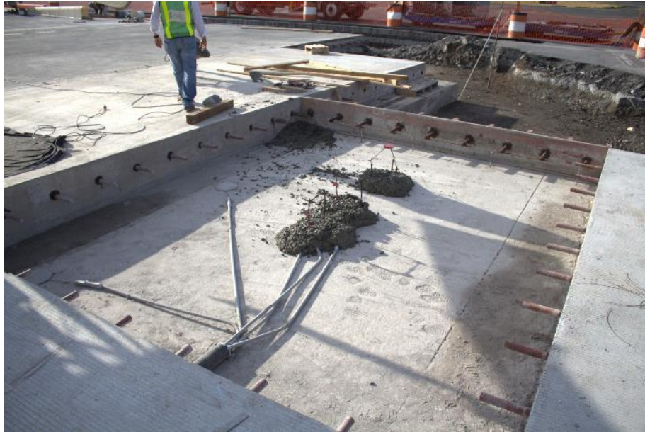
Figura 8. Protección de instrumentación con concreto (fresco) colocado de forma manual antes de la colada
